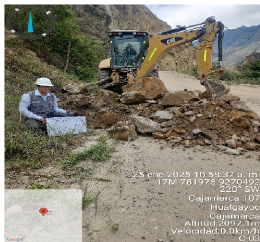
Fotografía N° 3. Excavación de la Calicata C-03 y muestreo de suelos
