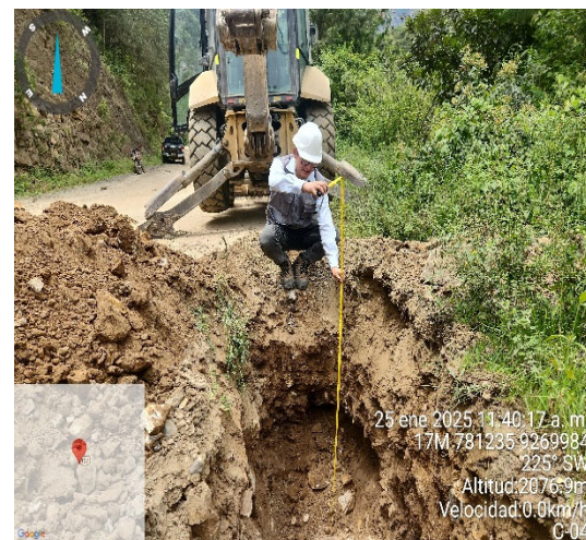
Fotografía N° 4. Excavación de la Calicata C-04 y muestreo de suelos
