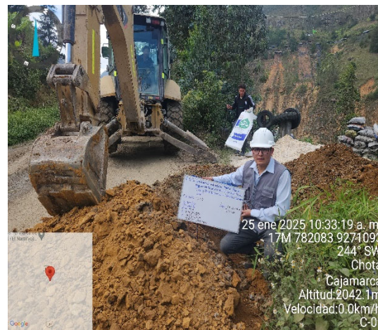
Fotografía N° 2. Excavación de la Calicata C-02 y muestreo de suelos
