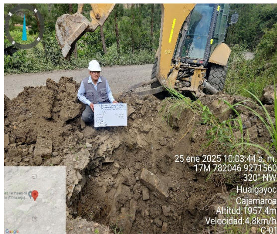
Fotografía N° 1. Excavación de la Calicata C-01 y muestreo de suelos
