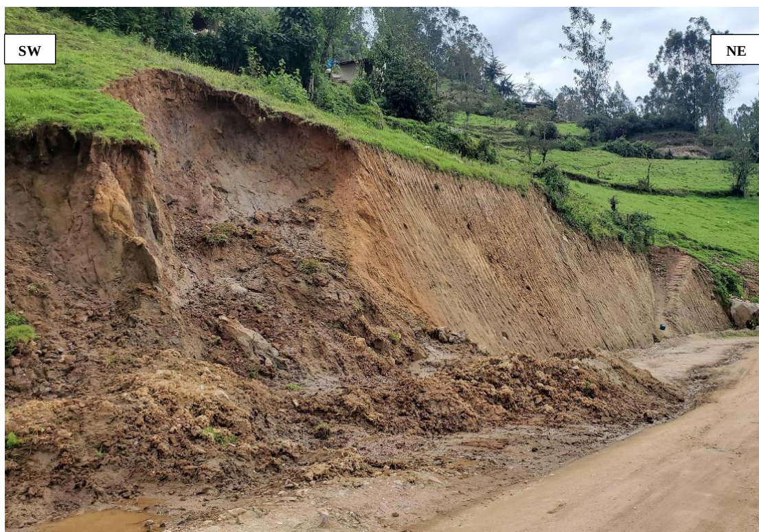
Fotografía 21: Deslizamiento en la cara del talud en el Km 05+850
