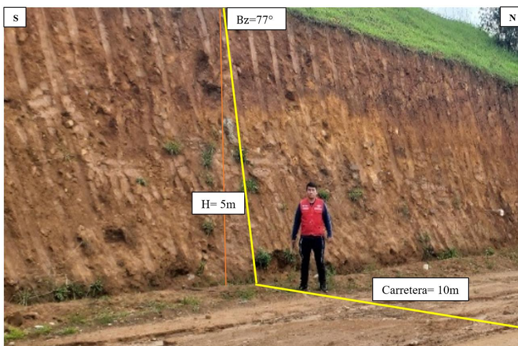
Fotografía 19: Talud 11 en la progresiva 06+500
