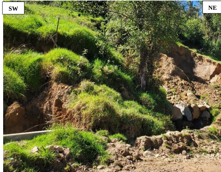
Fotografía 7: Vista de una ladera en el Km 05+400
