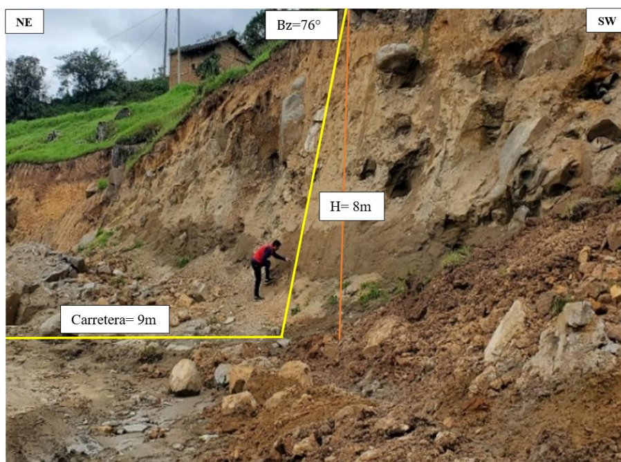
Fotografía 13: Talud 05 en la progresiva 03+500
