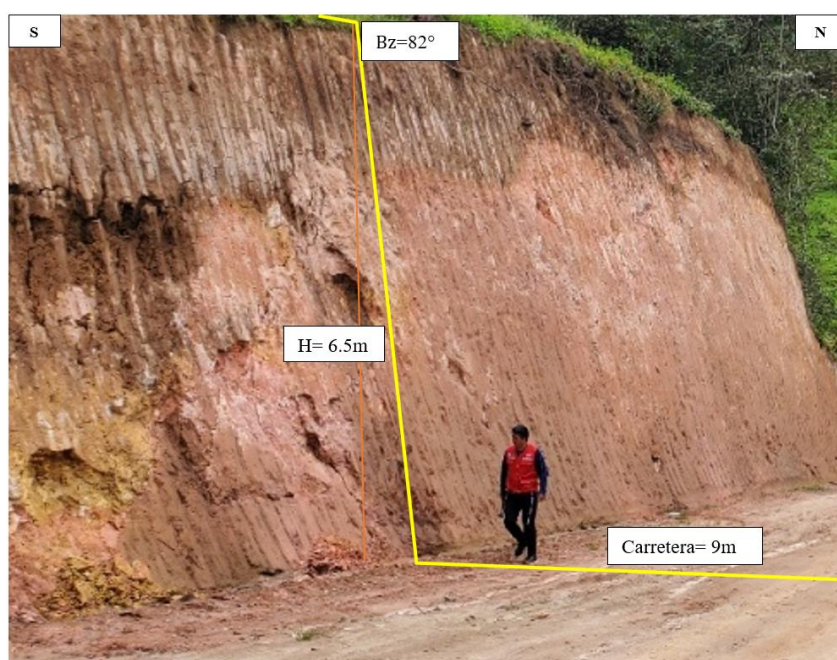
Fotografía 17: Talud 09 en la progresiva 05+500
