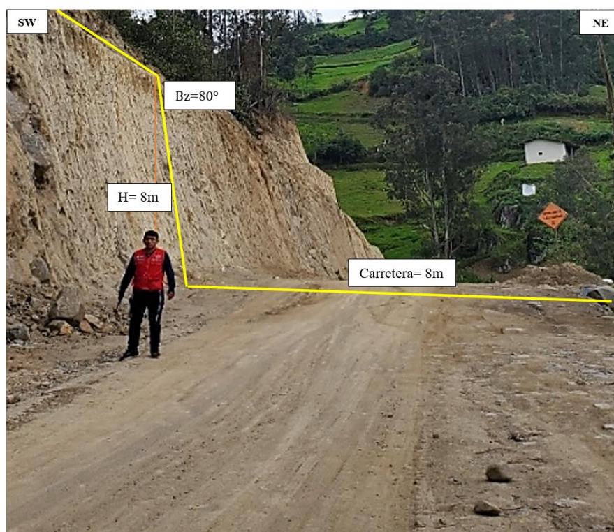
Fotografía 12: Talud 04 en la progresiva 03+000
