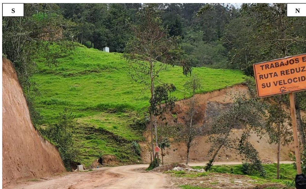
Fotografía 6: Vista de una lomada en el Km 04+800
