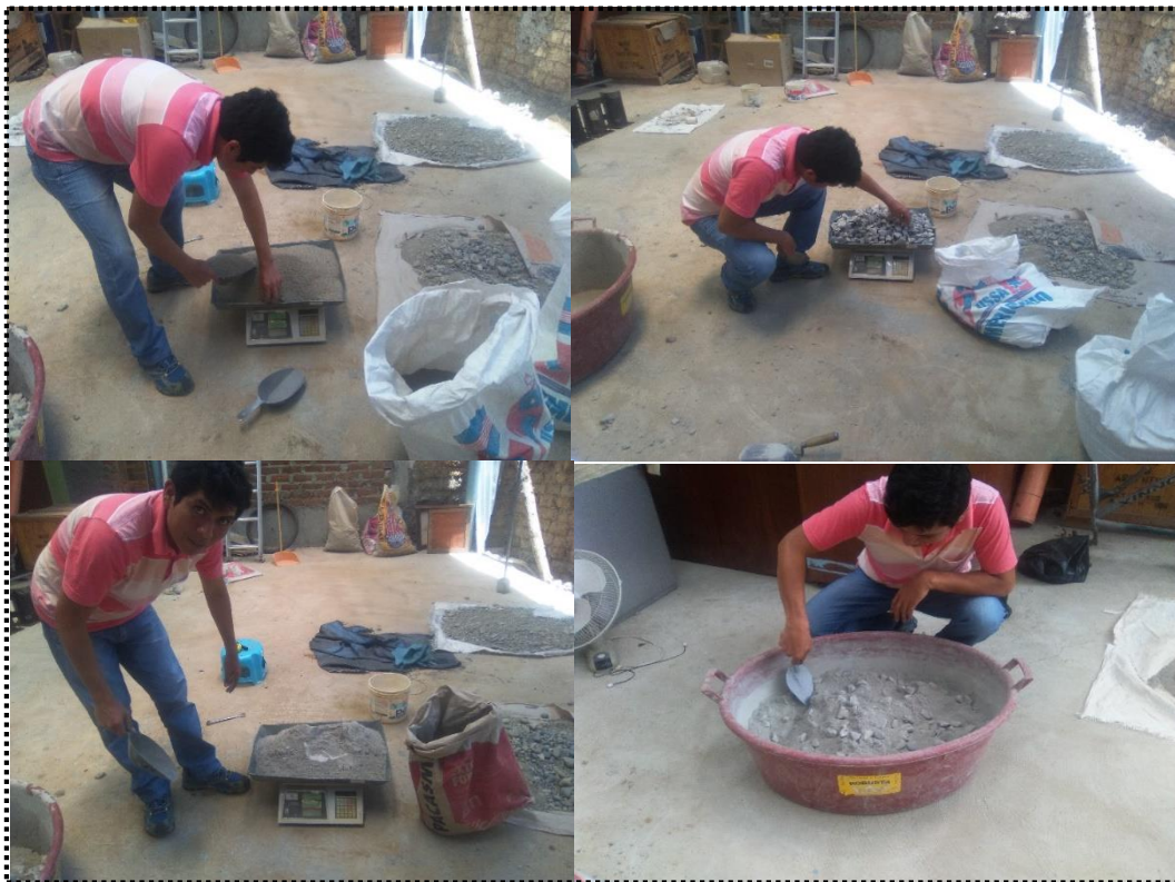
Imagen N° 15: Pesando, mezclando los agregados y el cemento.
