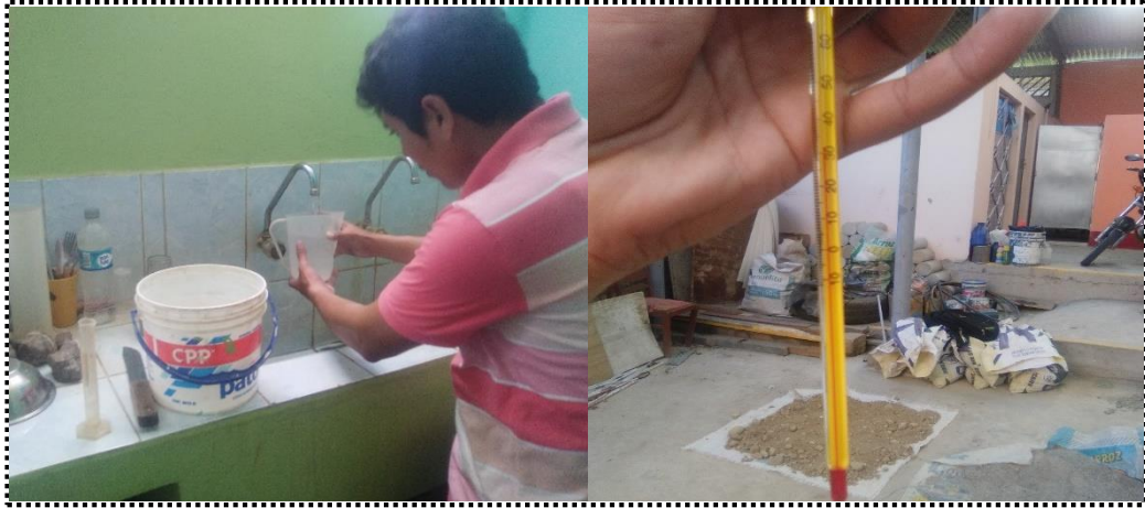
Imagen N° 16: Midiendo el agua para la mezcla y medición de la temperatura ambiente.
