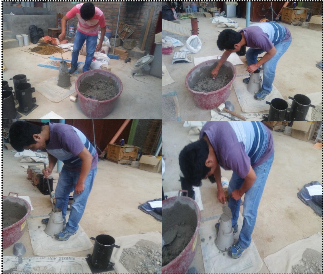
Imagen N° 19: Medición del Slump (asentamiento) mediante el cono de Abrams, del concreto fresco de cada tanda de mezclado.
