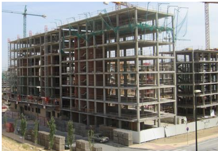
Figura 24. Edificio construido con sistema estructural de pórticos.
