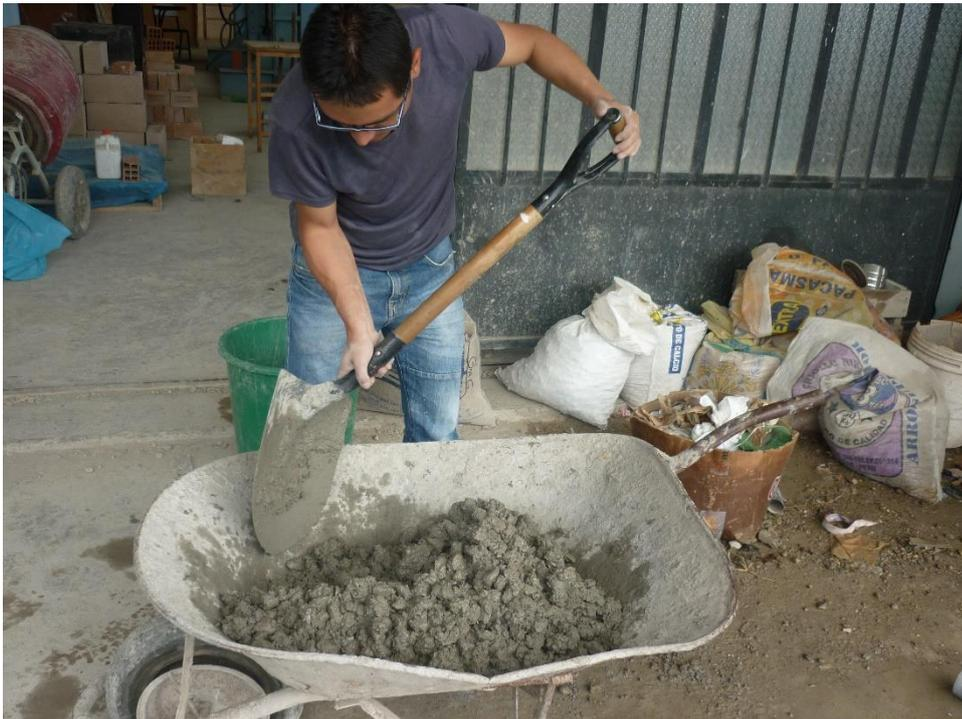
**Fotografía 08: Mezclado manual del concreto**
