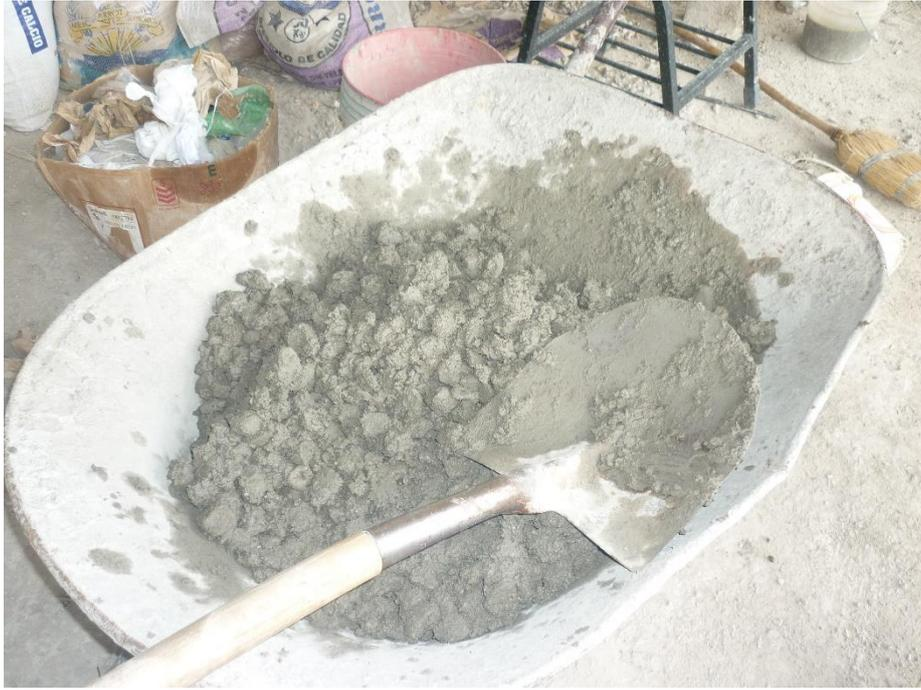
**Fotografía 5: Inicio del diseño de mezcla para un Slum = 0''**
