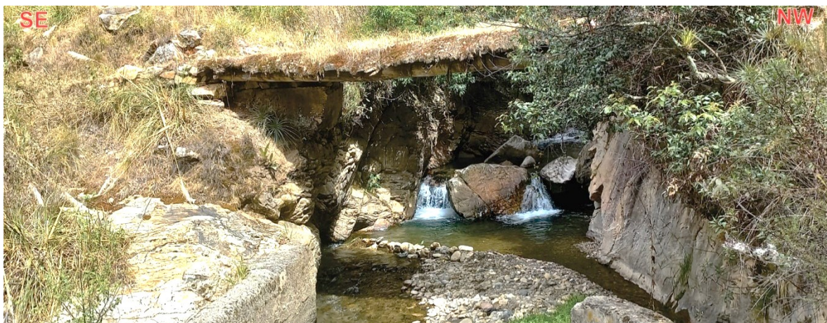
Foto 25. Cauce activo perteneciente a la quebrada Quinual.
