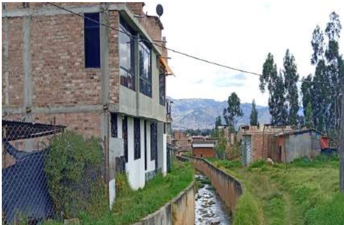
Figura 24.-Casas construidas con concreto, en la franja marginal de la quebrada Tingomayo.
