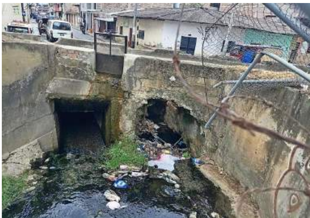
Figura 15.- Orificios de ingreso de dos alcantarillas que pasan al largo del Jr. Sinchi Roca en la progresiva 3+740 Km.
