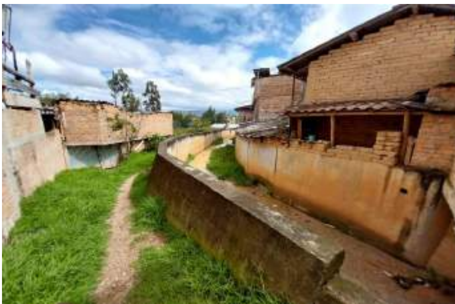
Figura 13.- Se aprecia a la derecha de la quebrada con colindantes con casas.
