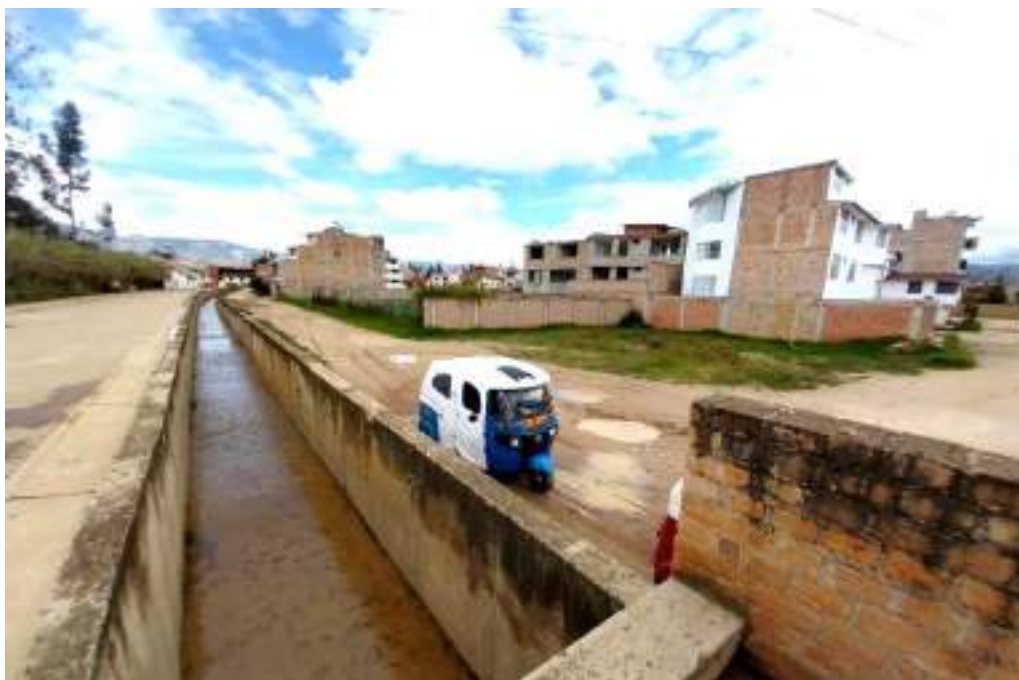
Figura 14.- En la margen derecha se ubica la urbanización Laguna seca.
