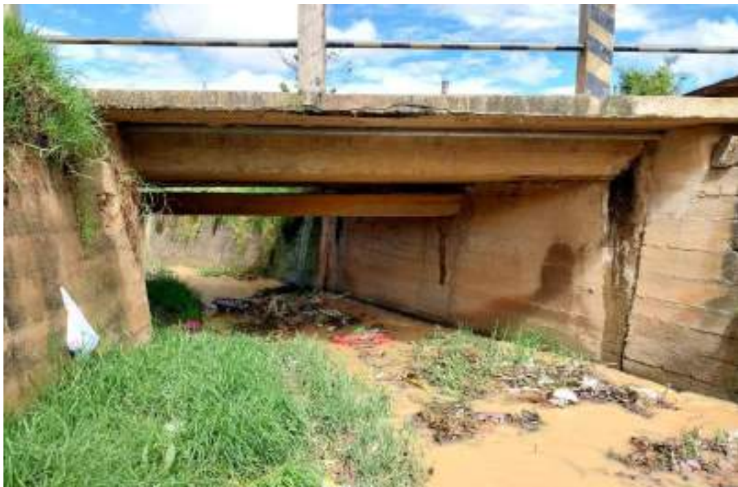
Figura 11.- Canalización de quebrada Tingomayo en la progresiva 2+165 Km.
