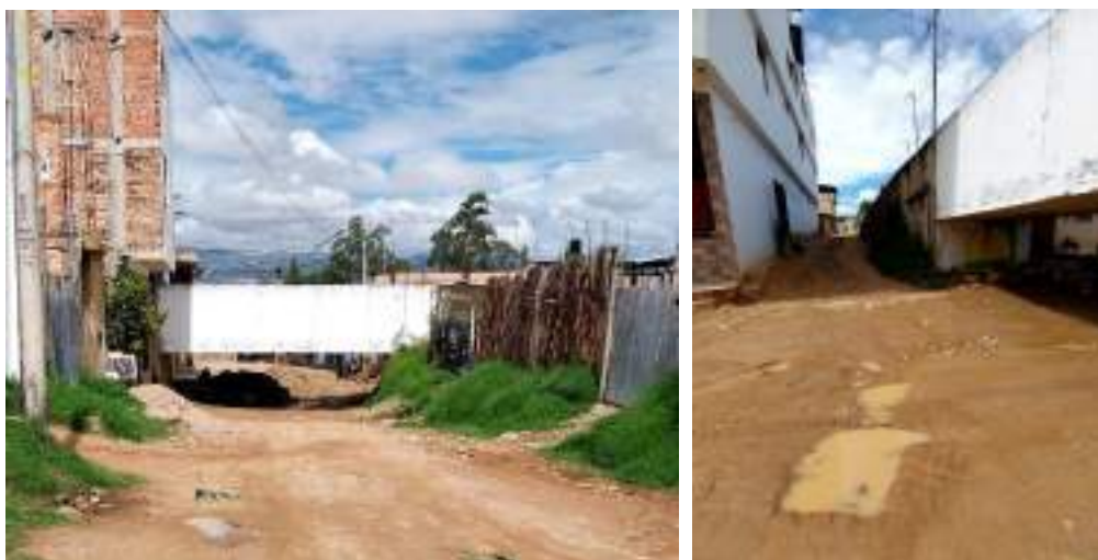
Figura 20.- Intersección de canalización en el Jr. El sol.
