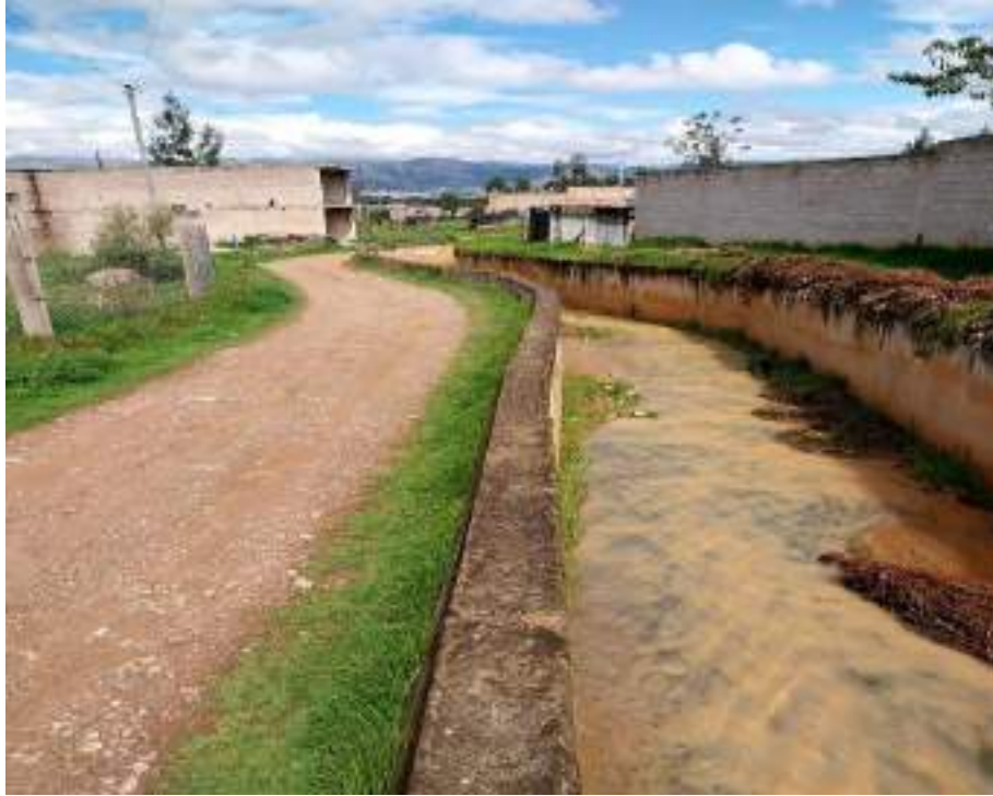
Figura 12.-Margen izquierda de la quebrada Tingomayo. Observamos una carretera desde las progresivas 2+165 hasta la 2+490 Km.
