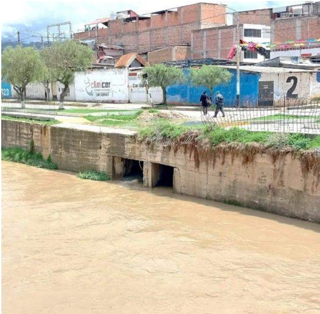
Figura 16.- orificios de evacuación de agua de la quebrada Tingomayo hacia el río Chonta.
