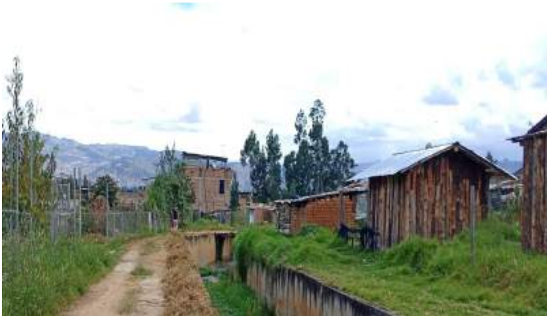
Figura 22.- Casas de concreto con un margen de un aproximado de 3 metros y casas aledañas de diferentes materiales.
