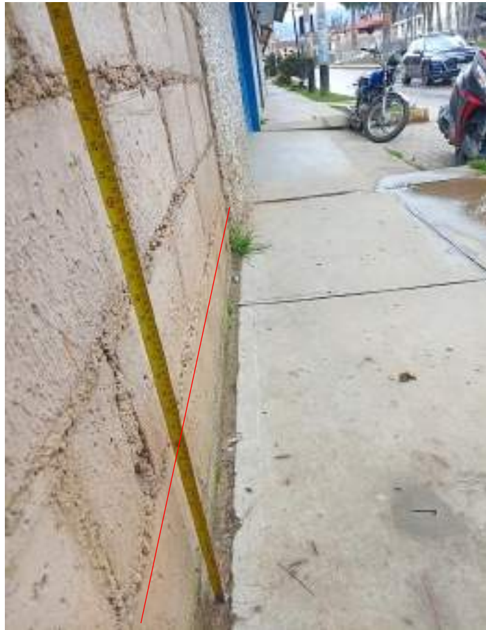
Figura 71.-Se mide la distancia de 33 cm entre la vereda y la huella hídrica.
