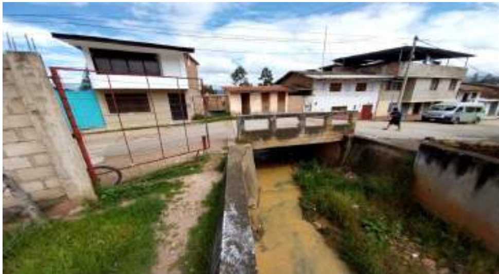
Figura 19.- Vista panorámica del puente El Cruce, y parte del Jr. Los Eucaliptos.
