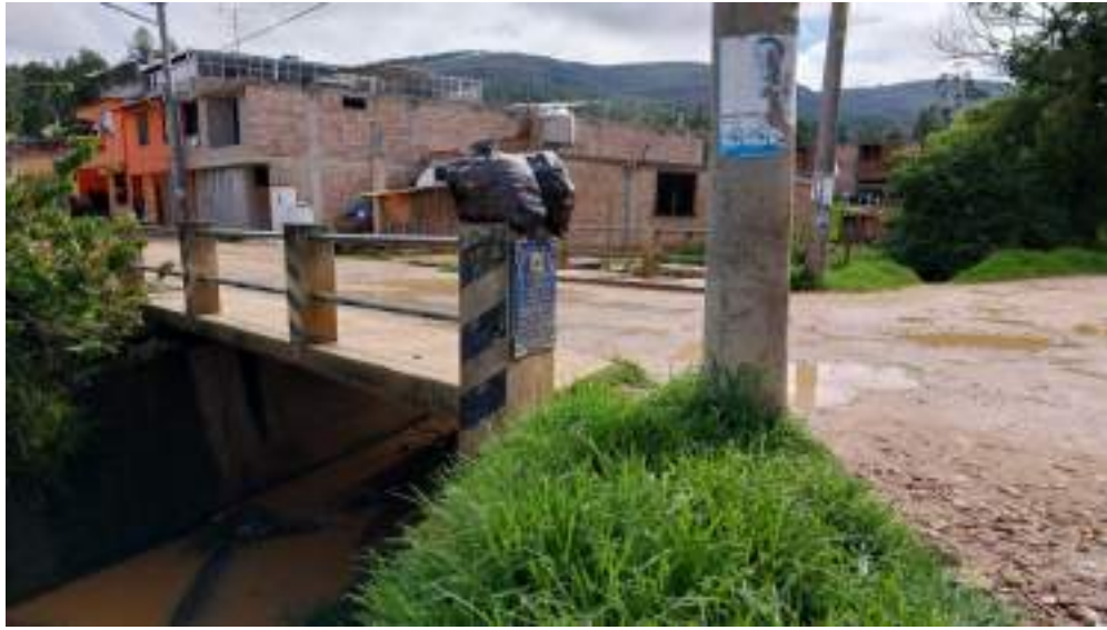
Figura 18.- Vista panorámica del Puente El Reloj.
