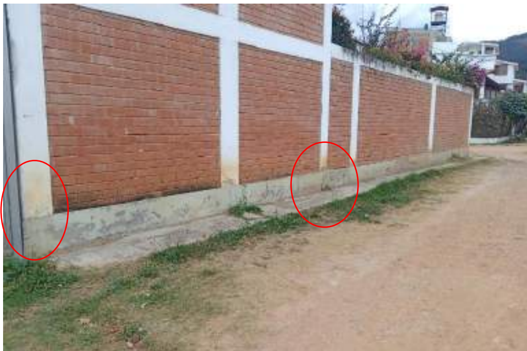
Figura 74.- Se visualiza la huella hídrica en las columnas de color blanco en la calle El Mutuy con la intersección con la calle El Molle.
