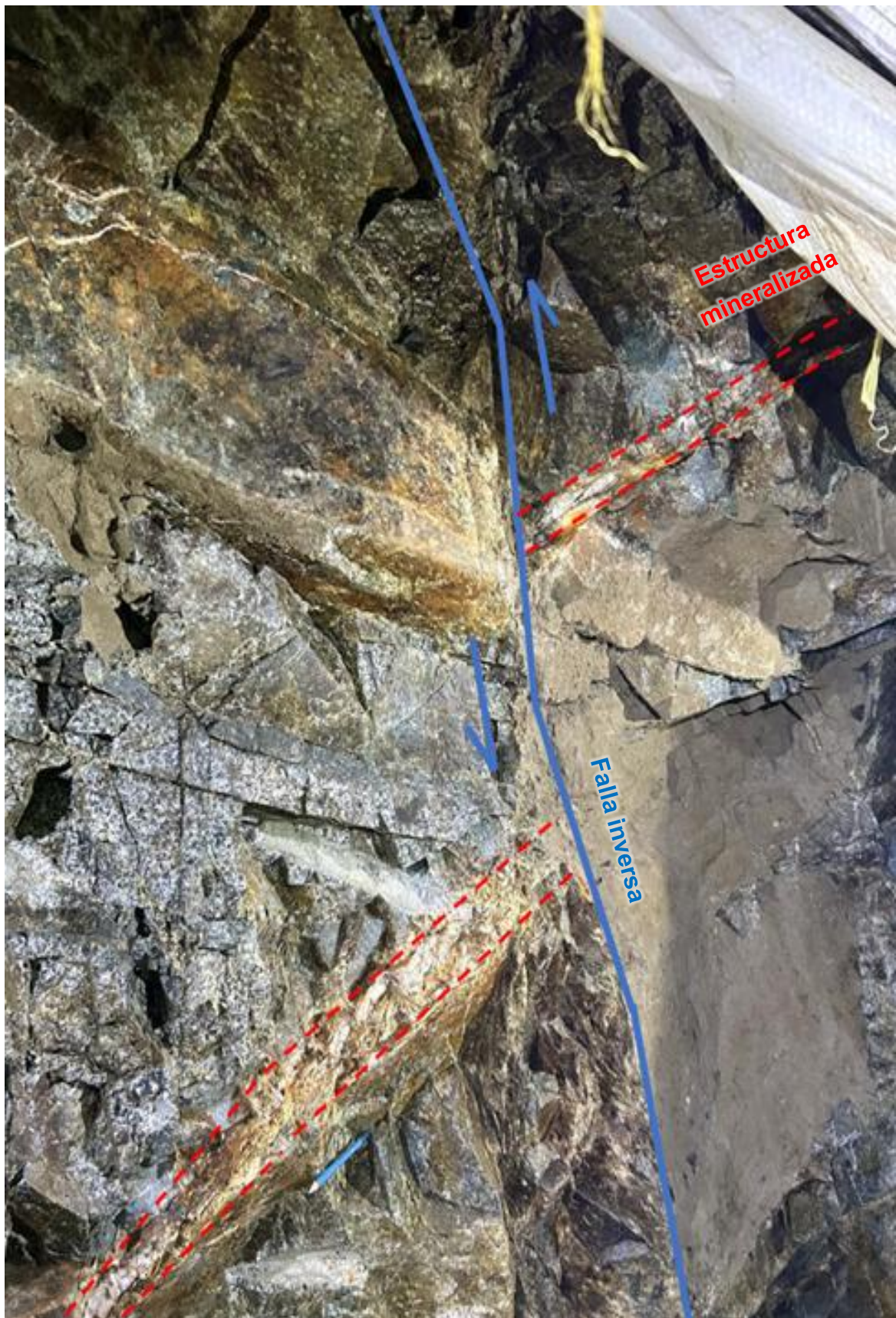
Fotografía 2. Desplazamiento de 40 cm de la Veta Mercedes (rojo) afectada por una falla inversa de alto ángulo.
