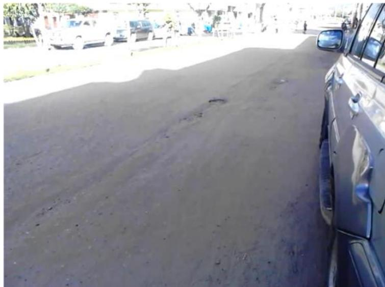
Fot. 25 Unidad de muestra 7. Se observan baches y peladura por intemperismo y desprendimiento de agregados.
