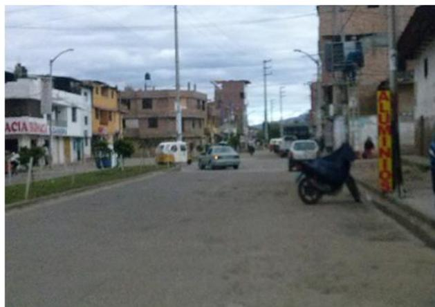
Fot. 26 Unidad de muestra 8. Se observan baches y peladura por intemperismo y desprendimiento de agregados.
