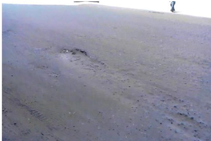
Fot. 24 Unidad de muestra 6. Se observan baches y peladura por intemperismo y desprendimiento de agregados.
