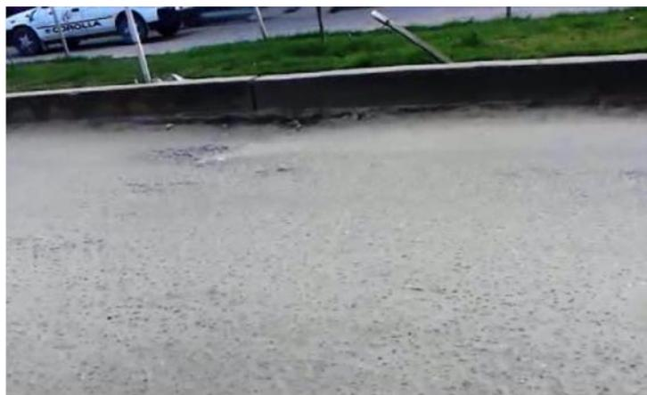
Fot. 29 Unidad de muestra 12. En esta unidad de muestreo se observaron baches, peladura por intemperismo y desprendimiento de agregados, depresión y fisuras longitudinales.
