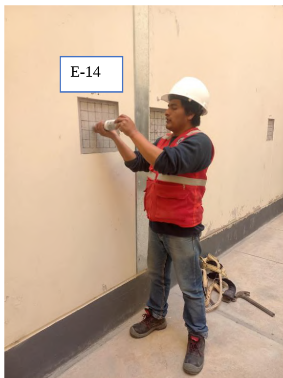
Ensayo de esclerometría en placa muestra E-14
