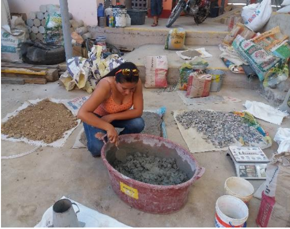
Imagen 30. BATIDO MANUAL DE MEZCLA
