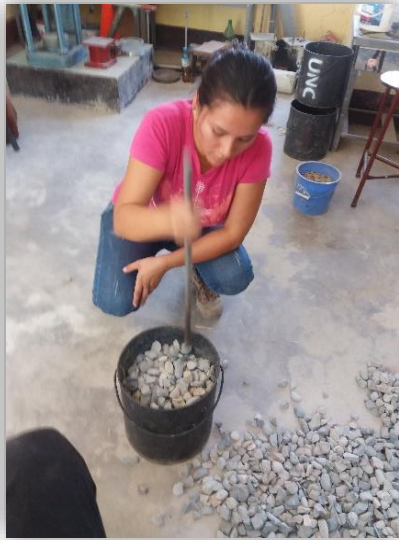
Imagen 11. COMPACTADO DE MUESTRA
