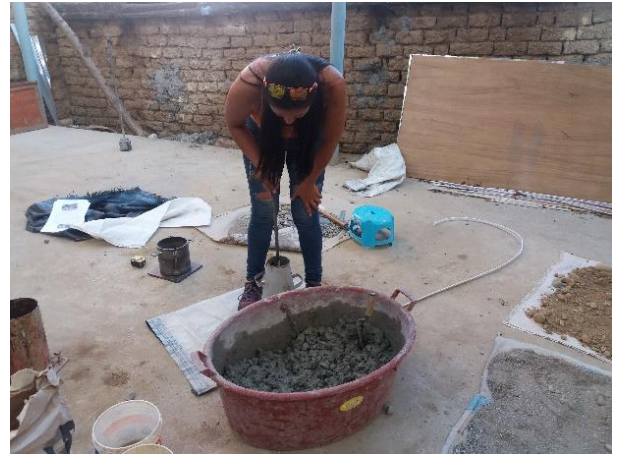
Imagen 33. COMPACTADO DE LA MEZCLA EN EL CONO DE ABRAMS
