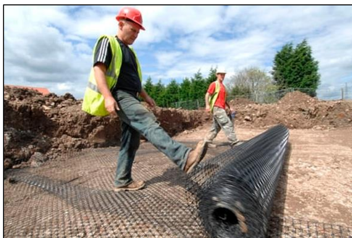
Figura 10. Instalación de la geomalla (TENSAR, 2013).
