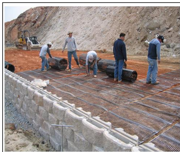
Figura 7. Geomalla uniaxial (TENSAR, 2013).
