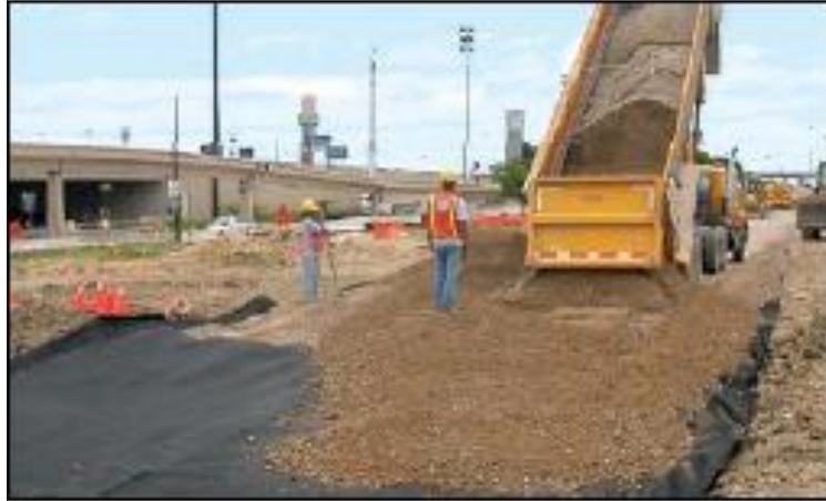
Figura 11. Riego de material de afirmado (Cruz, 2013).
