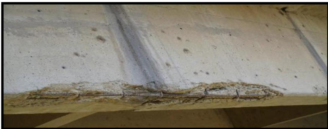
**Figura N° 6.** Oxidación de acero estructural expuesto a la intemperie.
