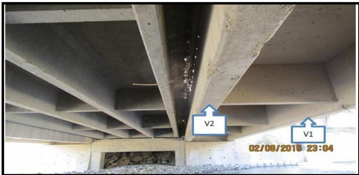
**Figura N° 13.** Por motivo de análisis llamaremos V-1 y V-2 a las vigas principales de la Ampliación de puente margen derecho, aguas arriba.
