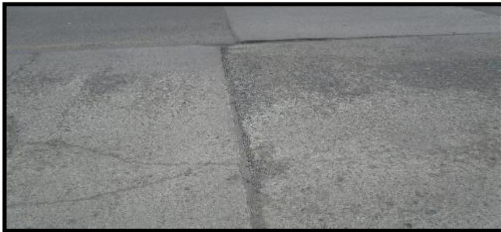
**Figura N° 4.** Desgaste por abrasión en la losa del puente.
