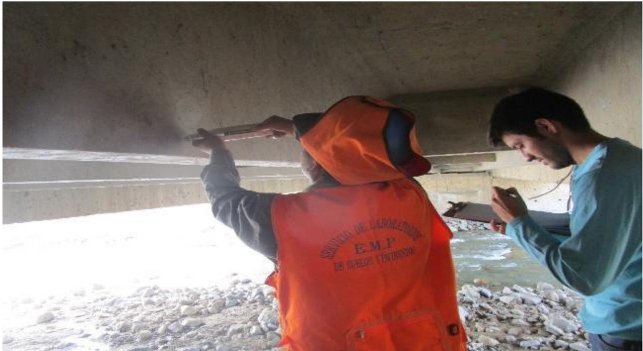
**Figura N° 09.** Realización del Ensayo de Esclerómetro Viga Principal V-2 del Ampliación de puente margen derecho, aguas arriba
