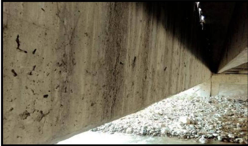
**Figura N° 5** Eflorescencia del concreto en la viga principal V-3 del puente.
