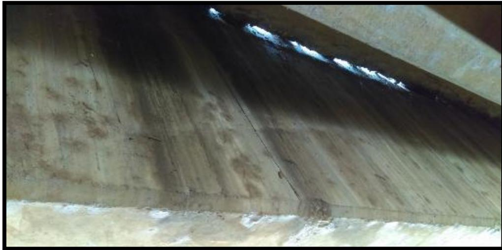
**Figura N° 1.** Viga principal V-3 de puente con presencia de humedad
