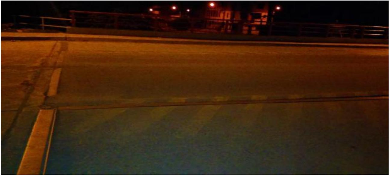
**Figura N° 19.** Deflexión considerable que avanza con el tiempo en la losa del Ampliación de puente margen izquierdo, aguas abajo.
