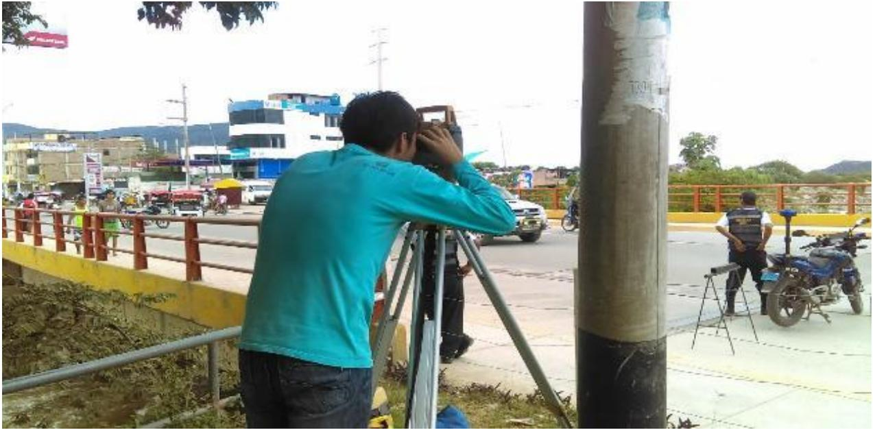
**Figura N° 15.** Realizando la verificación de los niveles y las deflexiones en la losa del puente
