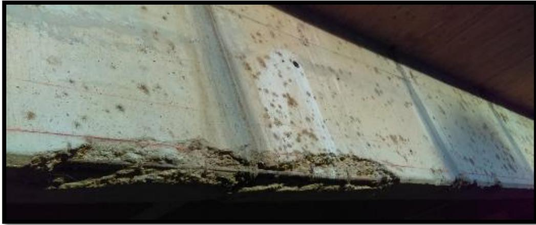
**Figura N° 3.** Desprendimiento del concreto en la viga principal V-1 del puente.
