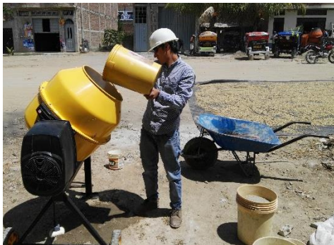
FOTO N° 18: Preparación de mezcla del Concreto Fibroreforzado con Cascarilla de Arroz (10kg/m 3 )
