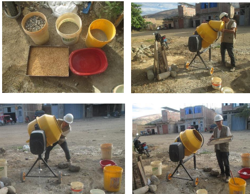
FOTO N° 25: Preparación de mezcla del Concreto Fibroreforzado con Cascarilla de Arroz (30kg/m3)
