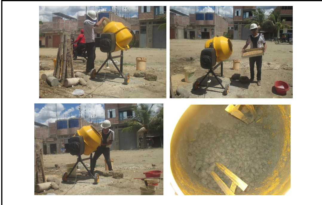
FOTO N° 22: Preparación de mezcla del Concreto Fibroreforzado con Cascarilla de Arroz (20kg/m 3 )
