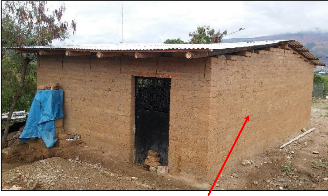
Figura 22. Muro lateral no portante
