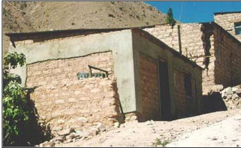
Figura 13. Casa con refuerzo exterior de malla electrosoldada, afectada por el terremoto de Arequipa en 2001, sin daño; al fondo casa destruida (Zegarra et al, citado por EERI 2003)
