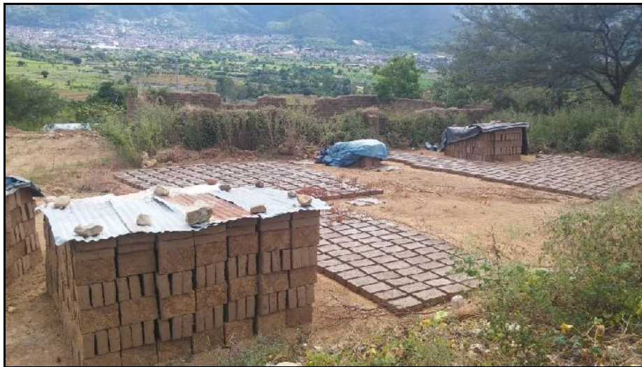
Figura 19. Fabricación de adobes en el sector de San Isidro
