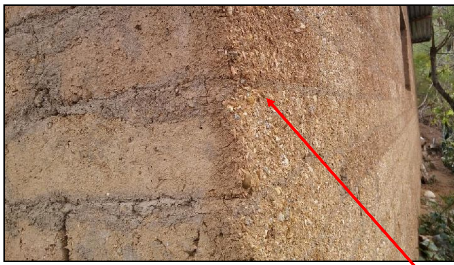
Figura 18. Adobe utilizado para la construcción de viviendas, obsérvese la paja empleada
