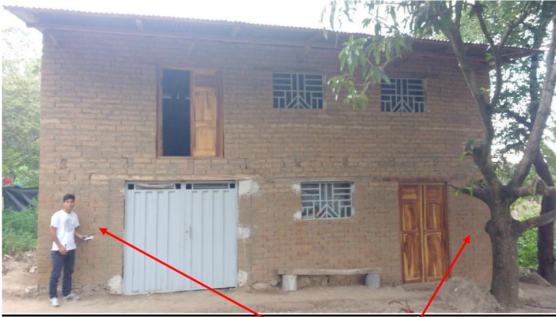
Fotografía 17: Se aprecia toma de medidas con wincha de vivienda de adobe para evaluación estructural de muro 02 y muro 01.
