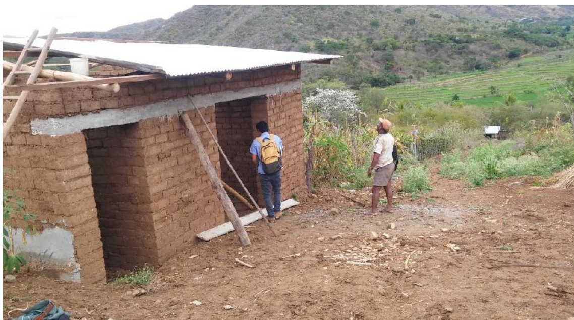
Fotografía 02: Se aprecia la vivienda N°05, en construcción, junto a un maestro de obra.
