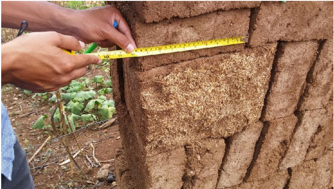
Fotografía 03: Medición de adobe usado en la construcción de viviendas en el sector de San Isidro
