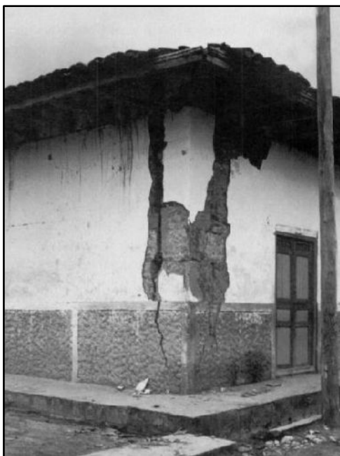
Figura 3. Falla por flexión en las esquinas, causadas por fuerzas de inercias perpendiculares a los muros (Kuroiwa, 2002).
