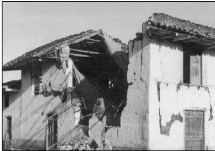
Figura 5. Falla por flexión en forma de U, muros están muy separados (Kuroiwa, 2002).
