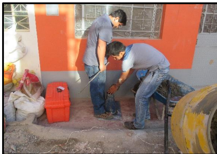
Fig. 24 Medición del asentamiento
