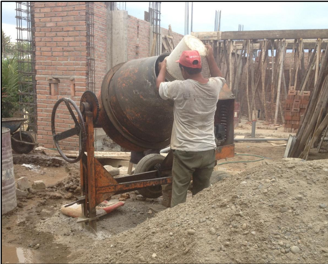
Foto N° 15 Mezclado de concreto con trompo.
