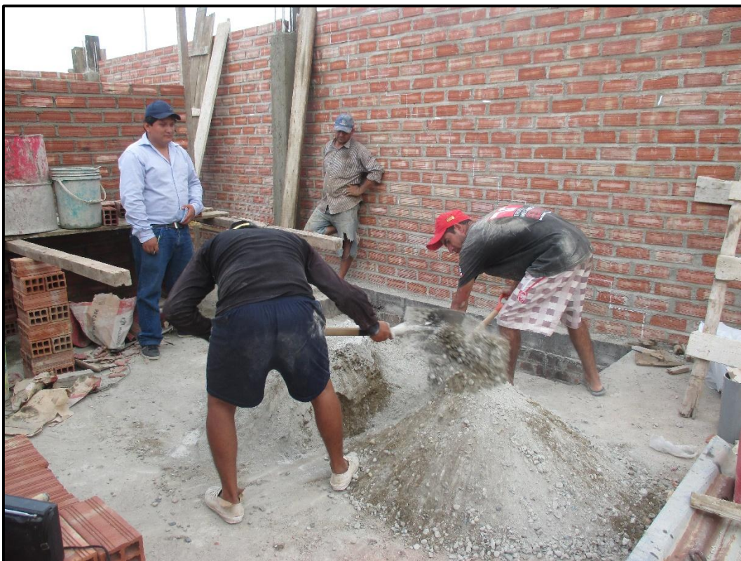
Foto N° 16 Mezclado de concreto manual
