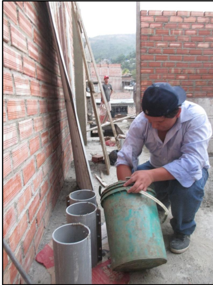
Foto N° 21 Moldeo de especímenes de concreto elaborados al pie de obra (03).
