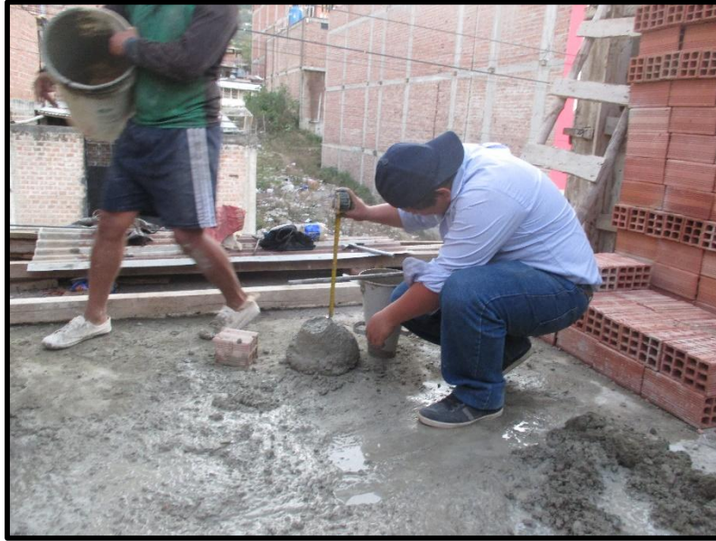
Fig. 29 Medición de asentamiento del concreto elaborado al pie de obra
