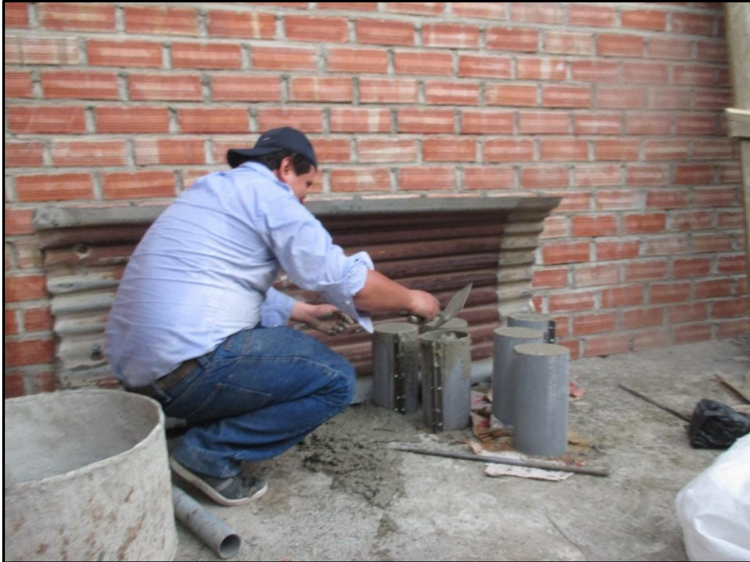
Foto N° 19 Moldeo de especímenes de concreto elaborados al pie de obra (01).
