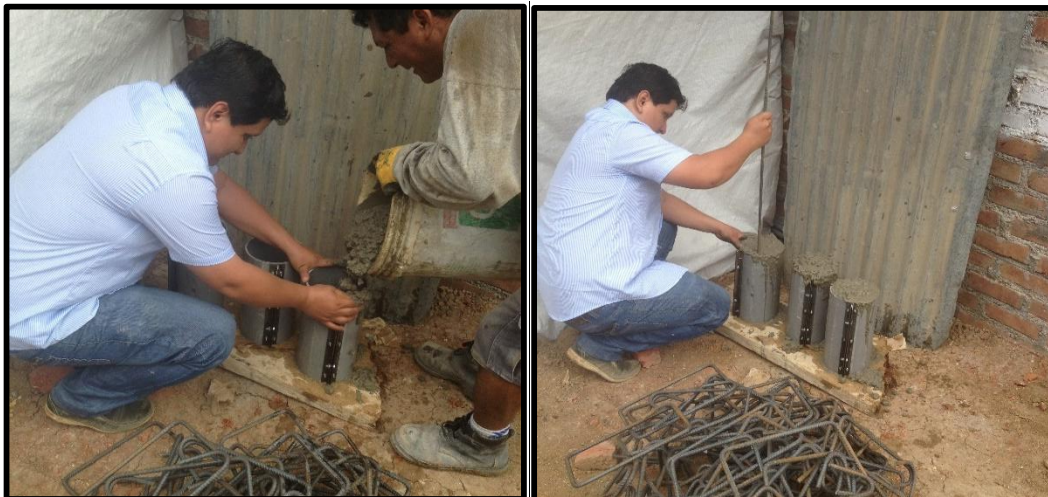
Fig. 31 Elaboración de especímenes del concreto elaborado al pie de obra.
