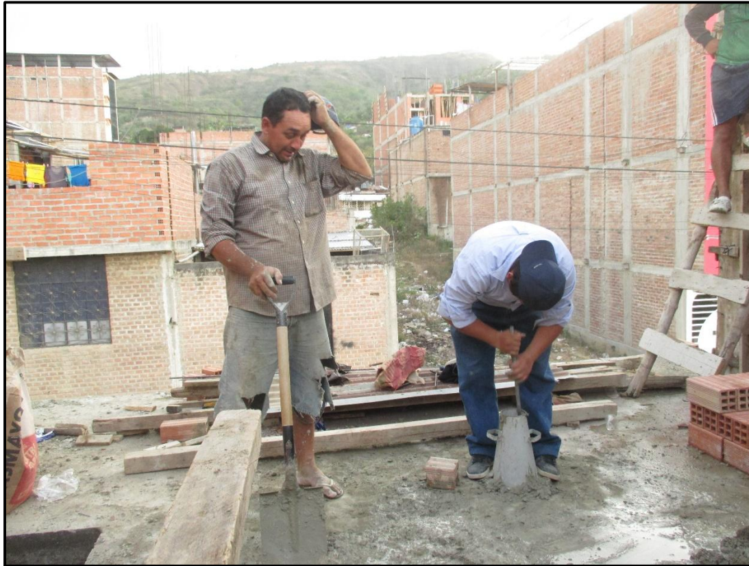
Foto N° 17 Ensayo de consistencia de la mezcla elaborada al pie de obra.
