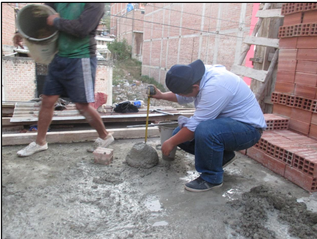
FOTO N° 18 Medición del asentamiento de mezcla al pie de obra.
