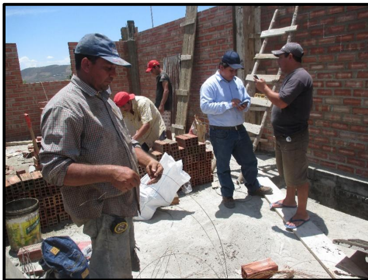
Fig. 28 Coordinaciones con maestros de obra.
