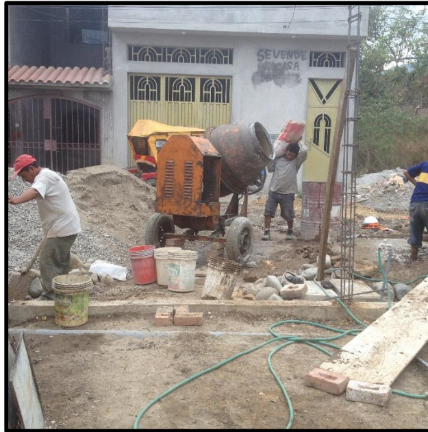
Fig. 30 Forma y medición del mesclado al pie de obra
