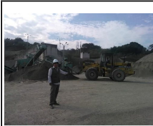
Figura 41. Acopio de materiales.
