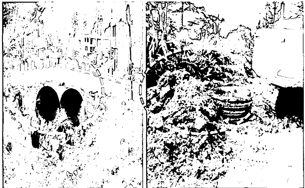
Fotos N° 82 y 83. Camino peatonal de la Empresa Minera Yanacocha afectando el cauce de la Quebrada Cruz Blanca y el 18 de marzo 2013 las fuertes precipitaciones lo destruyeron.
