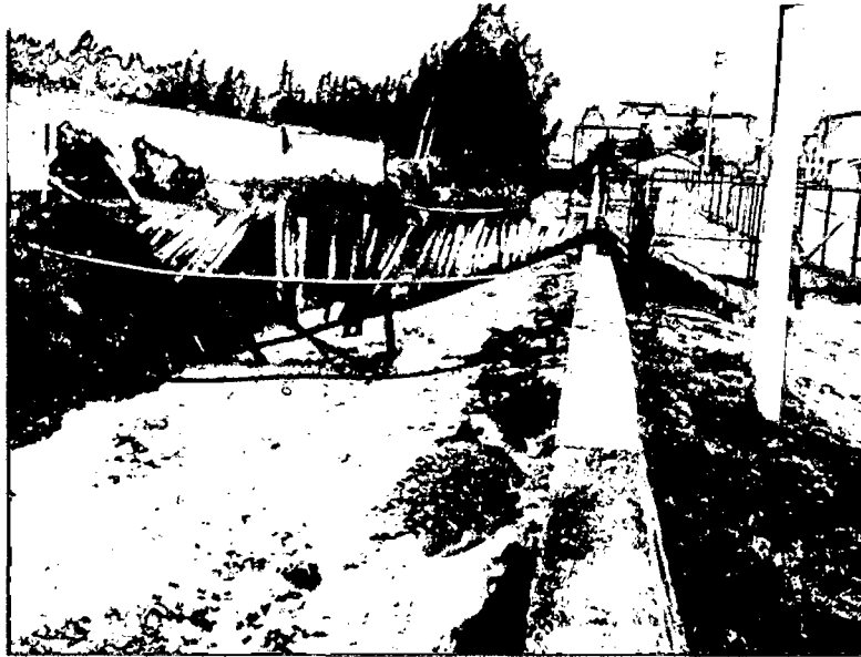
Foto N° 79. Puente peatonal destruido por la crecida de la Quebrada Cruz Blanca suscitada el 18 de marzo 2013.
