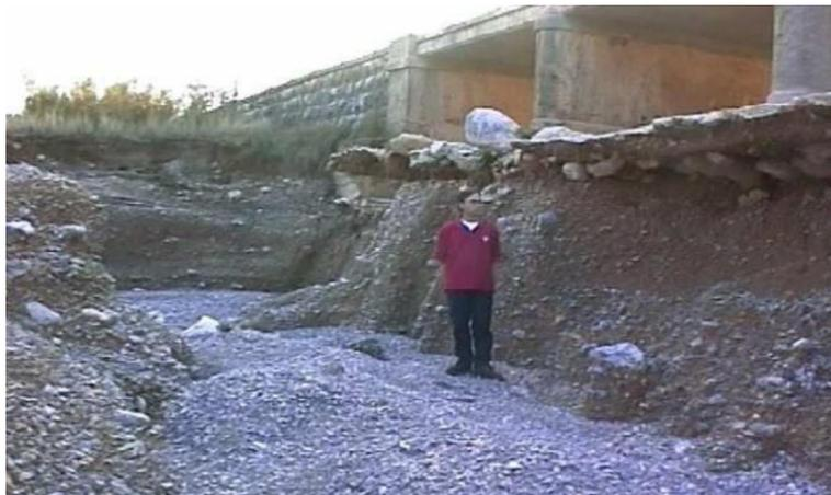
Figura N° 7. Socavación en estructura de puente Xert sobre la Rambla Cervera (Castellón). Fuente: Nácher (2012).
