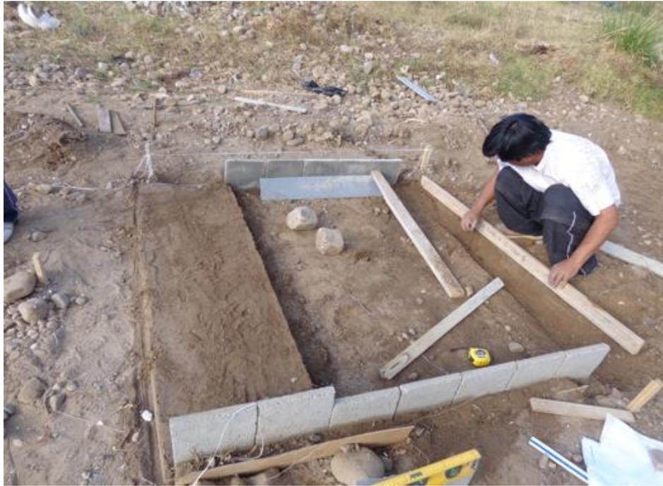
Figura N° 54. Ensamblaje de estructura en lecho del río para el modelo físico.
