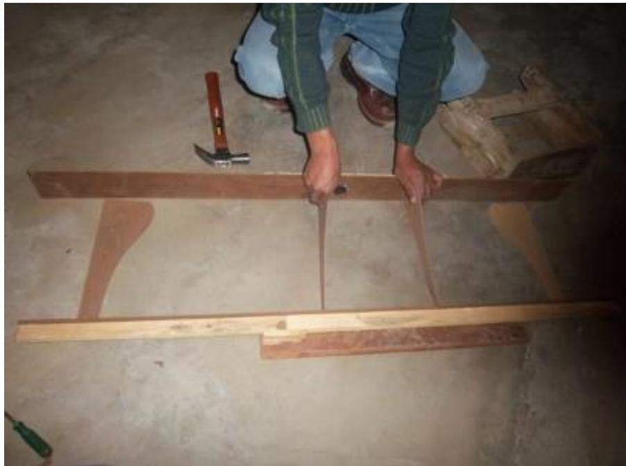
Figura N° 49. Trabajos de encofrado de barraje tipo cimacio.
