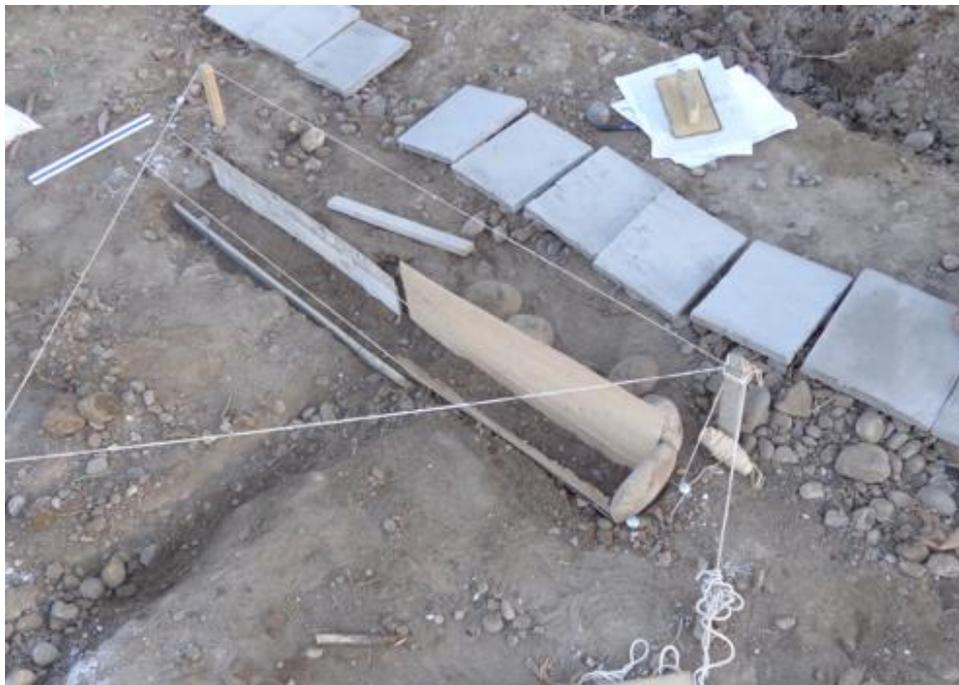
Figura N° 53. Replanteo del muros de encausamiento de estructura de captación.
