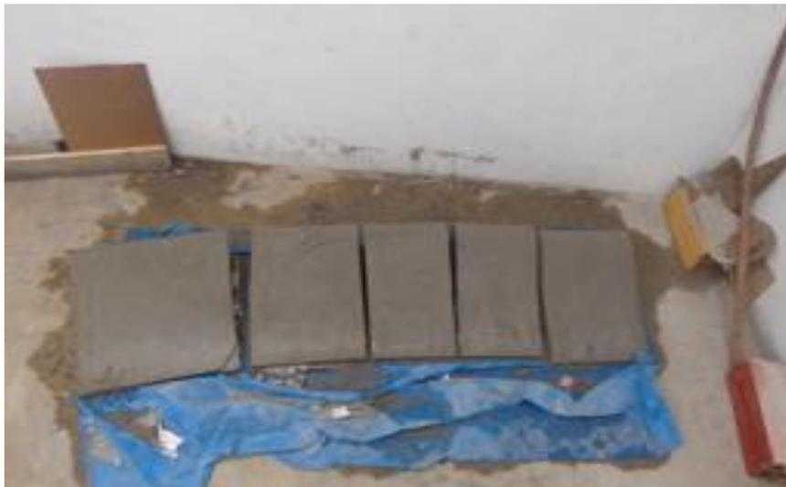
Figura N° 51. Desencofrado y curado de barraje tipo cimacio.
