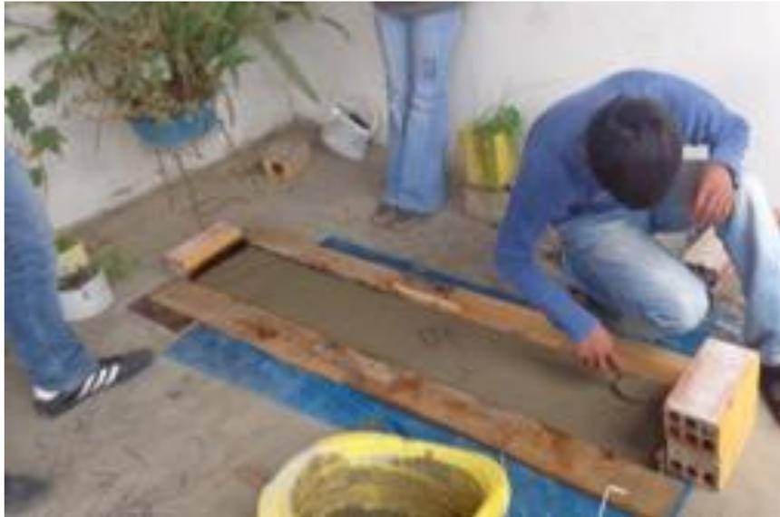
Figura N° 50. Vaciado y pulido de concreto para barraje tipo cimacio.
