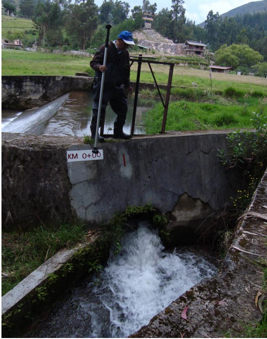
Figura 3. Captación Tres Molinos
