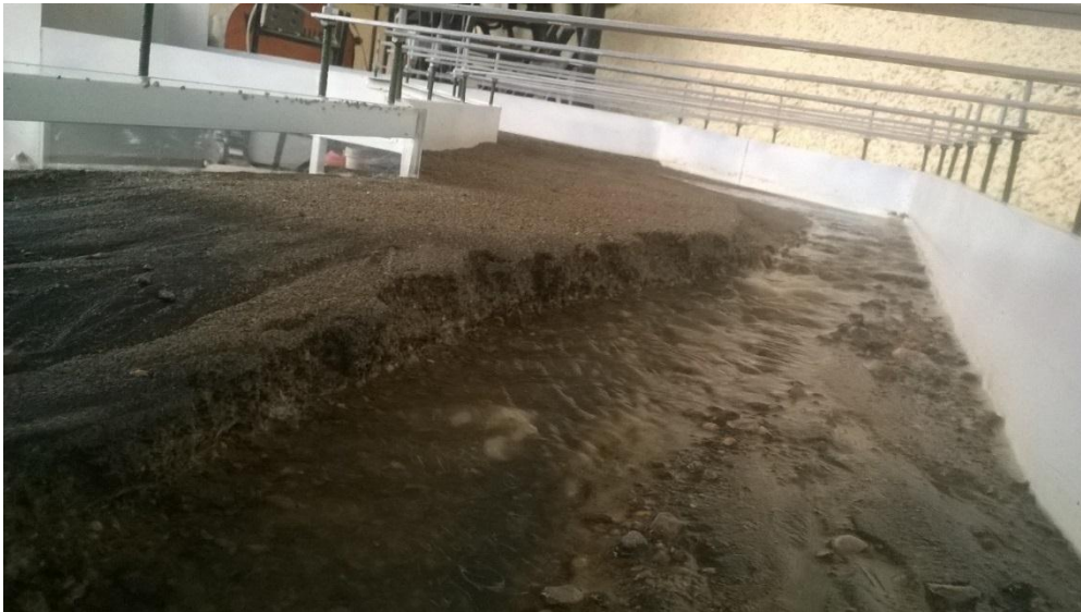
Figura 23. Morfología del río Grande vista desde el barrage hacia aguas arriba en enero de 2015, durante la descolmatación. Nótese que la erosión se intensificó en la margen izquierda del río.
