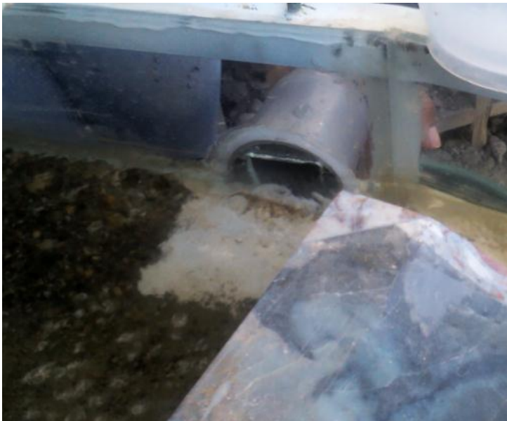
Figura 30. Bocal libre de sedimentos después de la descolmatación desde enero hasta marzo de 2015.
