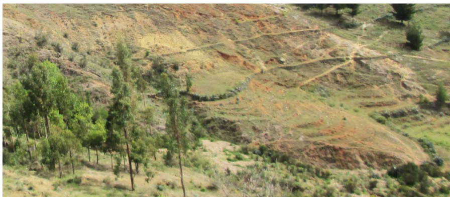
Foto 8. Cono coluvio-aluvial en el cerro Antenas en suelos arcillosos de baja plasticidad.
