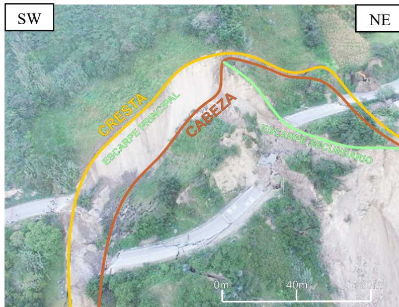
Figura 13. Vista SW al NE del Deslizamiento El Naranjo.
