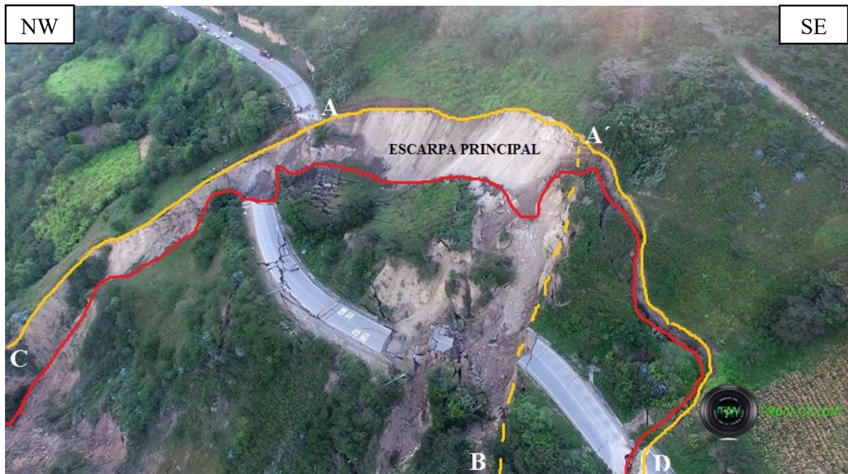
Figura 11. Actividad geodinámica del deslizamiento El Naranjo.
