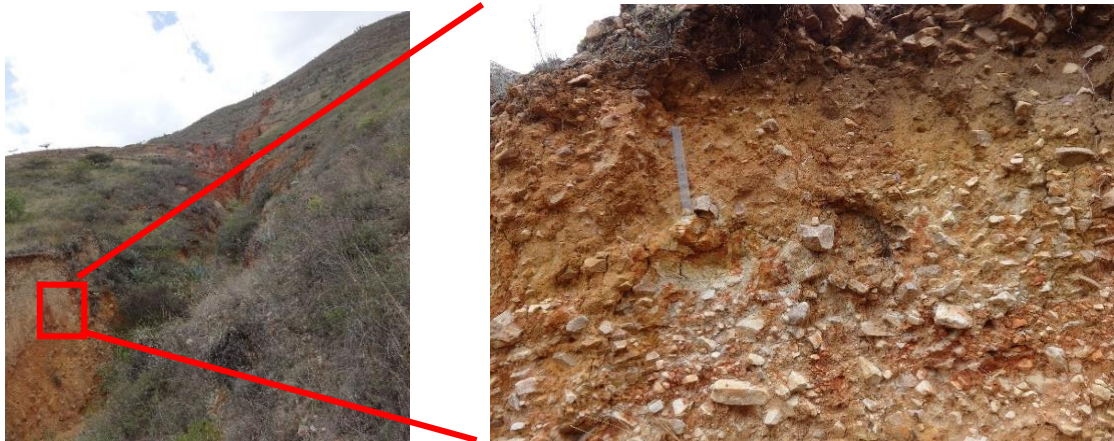
Foto N° 11: Depósito cuaternario tipo coluvio- aluvial, ubicado en la estación N° 1, deslizamiento N° 03.
