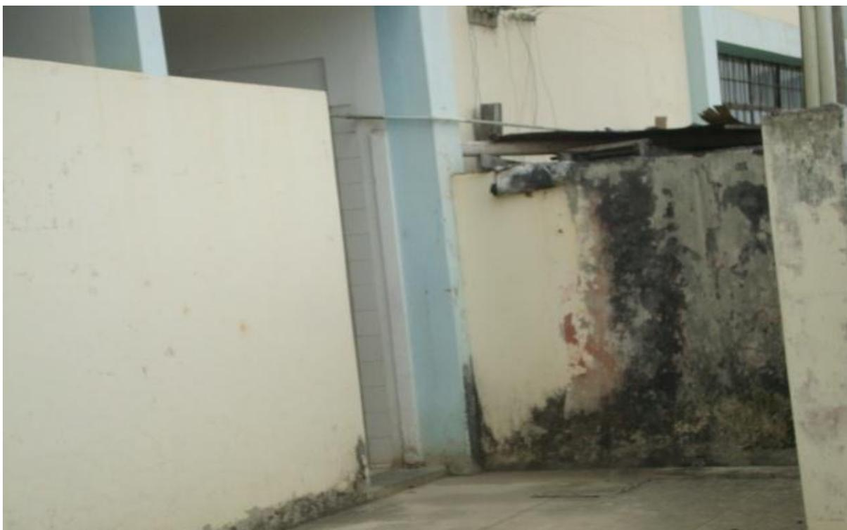
**Figura 44: Inadecuado mantenimiento de los servicios higiénicos del pabellón 1E,**
