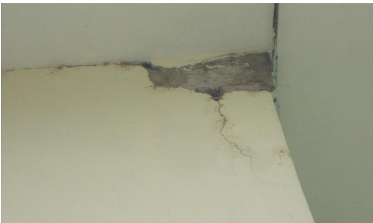
**Figura 37: Ruptura de paredes en Pabellón 2A**
