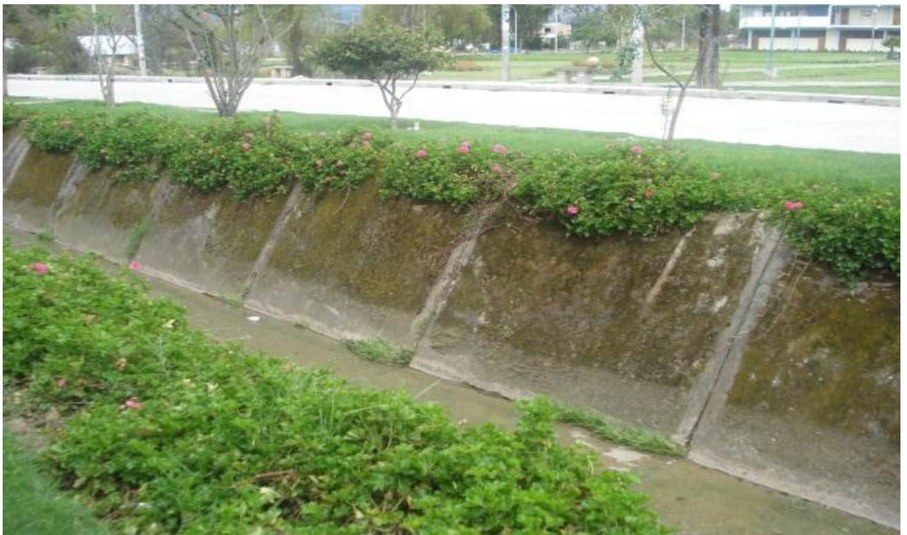
**Figura 31: Talud del canal con presencia de materia orgánica**
