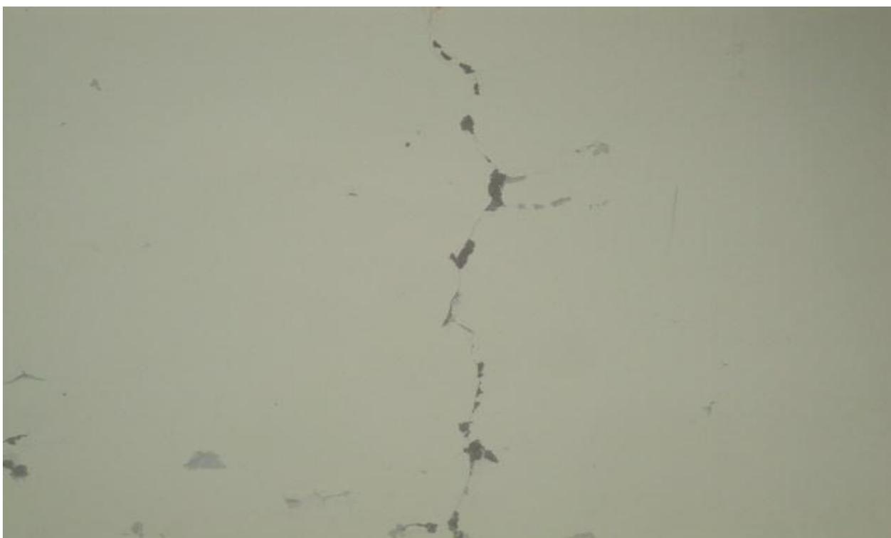
**Figura 41: Rajadura vertical en el edificio 1S,**
