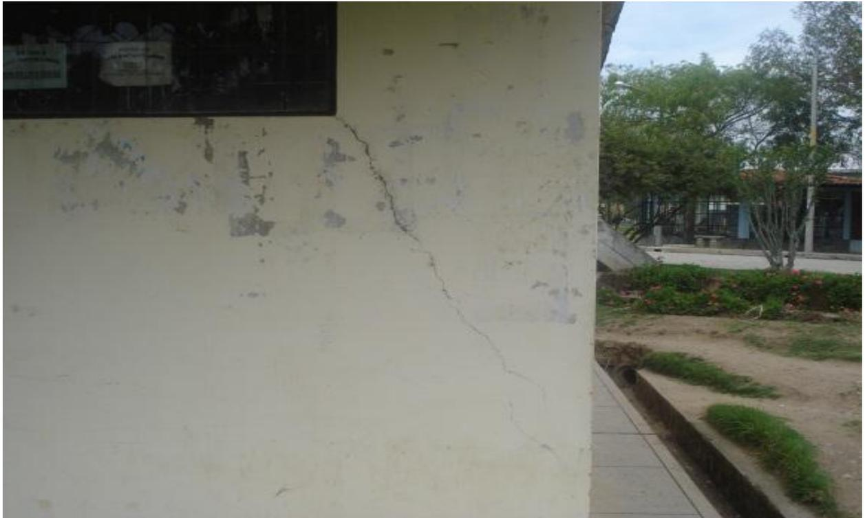
**Figura 30: Rajadura en paredes del Edificio 1F**
