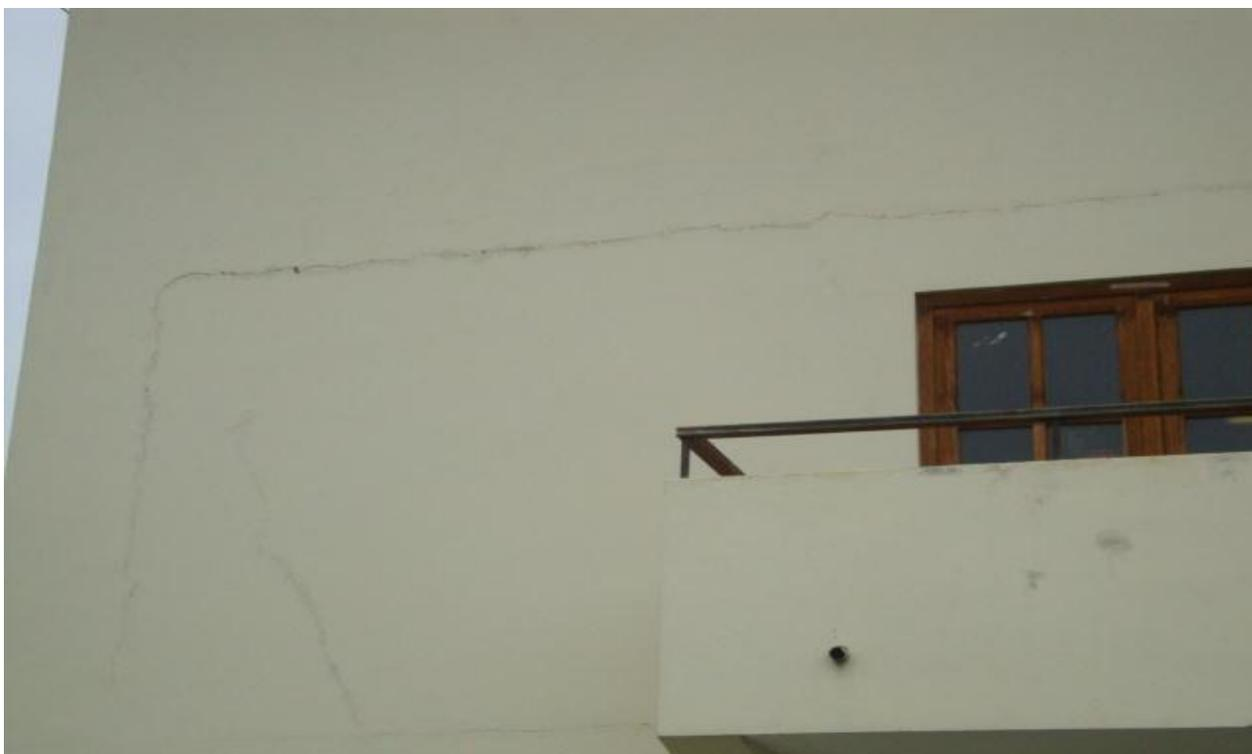
**Figura 40: Rajadura vertical y horizontal del edificio 1S,**
