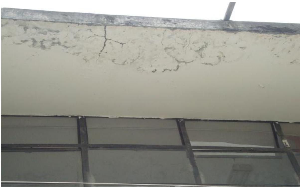
**Figura 45: Muestra las Patologías en el techo aligerado del edificio 1E (física)**
