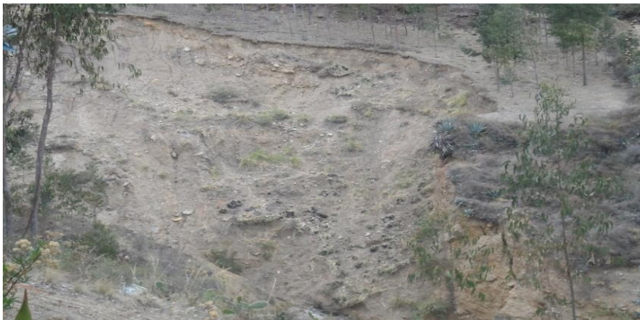
Figura D.21: Vista de la extensión del deslizamiento.
