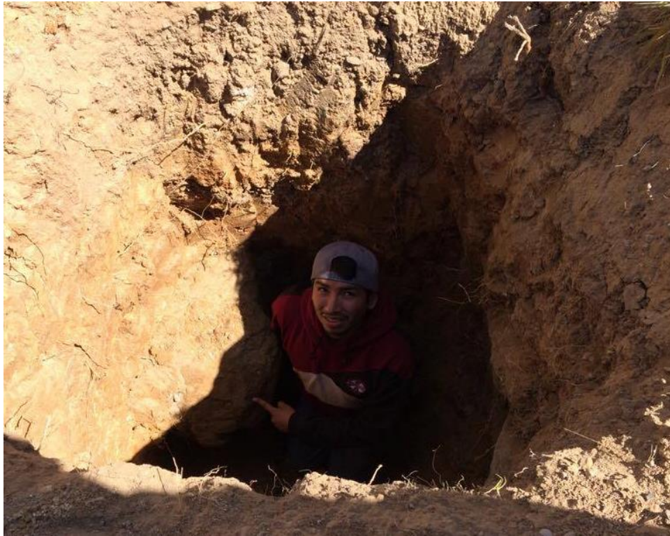
Figura D.57: Características de la calicata C-5, cuerpo del deslizamiento.
