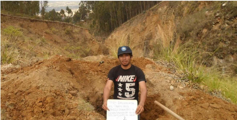
Figura D.29: Profundidad de la calicata C-2 = 1.20m.
