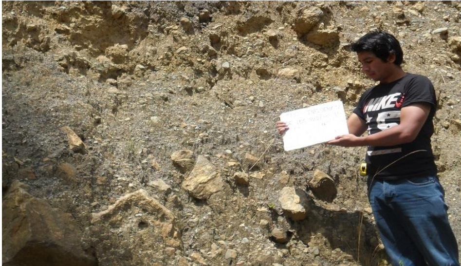
Figura D.31: Calicata C-4 = 3.00m, en el escarpe principal.
