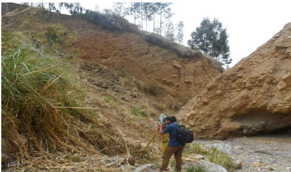
Figura D.24: Levantamiento del deslizamiento rotacional.
