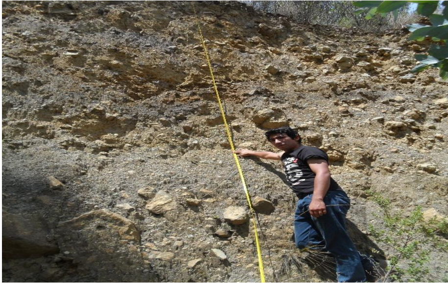
Figura D.19: Escarpe principal (Inicio del movimiento).
