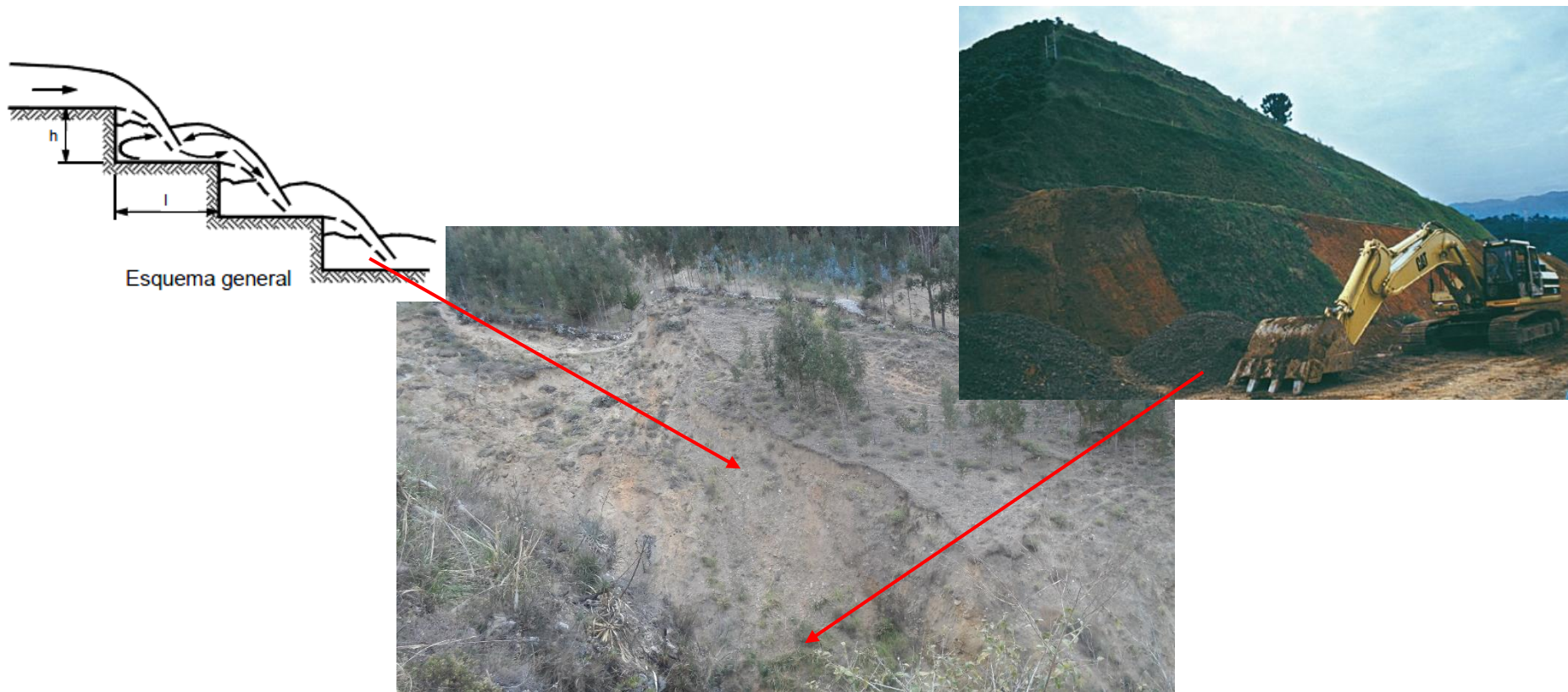
Figura 43: Estabilización mediante banquetas en la ladera en estudio.
