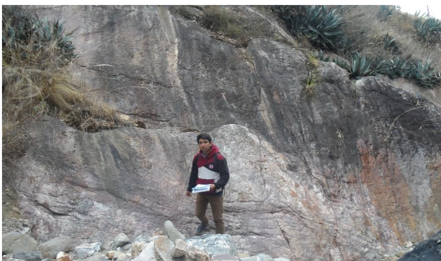
Figura D.9: Espejo de falla en la quebrada.
