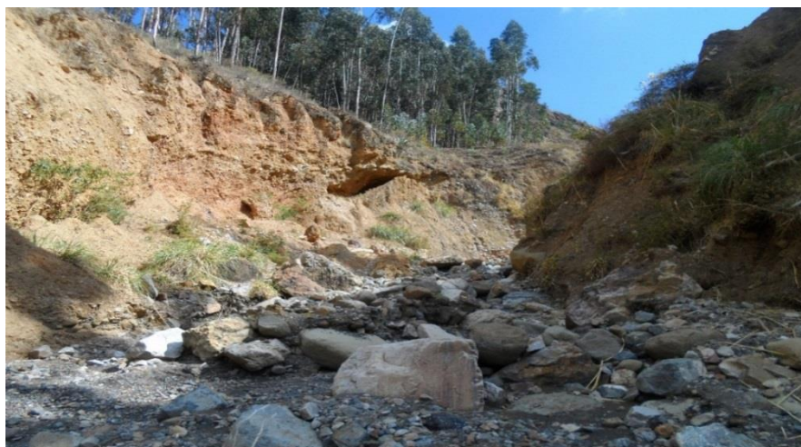
Figura D.2: Vista frontal de la quebrada Huayllapampa.
