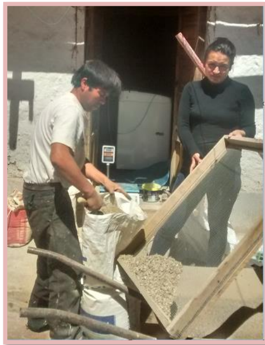
Figura 22. Tamizado del suelo para la elaboración de ladrillos.
