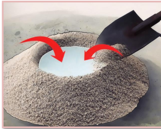
Figura 18. Mezclar hasta obtener pasta uniforme.
