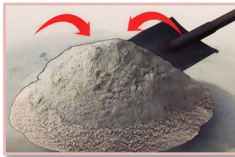
Figura 16. Cemento volcado sobre la arena, mezclado en seco.
