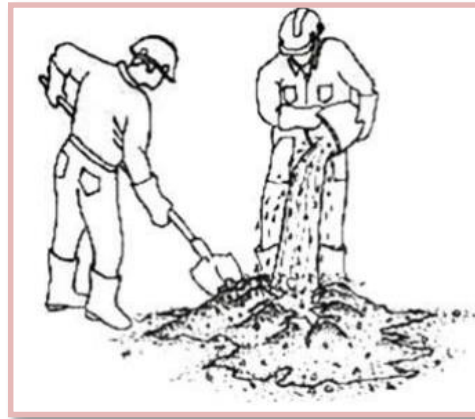
Figura 7. Ilustración de agregado del agua a la mezcla en seco de suelo con cemento (hasta obtener una mezcla homogénea).
