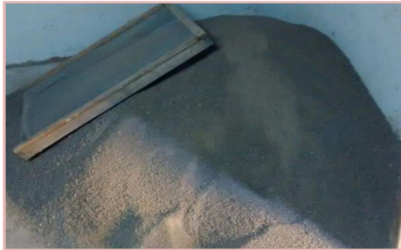
Figura 2. Suelo tamizado que cumple con propiedades para realizar ladrillos alternativos de suelo cemento compactado.
