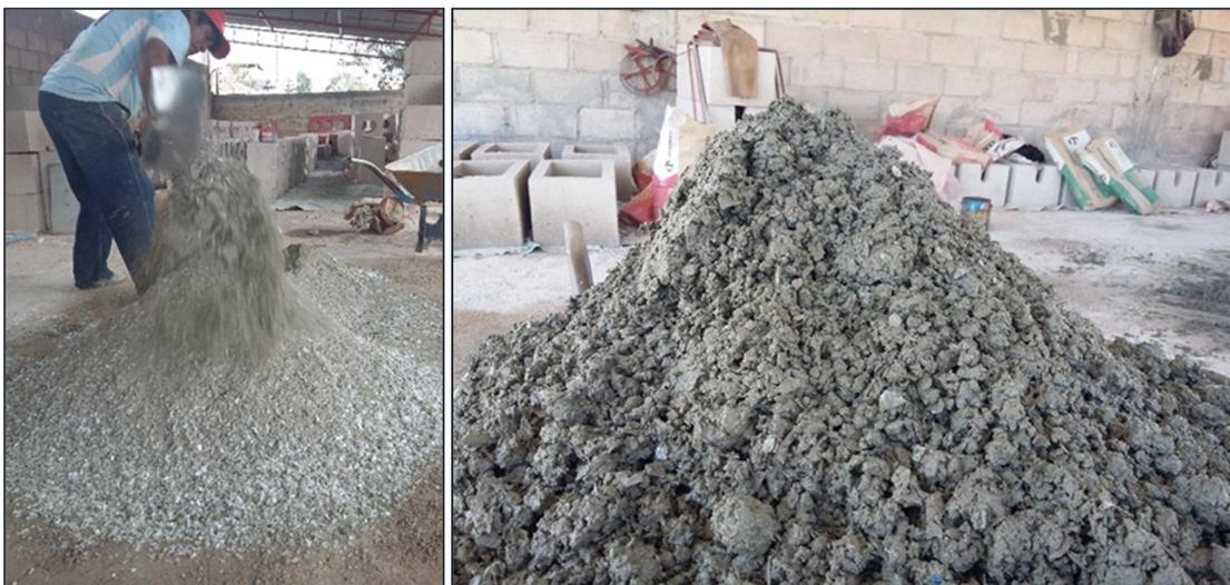
Figura 66. Consistencia de la mezcla de ladrillos de concreto, seca y húmeda.
