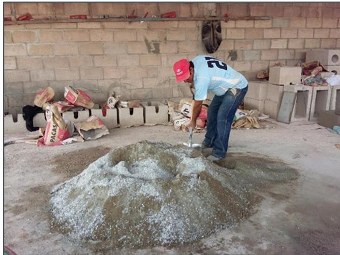
Figura 65. Mezclado de los agregados de ladrillo de concreto.
