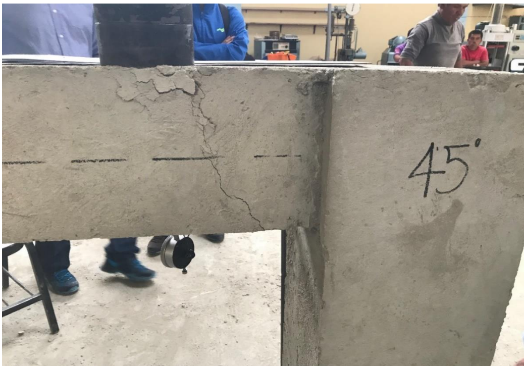
Fotografía 12. Falla producida por esfuerzo cortante en viga con estribos colocados a 45^\circ con respecto al acero longitudinal.
