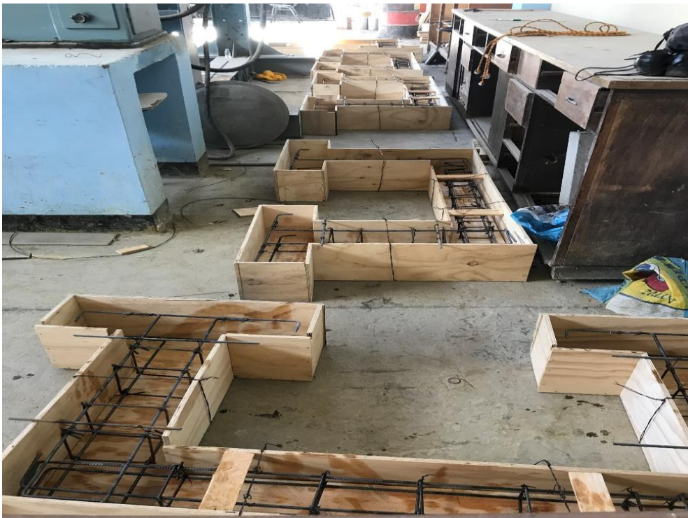
Fotografía 4. Encofrado con Triplay de 12 mm para cada uno de los pórticos.
