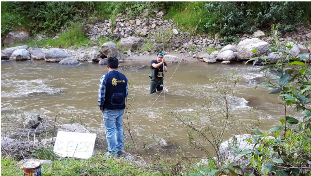
Foto 15: Toma de datos Km. 13+250
