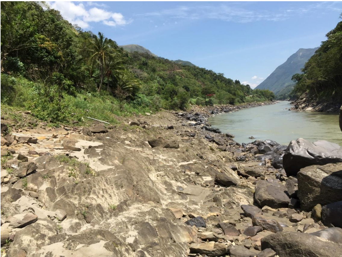
Figura 13: descarga directa de desagüe al río
