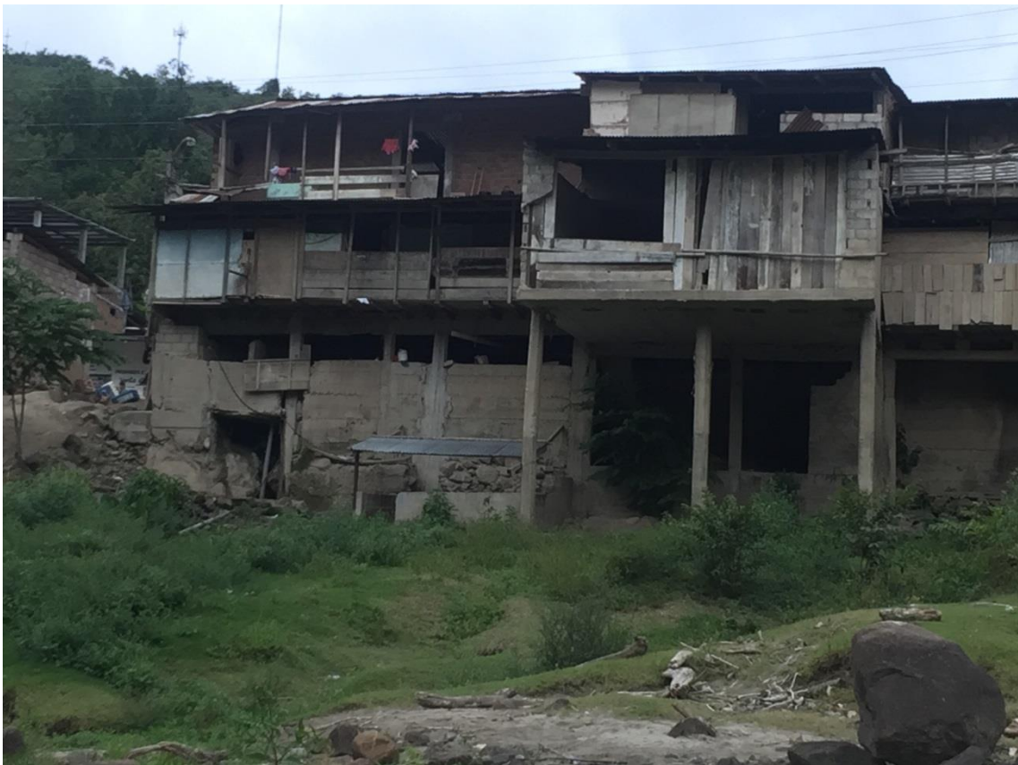
Figura 15: Instalaciones sanitarias que descargan directamente al río.
