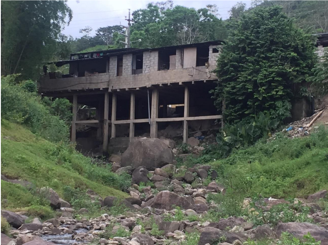
Figura 14: Instalaciones sanitarias que descargan directamente al río
