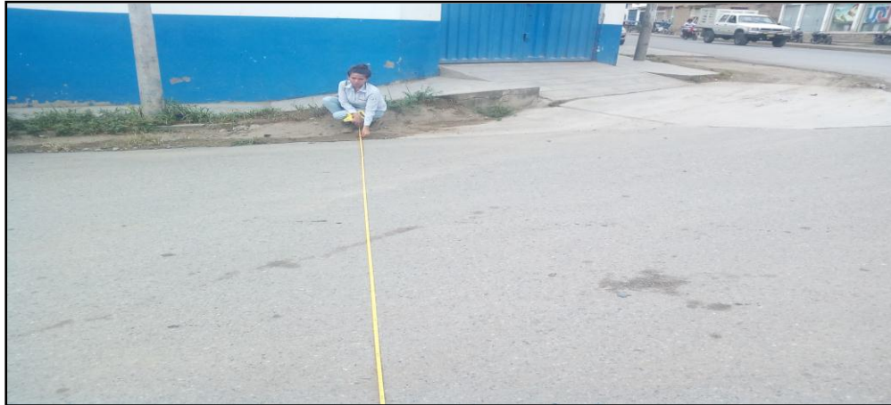
Figura N°103. Realizando la toma de medidas en el Paso Peatonal 4.
