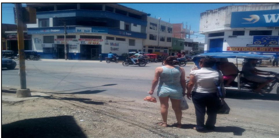
Figura N°108. Esquina 6 entre la Av. Pakamuros C-05 con la Calle 2 de Mayo C-04 la cual no se encuentra pavimentada.
