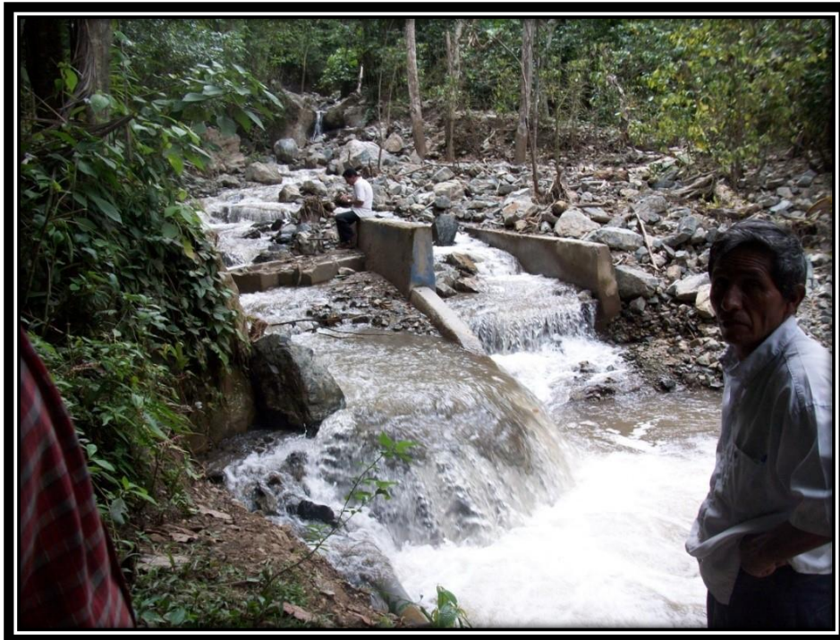
Figura 20. Estado actual de la Captación tipo barraje del Centro Poblado Churuyacu
