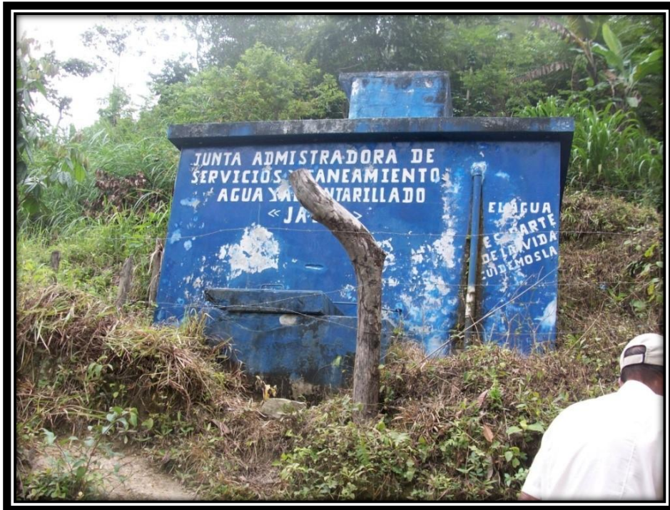
Figura 22. Estado actual del Reservorio del Centro Poblado Churuyacu
