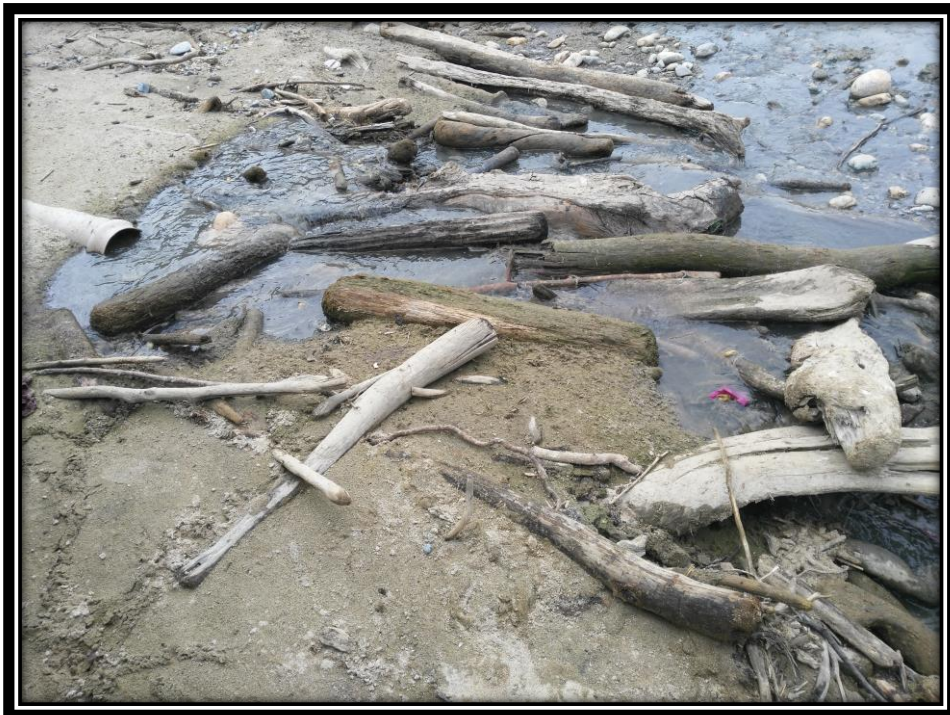
Figura 25. Vista donde se observa que la descarga de las aguas residuales sin ningún tratamiento
