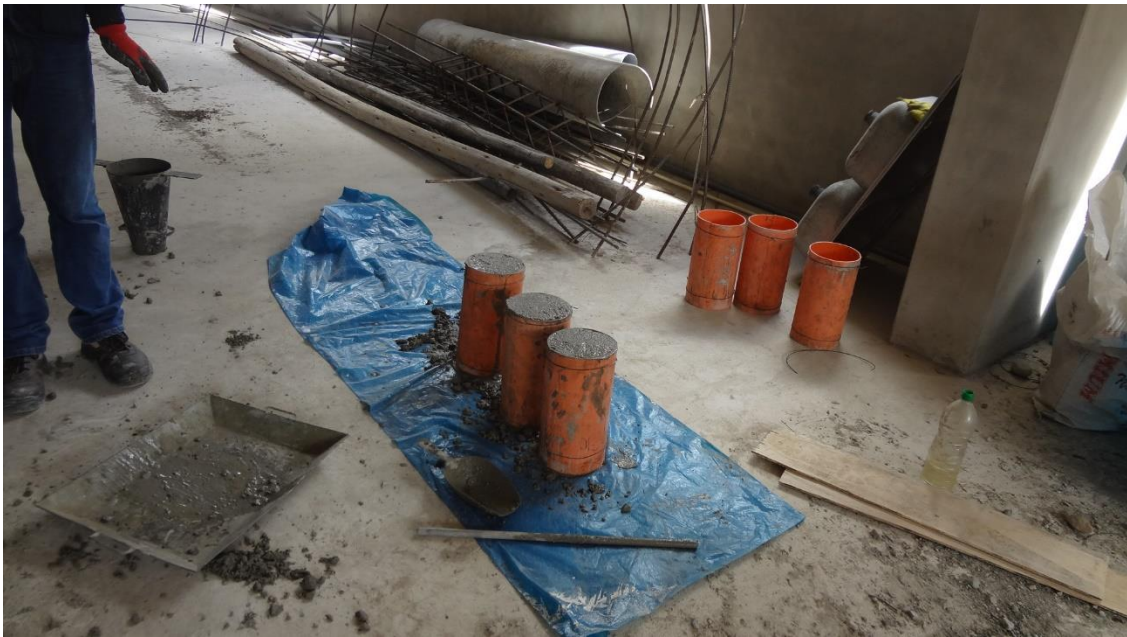
FOTO N° 19: Vista de los moldes con los especímenes de concreto.
