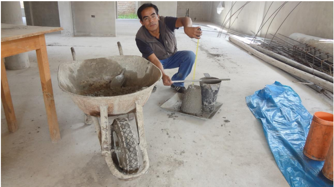
FOTO N° 18: Vista del ensayo de slump de las mezclas de concrete.
