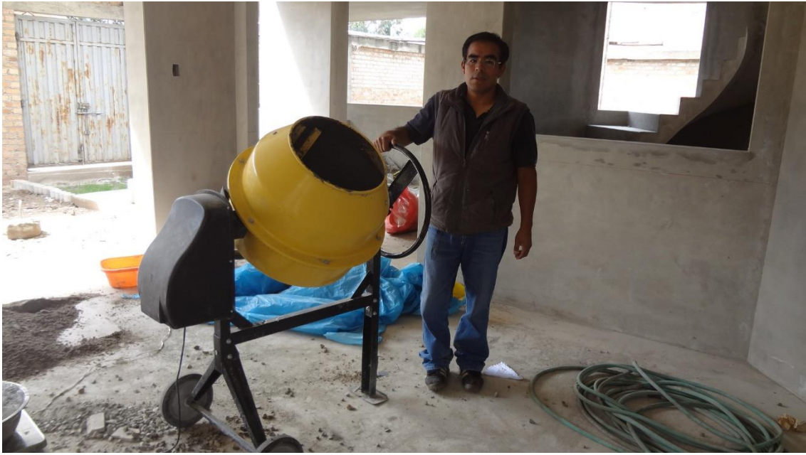
FOTO N° 17: Vista para la preparación de las mezclas de concreto.
