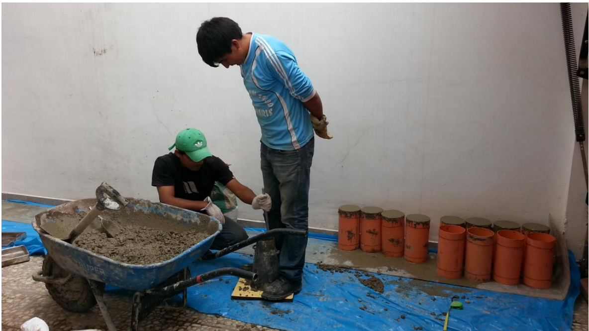
FOTO N° 4: ensayo de revenimiento del concreto.
