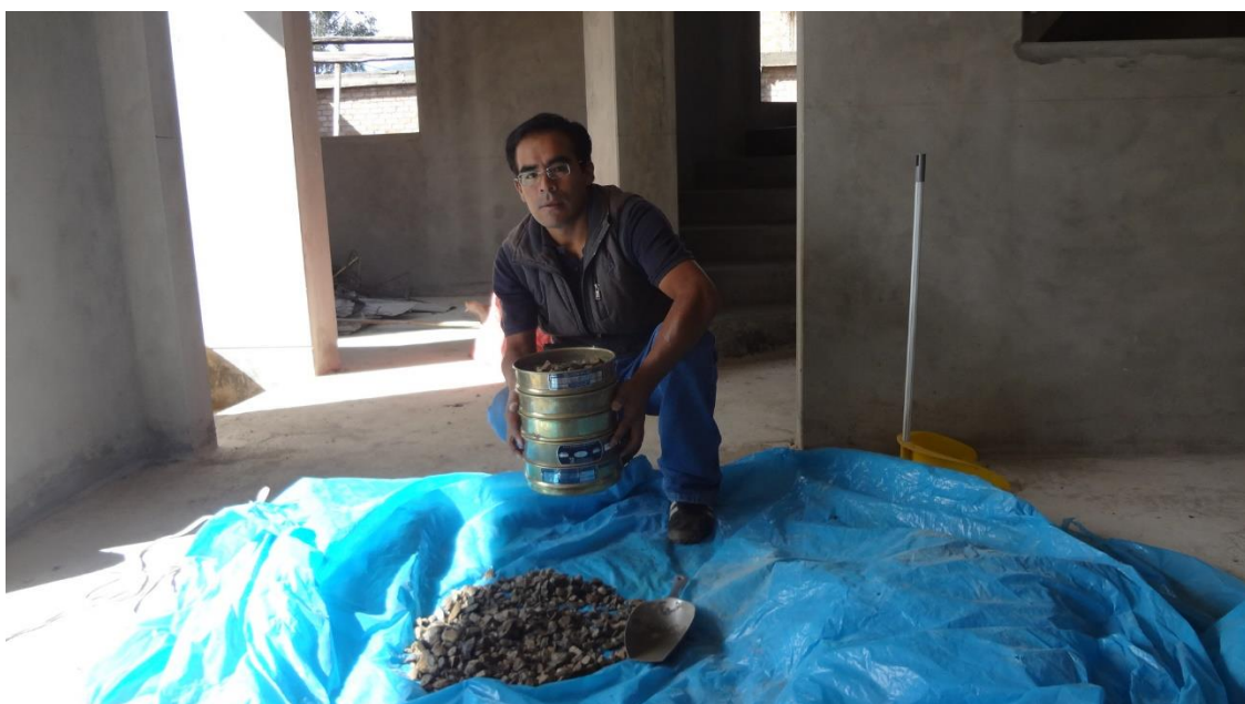
FOTO N° 16: Vista análisis granométrico del agregado grueso.
