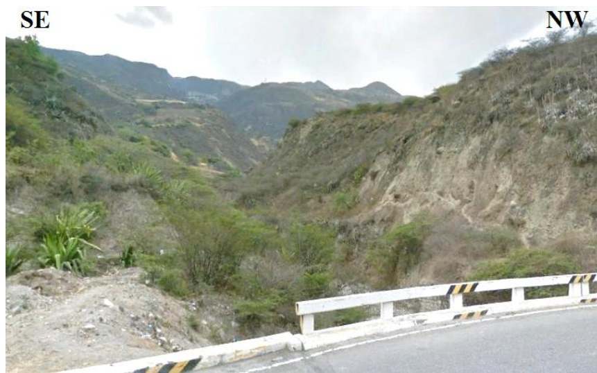
Figura 15: Vista de la quebrada de Lucma, que atraviesa la carretera en el Km 126+250 Coordenadas N: 9194269 y E: 767089
