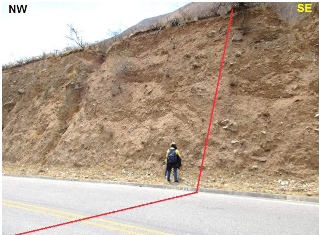
Figura 33: Talud 08, compuesto por depósitos coluvio-aluviales.
