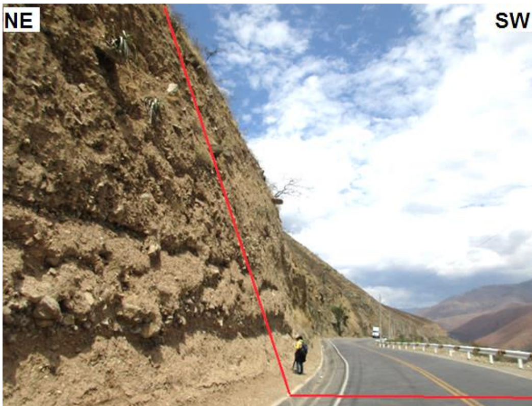
Figura 28: Talud 03, compuesto por depósitos coluvio-aluviales que presentan bloques sub-angulosos y limos arcillosos.
