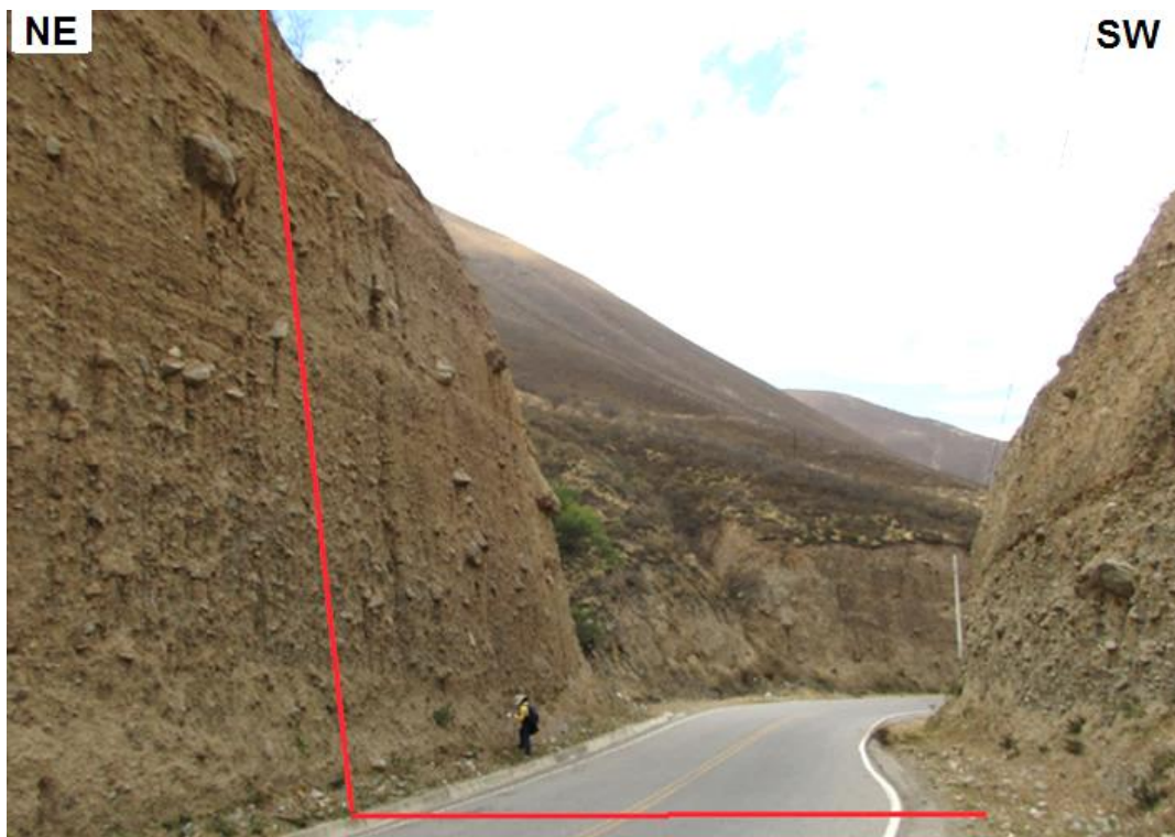
Figura 32: Talud 07, constituido por depósitos aluviales.
