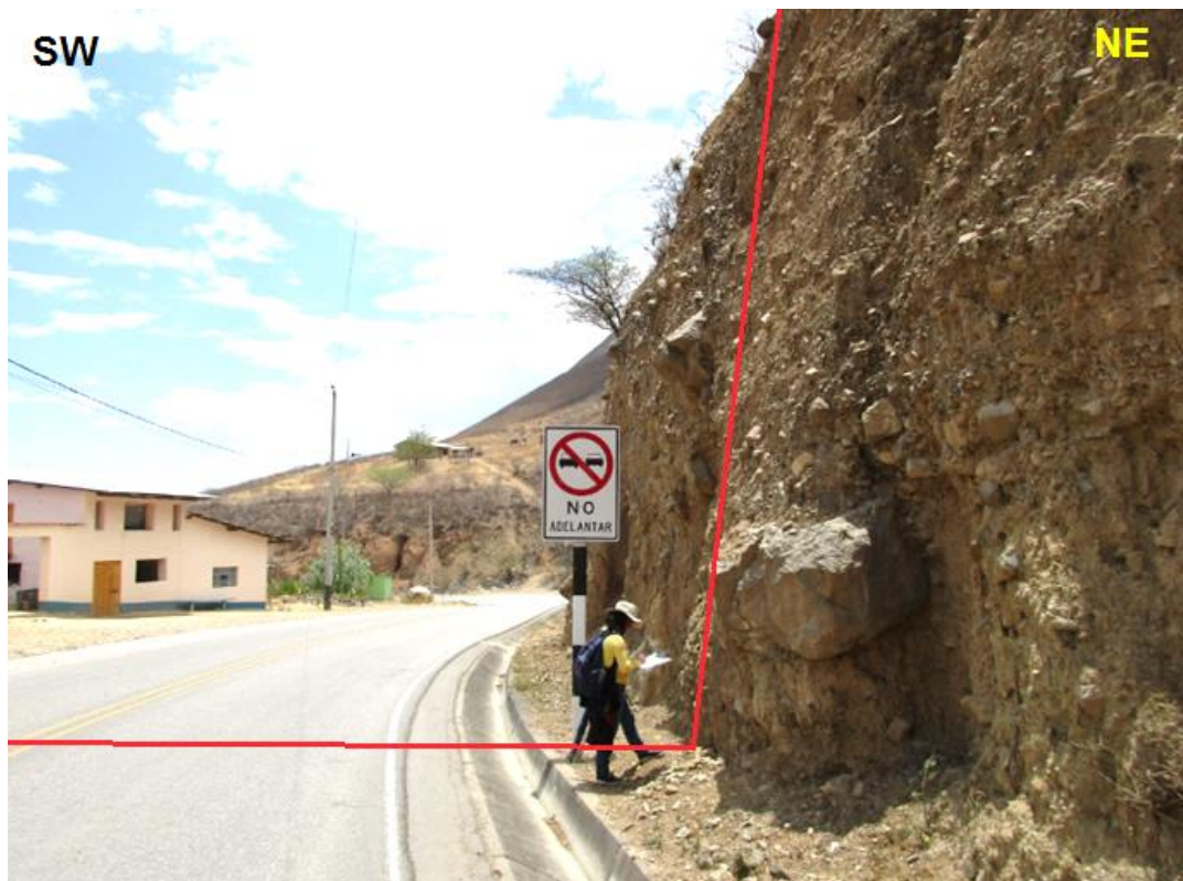
Figura 34: Talud 09, constituido por depósitos aluviales.
