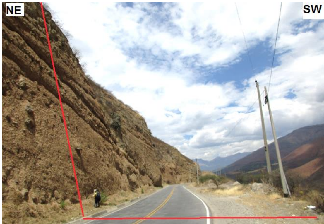
Figura 31: Talud 06, constituido por depósitos aluviales, que tienen alto contenido de finos.
