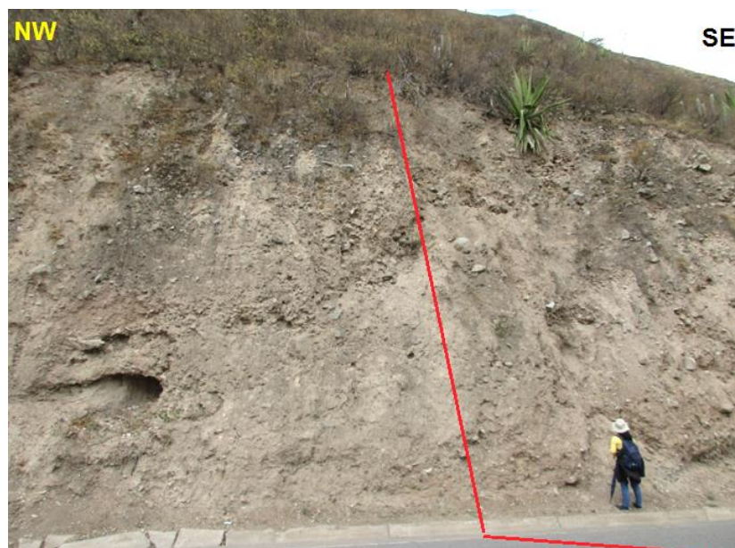
Figura 25: Talud 01, constituido por depósitos cuaternarios.
