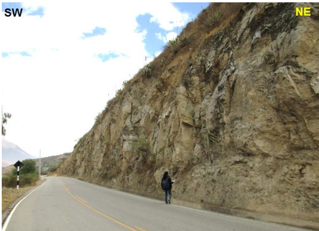
Figura 39: Talud 14, constituido por calizas del Grupo Pulluicana.
