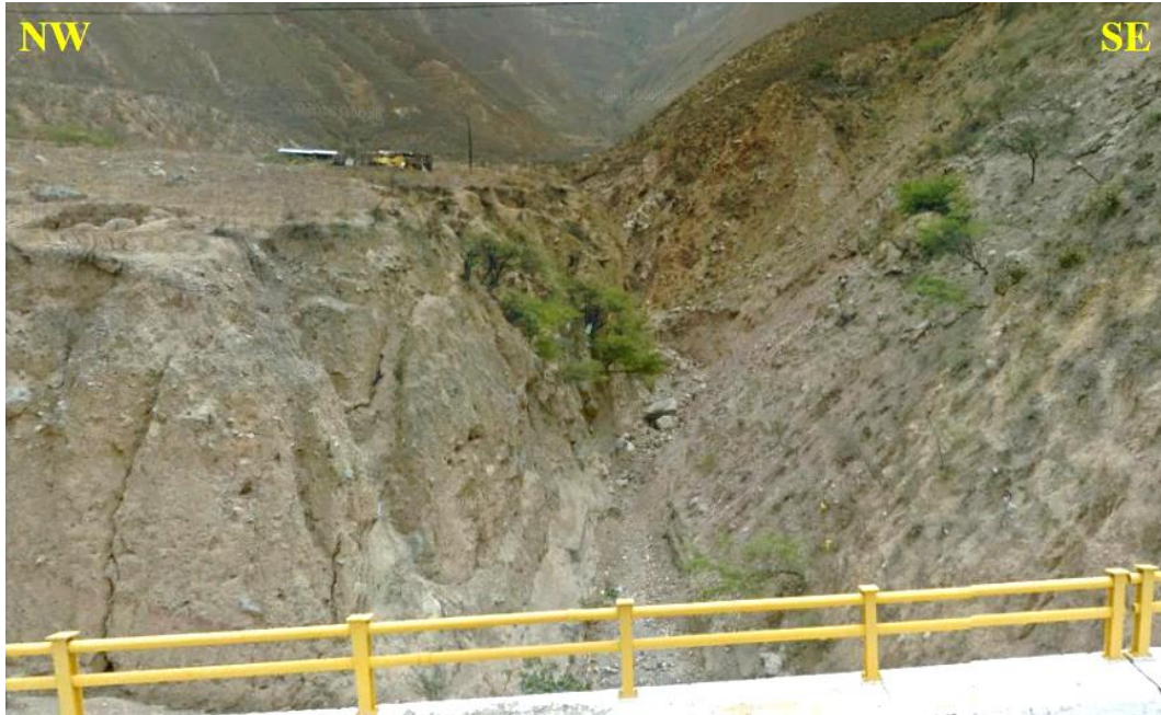
Figura 16: Quebrada El Mirme, se observa derrumbes en los márgenes, ubicada en las coordenadas N: 9195720 y E: 761792
