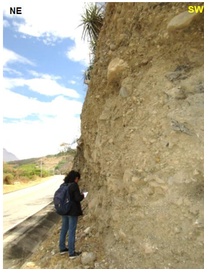
Figura 38: Talud 13, constituido por depósitos aluviales.
