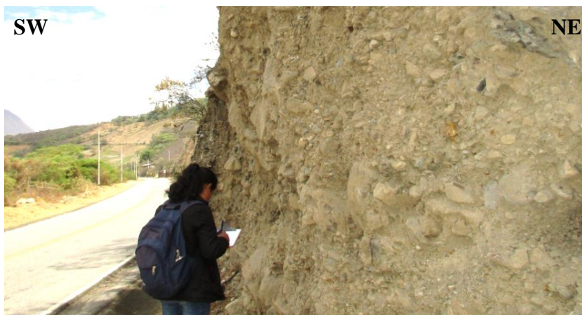
Figura 22: Depósitos coluvio-aluviales compuestos por arcillas y limos de alta plasticidad, y gravas arcillosas. Ubicado en el Km 123+950.
