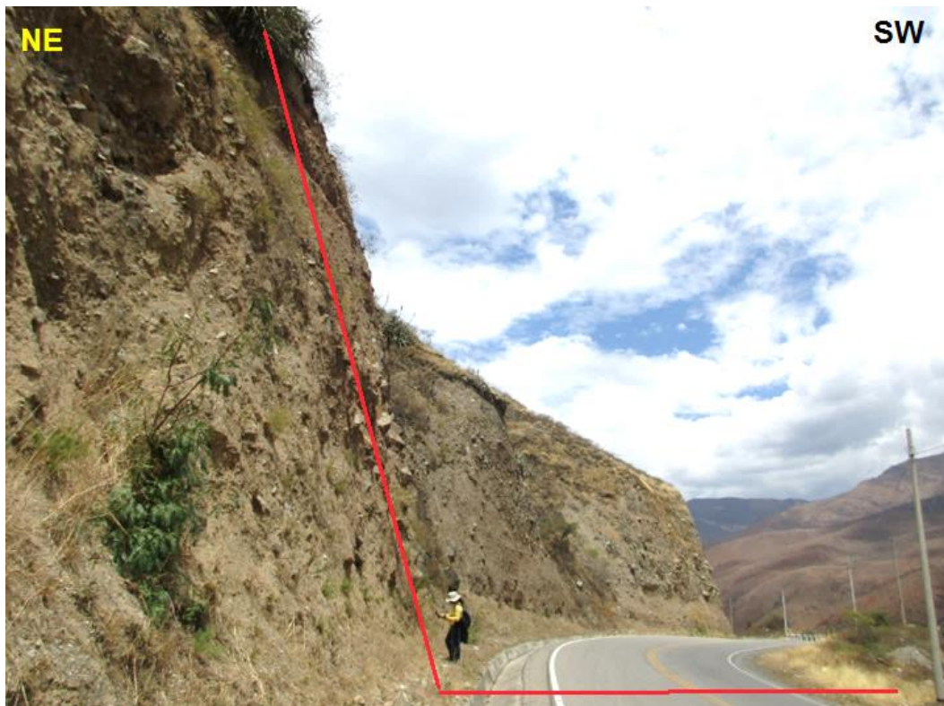
Figura 30: Talud 05, constituido por depósitos coluvio-aluviales.
