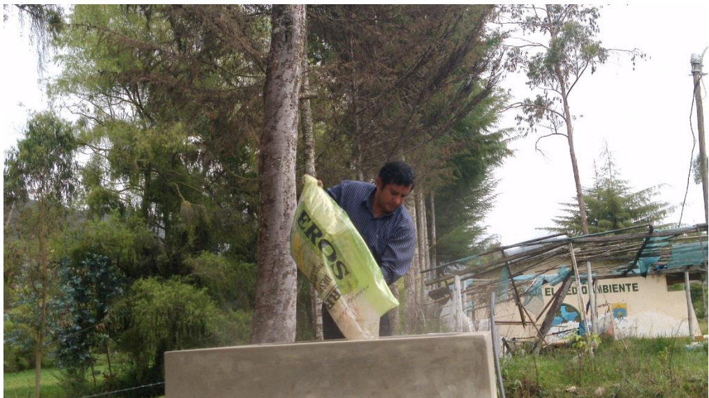
Foto 10: Agregando el sustrato orgánico (Viruta de pino)
