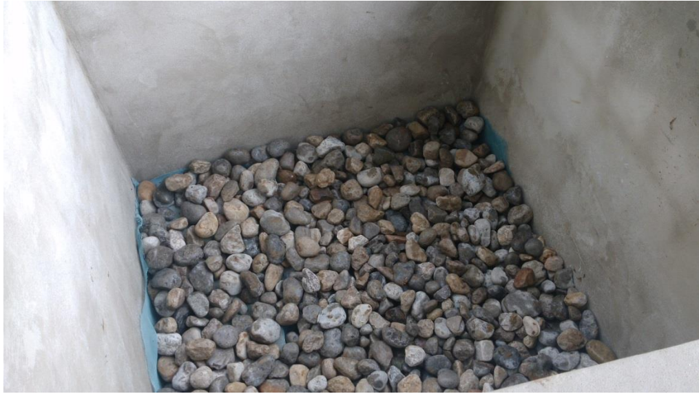
Foto 9: Agregando la grava necesaria al biofiltro
