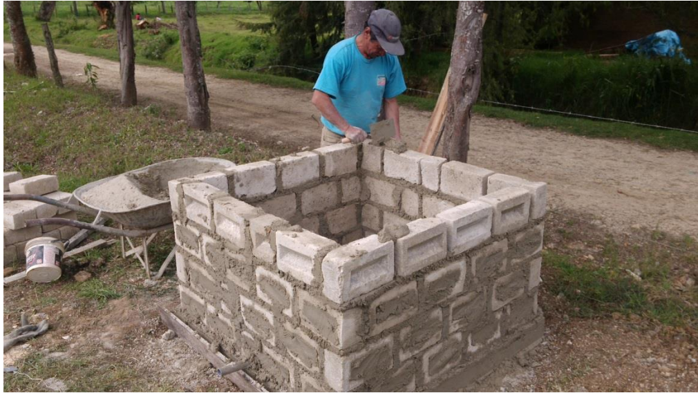
Foto 5: Proceso de construcción del biofiltro
