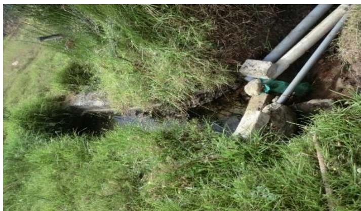
Figura 24. Poza utilizada para lavar ropa y regadío
