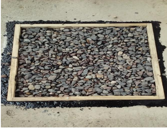
Figura 13. Fijación del agregado mediante apisonado
