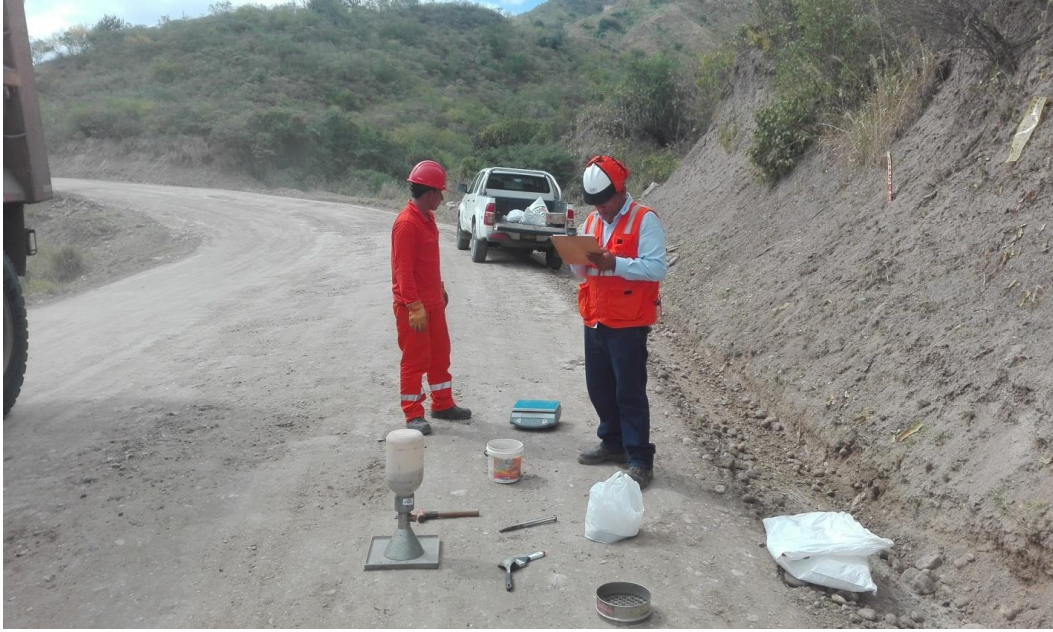
Figura 17. Vista donde se observa la prueba de compactación método del cono y arena- Julio 2016.
