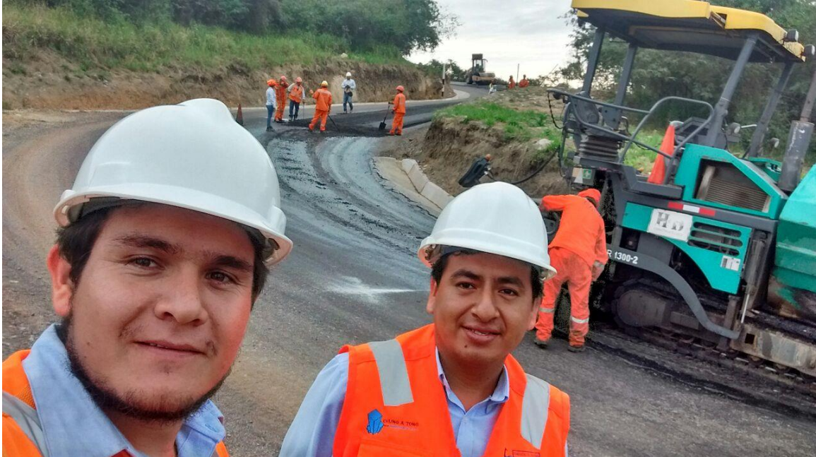
Figura 10. Vista donde se observa el regado del agregado T.S.B y Distribuidora de agregado autopropulsada
