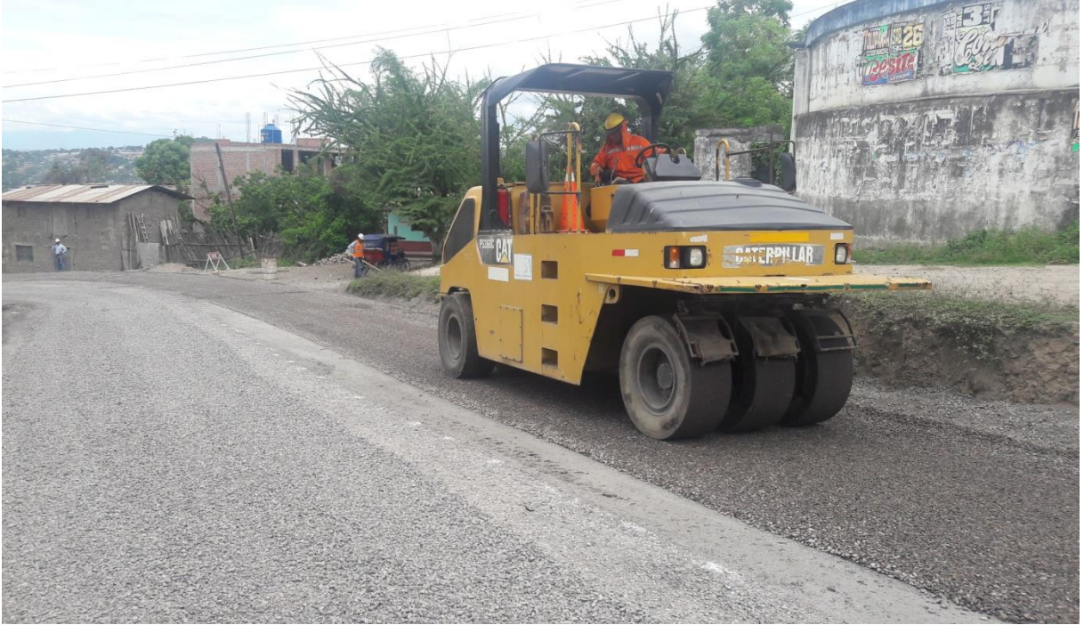
Figura 11. Vista donde se observa el compactado del agregado TSB con el rodillo neumático.
