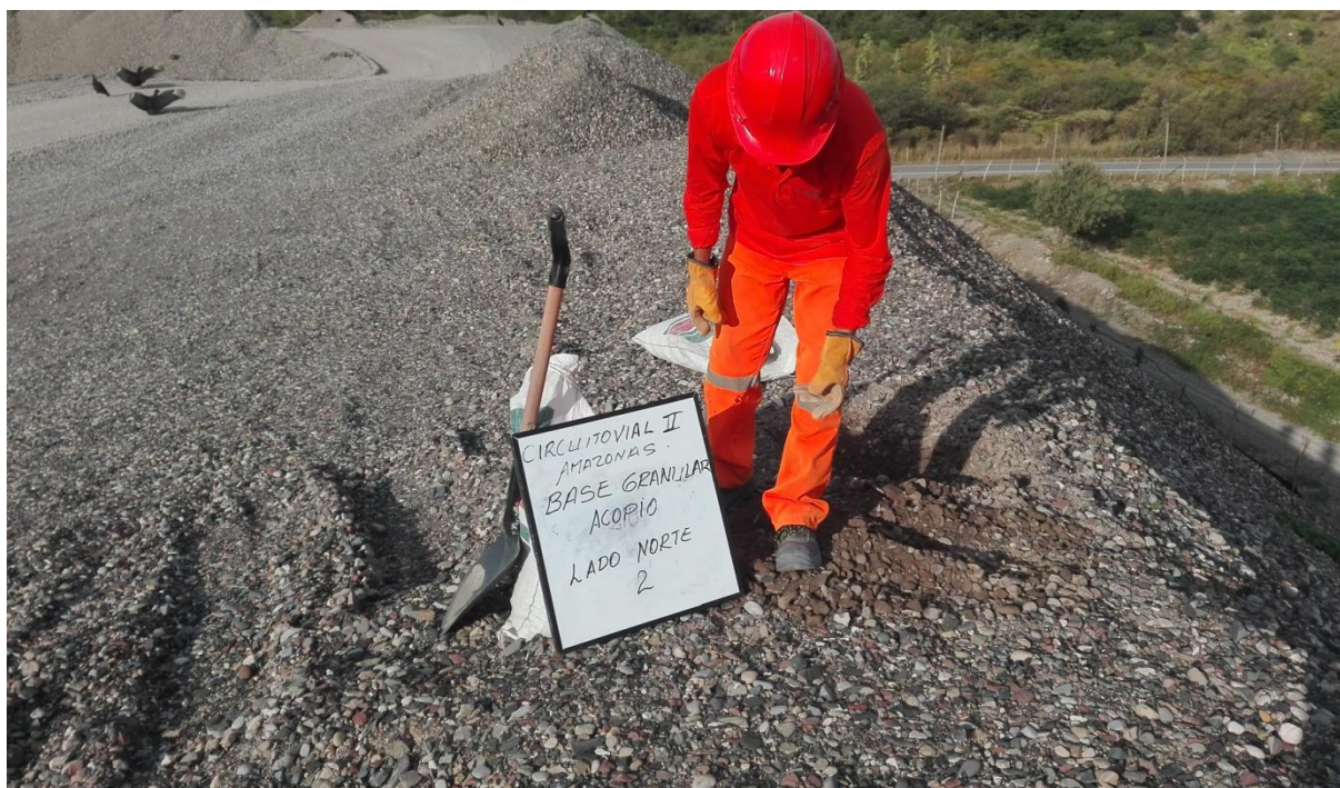
Figura 6. Vista donde se observa el muestreo del material de Base granular en Acopio
