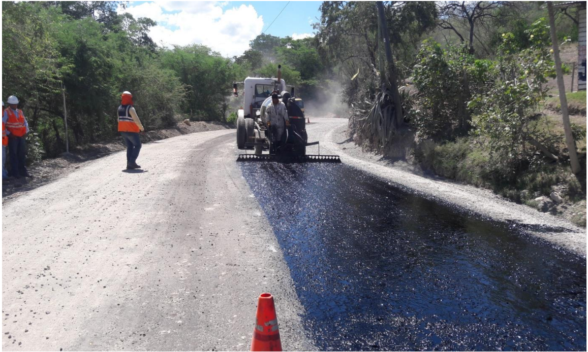
Figura 8. Vista donde se observa el regado del material bituminoso.
