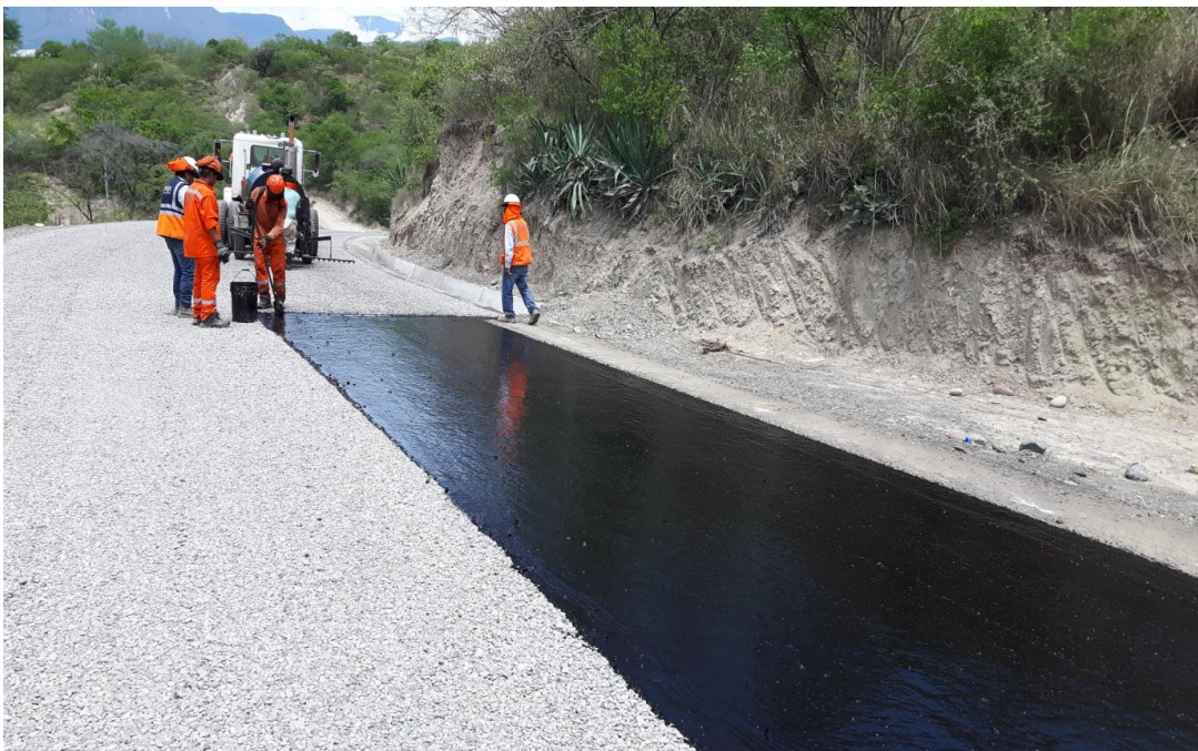
Figura 9. Vista donde se observa el regado del agregado de primera capa Del T.S.B
