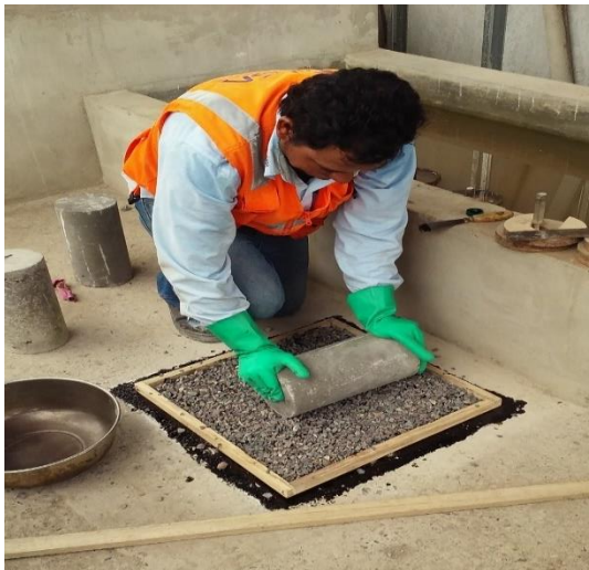
Figura 12. Aplicación del primer riego y 1era capa agregados
