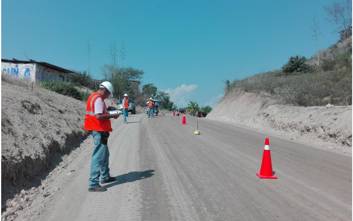
Figura 7. Vista donde se observa la prueba de compactación a nivel de base granular, método densímetro nuclear
