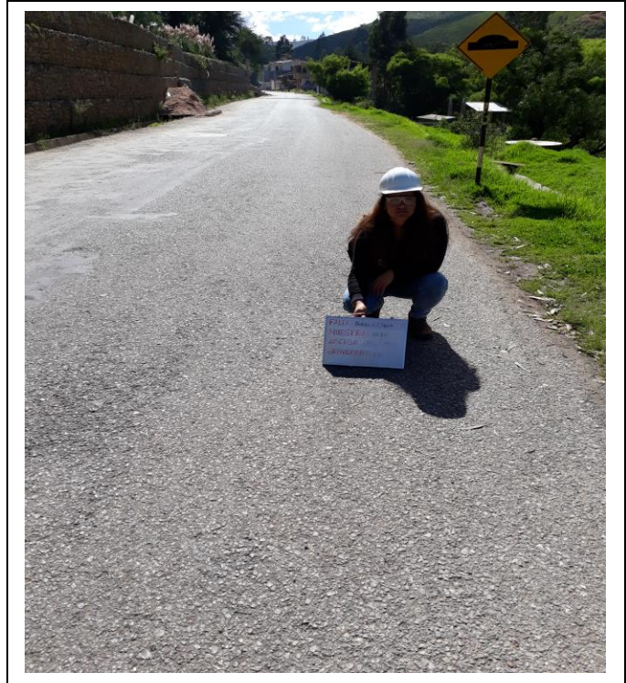
Foto N° 54: MUESTRA N°82 PÉRDIDA DE LA PELÍCULA DEL LIGANTE- GRAVEDAD: 1 - ABCISA: 03+037.50
