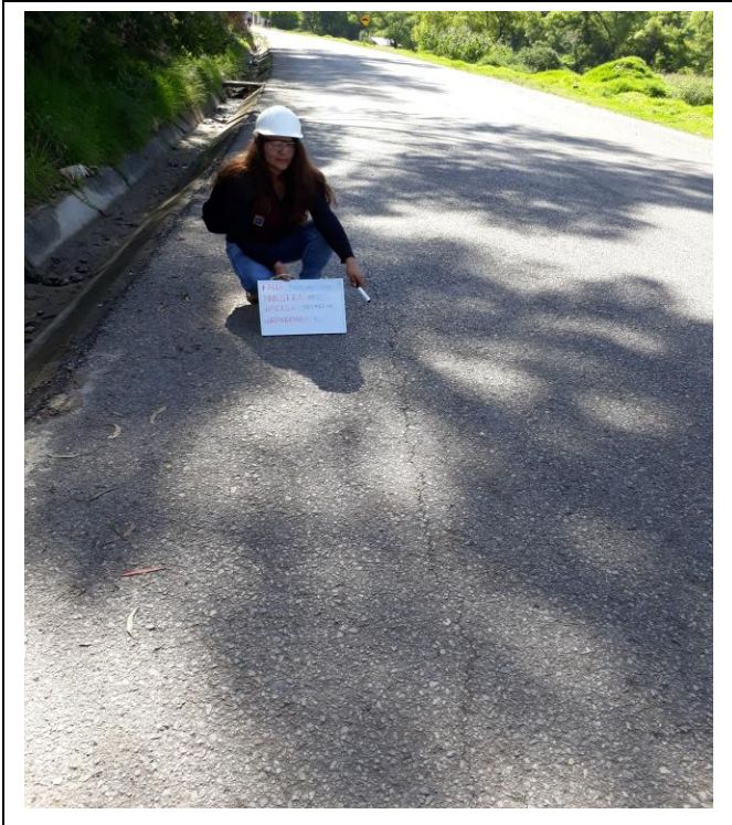
Foto N° 53: MUESTRA N°80 PÉRDIDA DE LA PELÍCULA DEL LIGANTE- GRAVEDAD: 1 - ABCISA: 02+925
