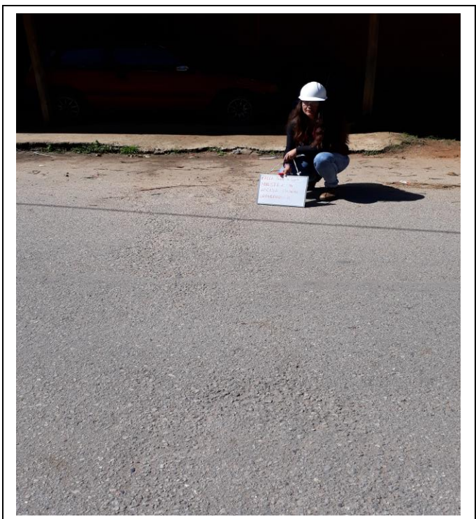
Foto N°58: MUESTRA N°86 PÉRDIDA DE LA PELÍCULA DEL LIGANTE- GRAVEDAD: 1 -ABCISA: 03+210.93
