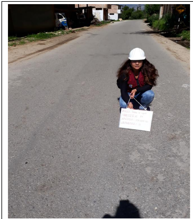
Foto N°59: MUESTRA N°87 PÉRDIDA DE LA PELÍCULA DEL LIGANTE- GRAVEDAD: 1 - ABCISA: 03+225.00
