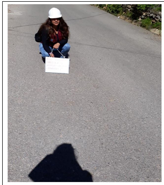
Foto N° 67: MUESTRA N°95 PÉRDIDA DE LA PELÍCULA DEL LIGANTE- GRAVEDAD: 1-ABCISA: 03+525.00
