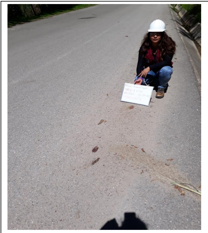
Foto N° 99: MUESTRA N°110 PÉRDIDA DE LA PELÍCULA DEL LIGANTE- GRAVEDAD: 1 - ABCISA: 04+087.50
