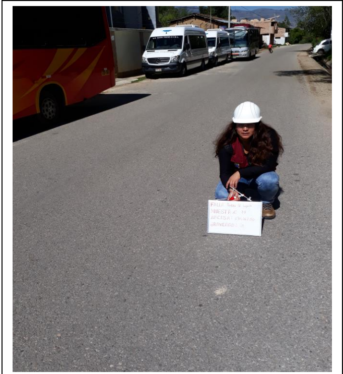
Foto N° 60: MUESTRA N°88 PÉRDIDA DE LA PELÍCULA DEL LIGANTE- GRAVEDAD: 1 -ABCISA: 03+262.50
