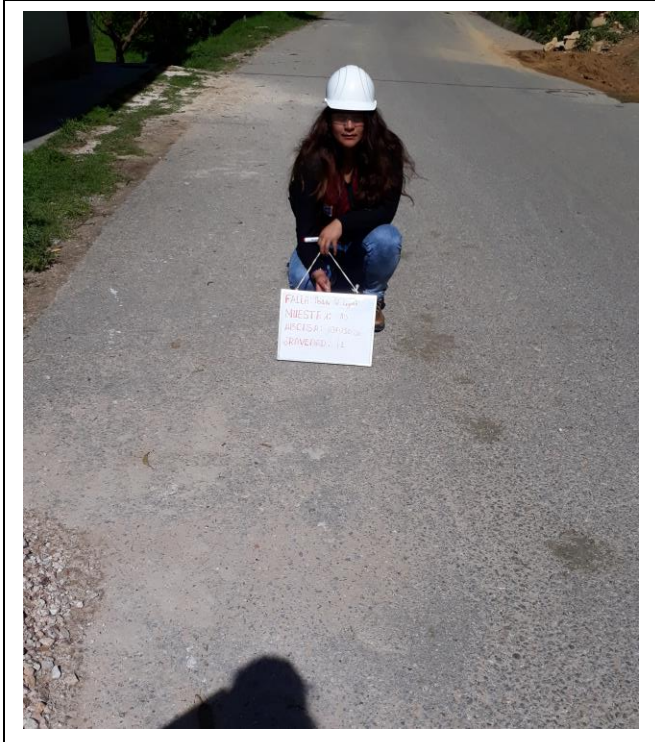
Foto N° 57: MUESTRA N°85 PÉRDIDA DE LA PELÍCULA DEL LIGANTE- GRAVEDAD: 1 - ABCISA: 03+150.00
