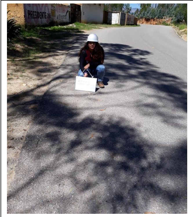
Foto N° 95: MUESTRA N°104 PÉRDIDA DE LA PELÍCULA DEL LIGANTE- GRAVEDAD: 1 - ABCISA: 03+883.50
