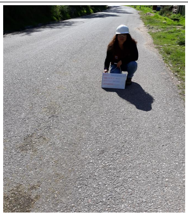
Foto N°52: MUESTRA N°79 PÉRDIDA DE LA PELÍCULA DEL LIGANTE- GRAVEDAD: 1 -ABCISA: 02+925
