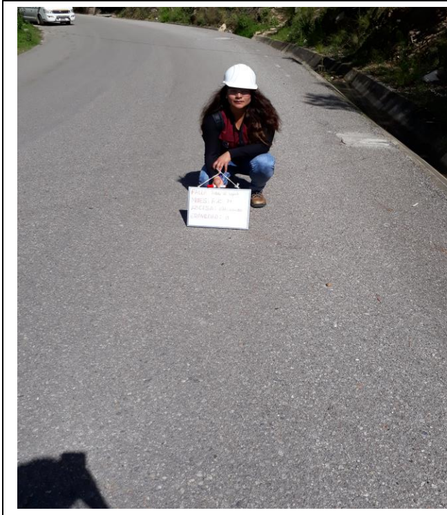
Foto N° 61: MUESTRA N°89 PÉRDIDA DE LA PELÍCULA DEL LIGANTE- GRAVEDAD: 1 - ABCISA: 03+300.30
