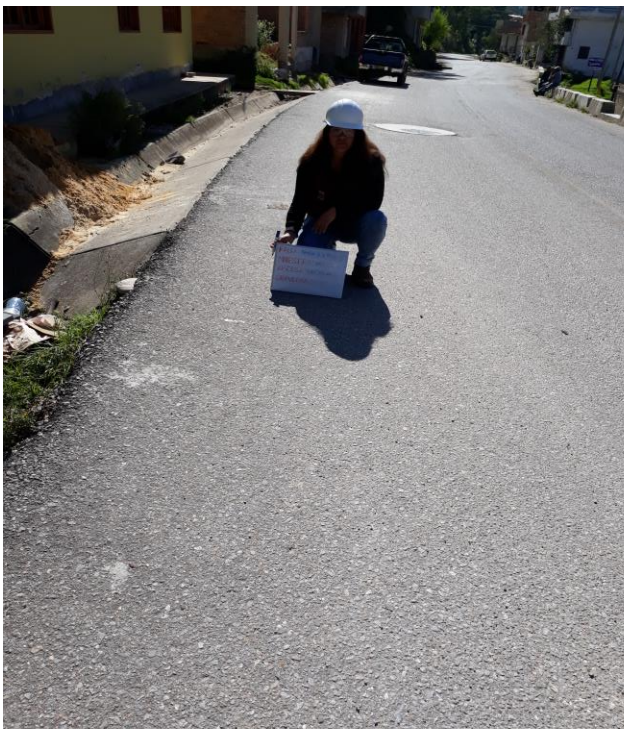
Foto N° 47: MUESTRA N°73 PÉRDIDA DE LA PELÍCULA DEL LIGANTE- GRAVEDAD: 1 - ABCISA: 02+700.00
