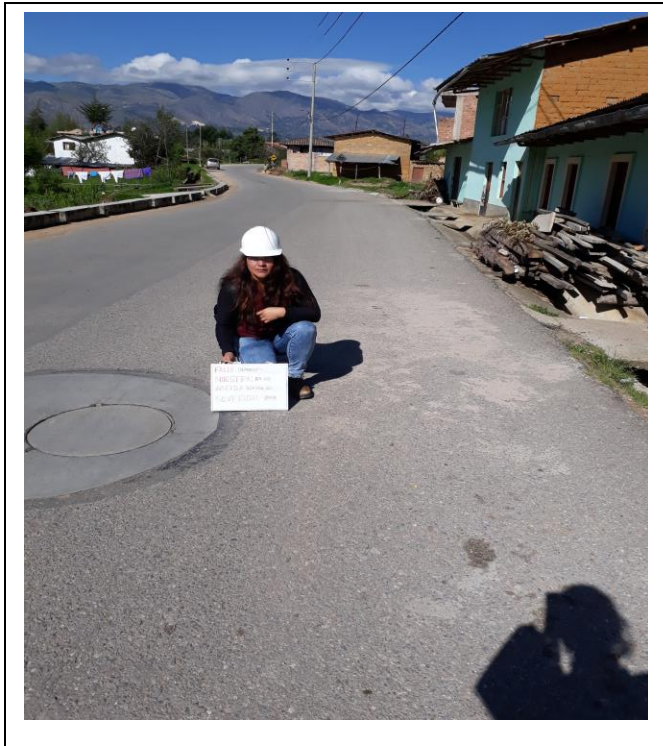
Foto N° 41: MUESTRA N°65 DEPRESIÓN- SEVERIDAD: BAJA-ABCISA: 02+406.20
