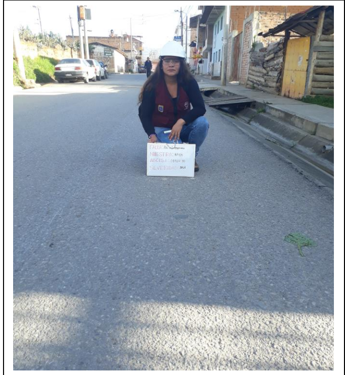
Foto N° 10: MUESTRA N°04 PELADURA POR INTEMPERISMO Y DESPRENDIMIENTO DE AGREGADOS- SEVERIDAD: BAJA-ABCISA: 00+112.50
