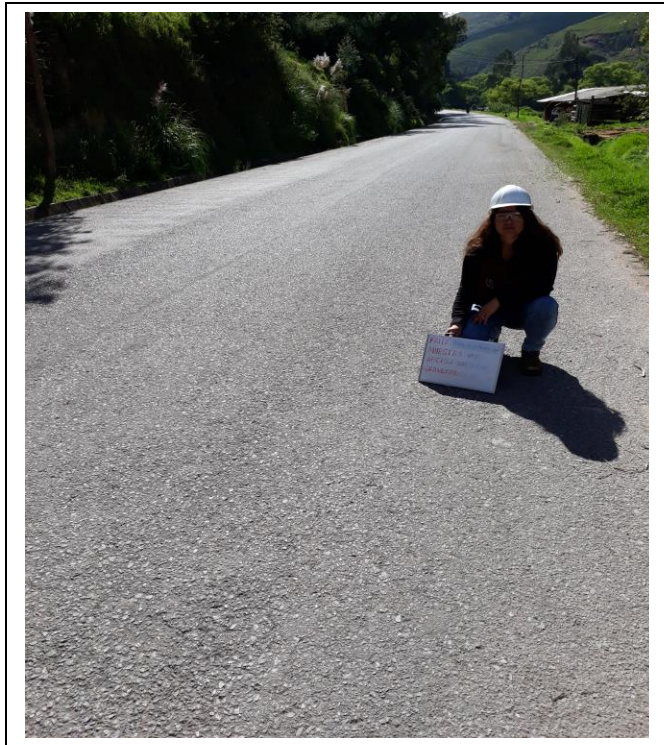
Foto N° 51: MUESTRA N°78 PÉRDIDA DE LA PELÍCULA DEL LIGANTE- GRAVEDAD: 1 - ABCISA: 02+887.50
