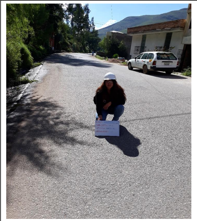
Foto N° 49: MUESTRA N°76 PÉRDIDA DE LA PELÍCULA DEL LIGANTE- GRAVEDAD: 1 - ABCISA: 02+812.50
