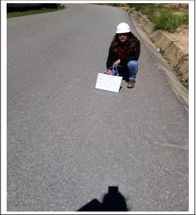
Foto N° 94: MUESTRA N°103 PÉRDIDA DE LA PELÍCULA DEL LIGANTE- GRAVEDAD: 1 -ABCISA: 03+825.00
