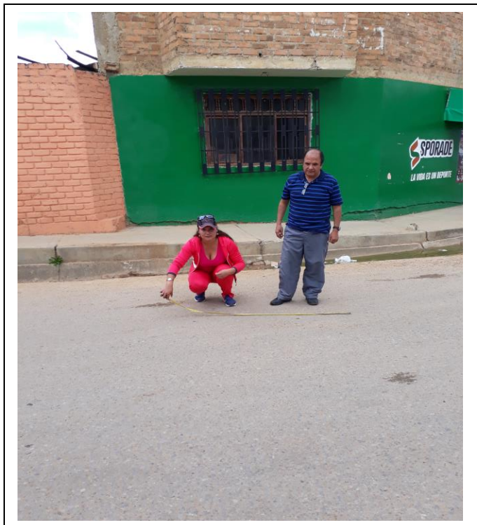
Foto N°06: VERIFICACIÓN DE LAS FALLAS JUNTO CON EL ASESOR
