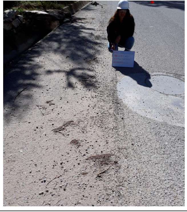
Foto N°50: MUESTRA N°77 PÉRDIDA DE LA PELÍCULA DEL LIGANTE- GRAVEDAD: 1 -ABCISA: 02+850.00
