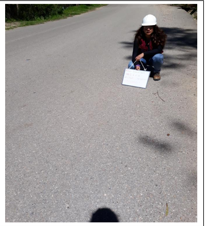
Foto N°100- MUESTRA N°111 PÉRDIDA DE LA PELÍCULA DEL LIGANTE- GRAVEDAD: 1 -ABCISA: 04+125.00
