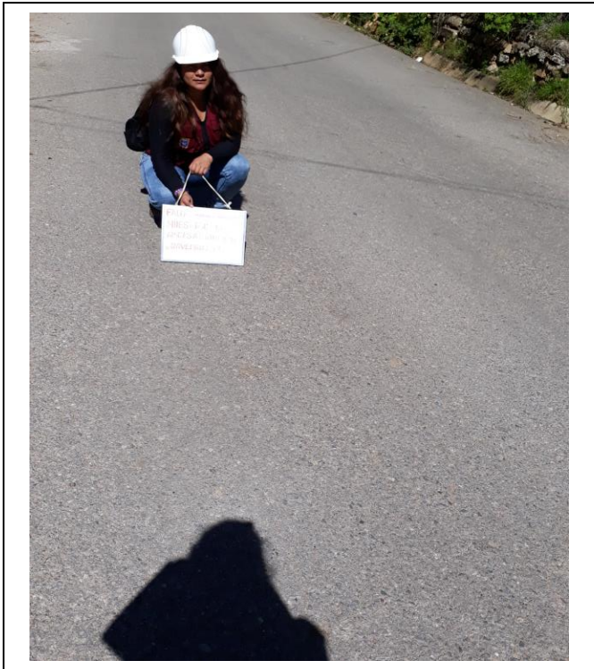
Foto N° 65: MUESTRA N° 93 PÉRDIDA DE LA PELÍCULA DEL LIGANTE- GRAVEDAD: 1- ABCISA: 03+459.40
