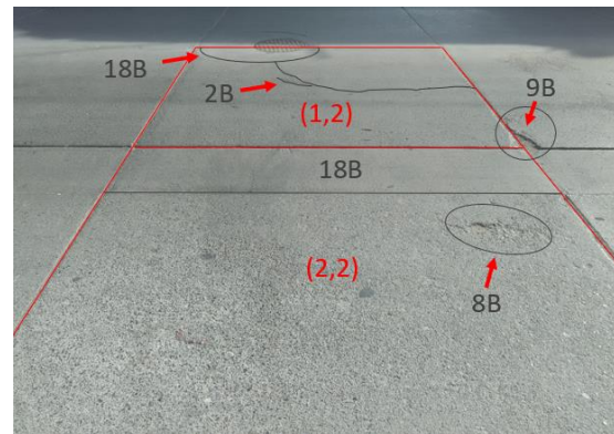
Fotografía 80: Losas (1,2)(2,2) de la unidad de muestra T1 – U26. Fecha: 22/09/2017.
