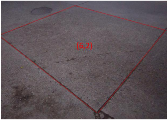
Fotografía 41: Pulimiento de superficie en Losa (6,2) de la unidad de muestra T1 – U01. Fecha: 11/05/2017.
