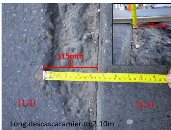
Fotografía 63: Descascar. de junta de severidad media en losa (1,3) de la unidad de muestra T1 – U13. Fecha: 11/05/2017.
