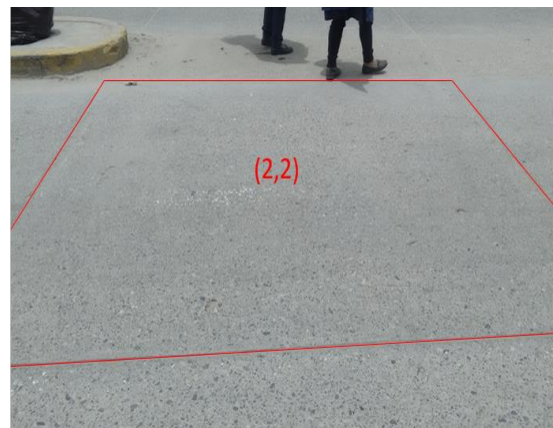
Fotografía 16: Pulimiento de superficie de losa (2,2) de la unidad de muestra T2 – U08. Fecha: 10/03/2017.
