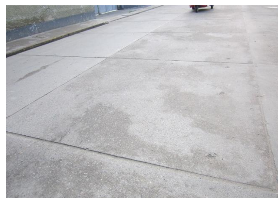
Fotografía 36: Últimas losas de la unidad de muestra T2-U25, donde sólo el carril interior tiene pulimiento de superficie. Fecha: 10/03/2017.
