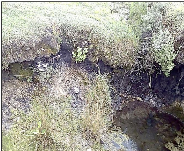
Figura 24. Aporte de agua subterránea. Descarga de agua subterránea a un cauce natural.
