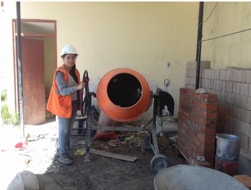
Figura 41: Fotografía de la Tesista elaborando la mezcla de concreto.
