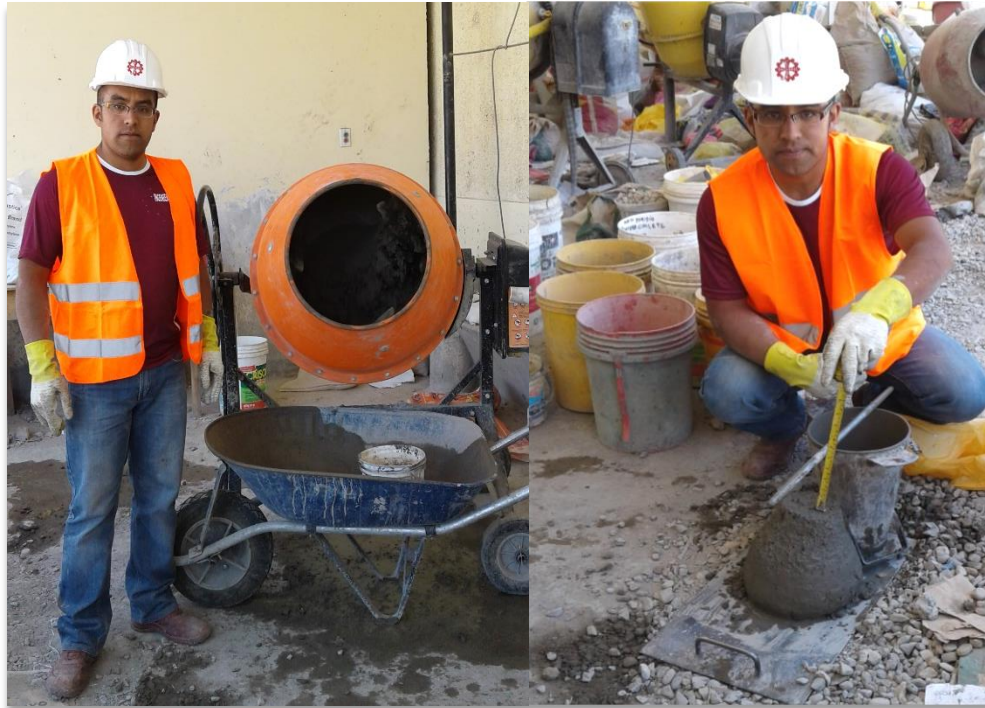
Imagen N° 12: Elaboración de la mezcla de concreto
