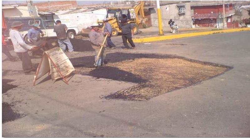
*Figura 2.2.5. Reparación de un bache.*
