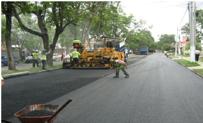
*Figura 2.2.9. Sobrecarpeta a base de concreto asfáltico sobre pavimento asfáltico.*
