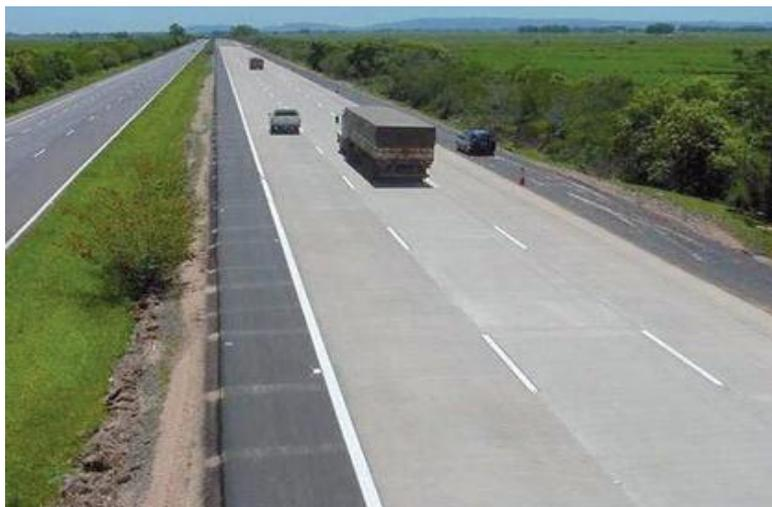
*Figura 2.2.8. Sobrecarpeta a base de losa de concreto hidráulico sobre pavimento asfáltico.*
