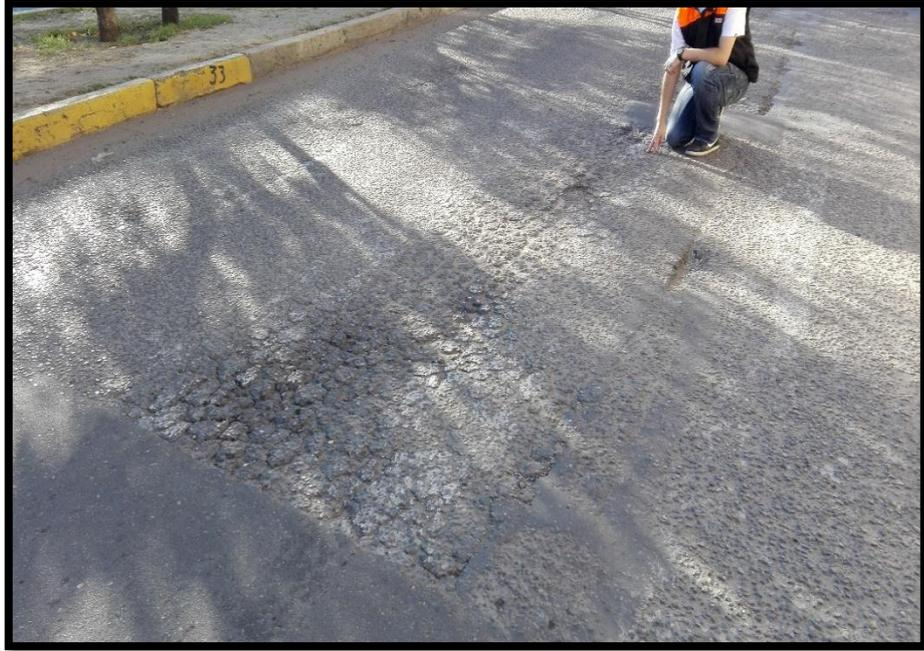
*Figura 0.5. Muestra de la gravedad de falla tipo piel de cocodrilo.*
