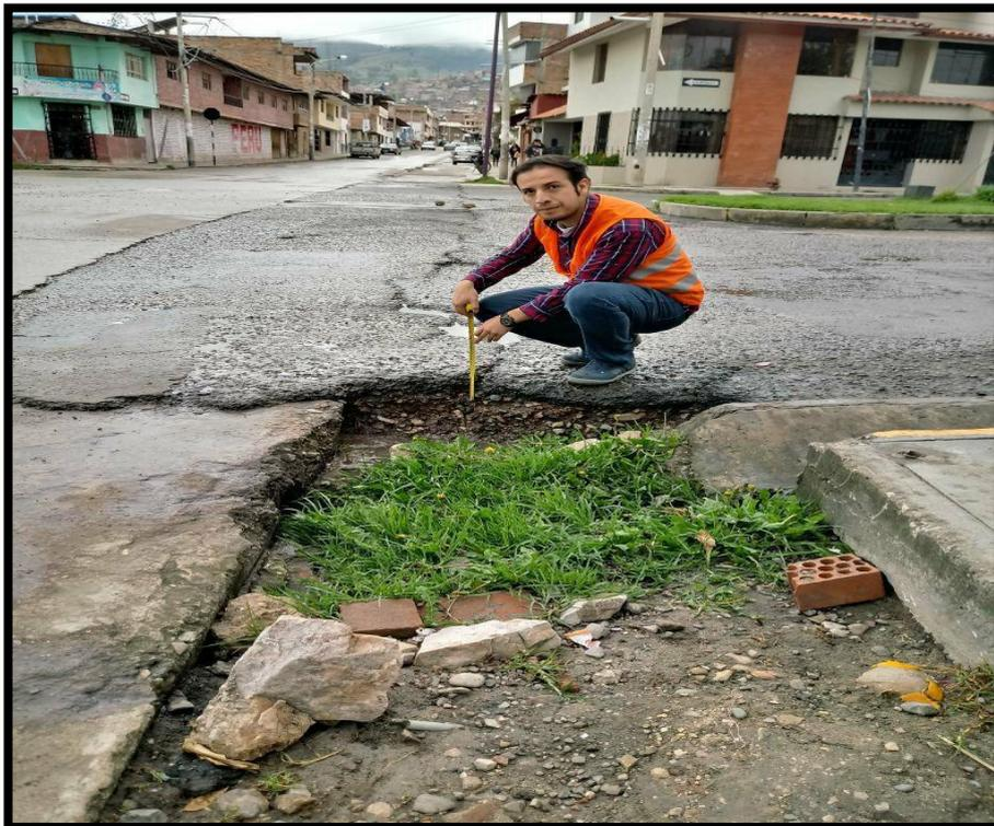
*Figura 0.4. Medición de las capas constituyentes del pavimento mostrándose en la abertura.*
