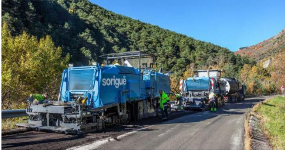
*Figura 2.2.7. Sistema de Reciclado en frío con emulsión asfáltica.*
