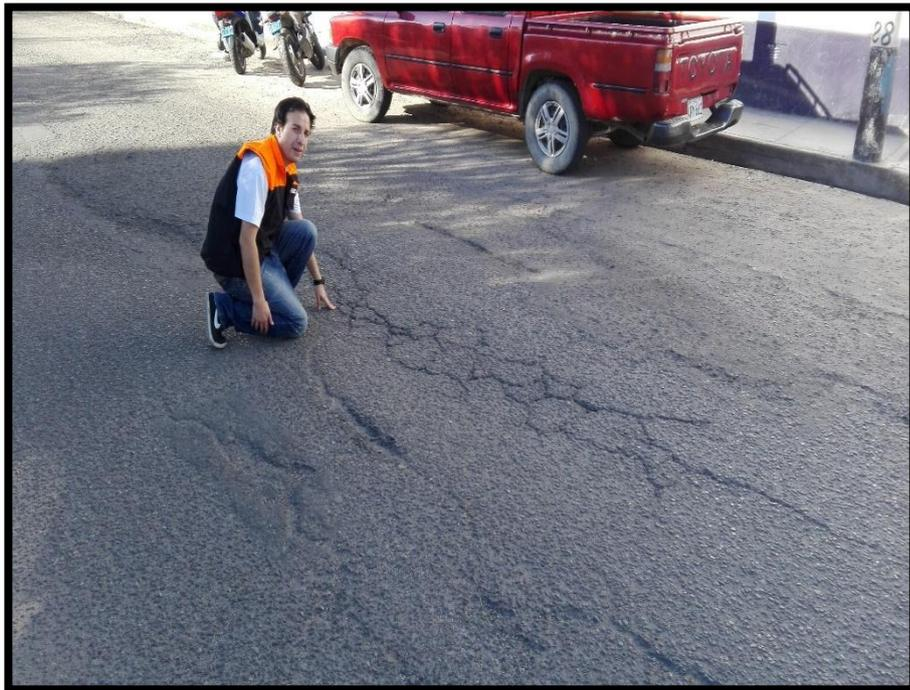
*Figura 0.6. Muestra de la gravedad de falla tipo grietas*
