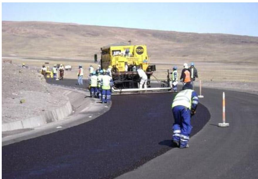
*Figura 2.2.6. Aplicación de Slurry Seal en obra.*
