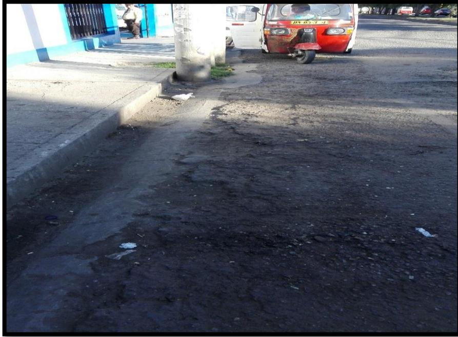
*Figura 0.7. Mal estado del pavimento en los bordes*
