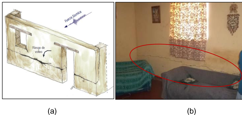
Figura 10: (a) Falla típica por Flexión en muros con esbeltez vertical. (b) Falla horizontal por flexión en vivienda de adobe, Ica 2007).
