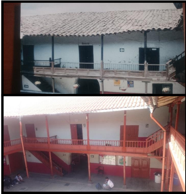
Cobertura de la edificación
