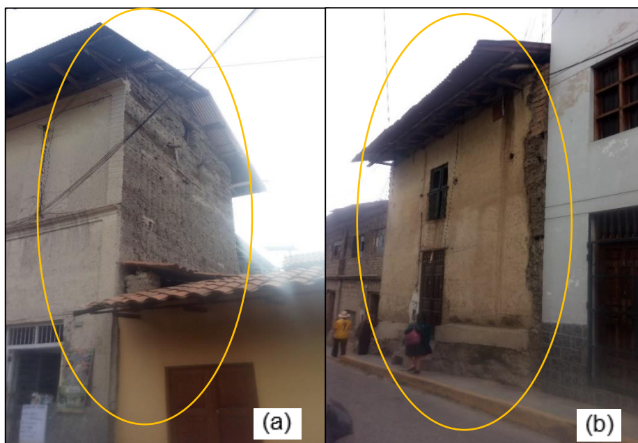
Figura 12: (a), (b) Muros esbeltos en edificaciones de adobe en el centro histórico Cajamarca.
