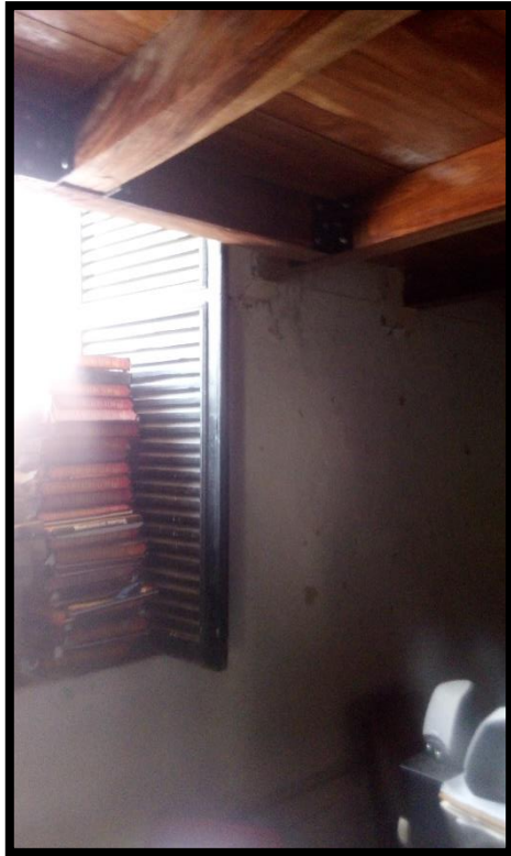
Habilitación de un nivel a media altura
