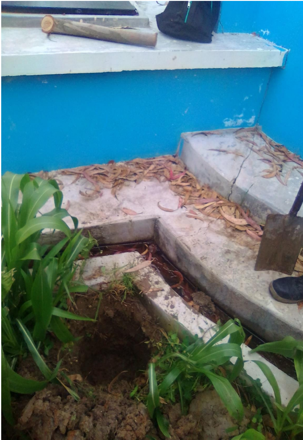
Excavación de calicata para sacar la muestra de suelo.
