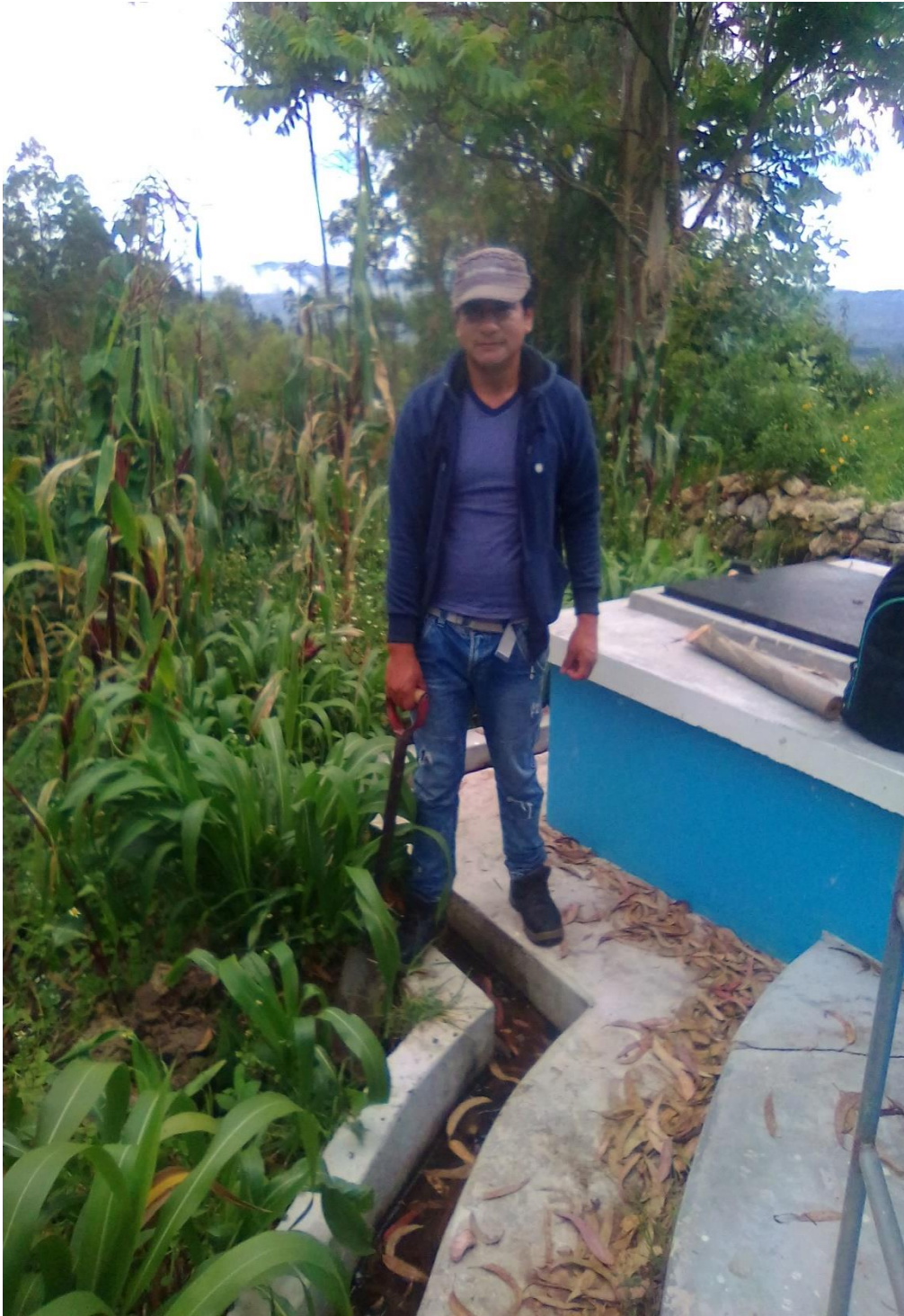
Lugar para excavación de calicata.
