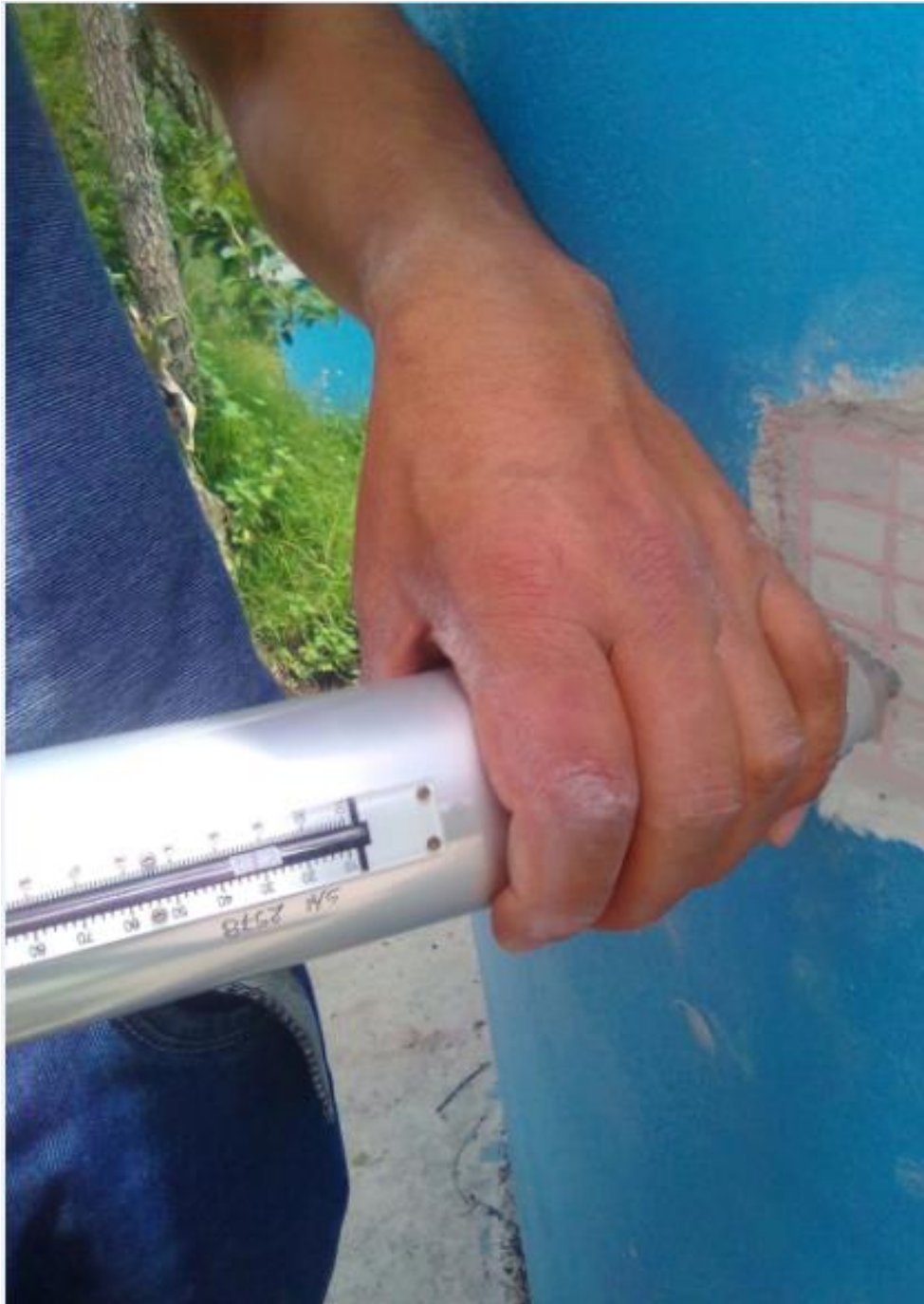
Registro de índice de rebote en el muro circular.
