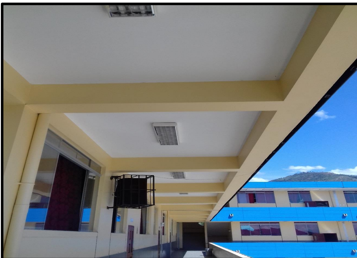
Fotografía N°04: Vista de las vigas en voladizo.
