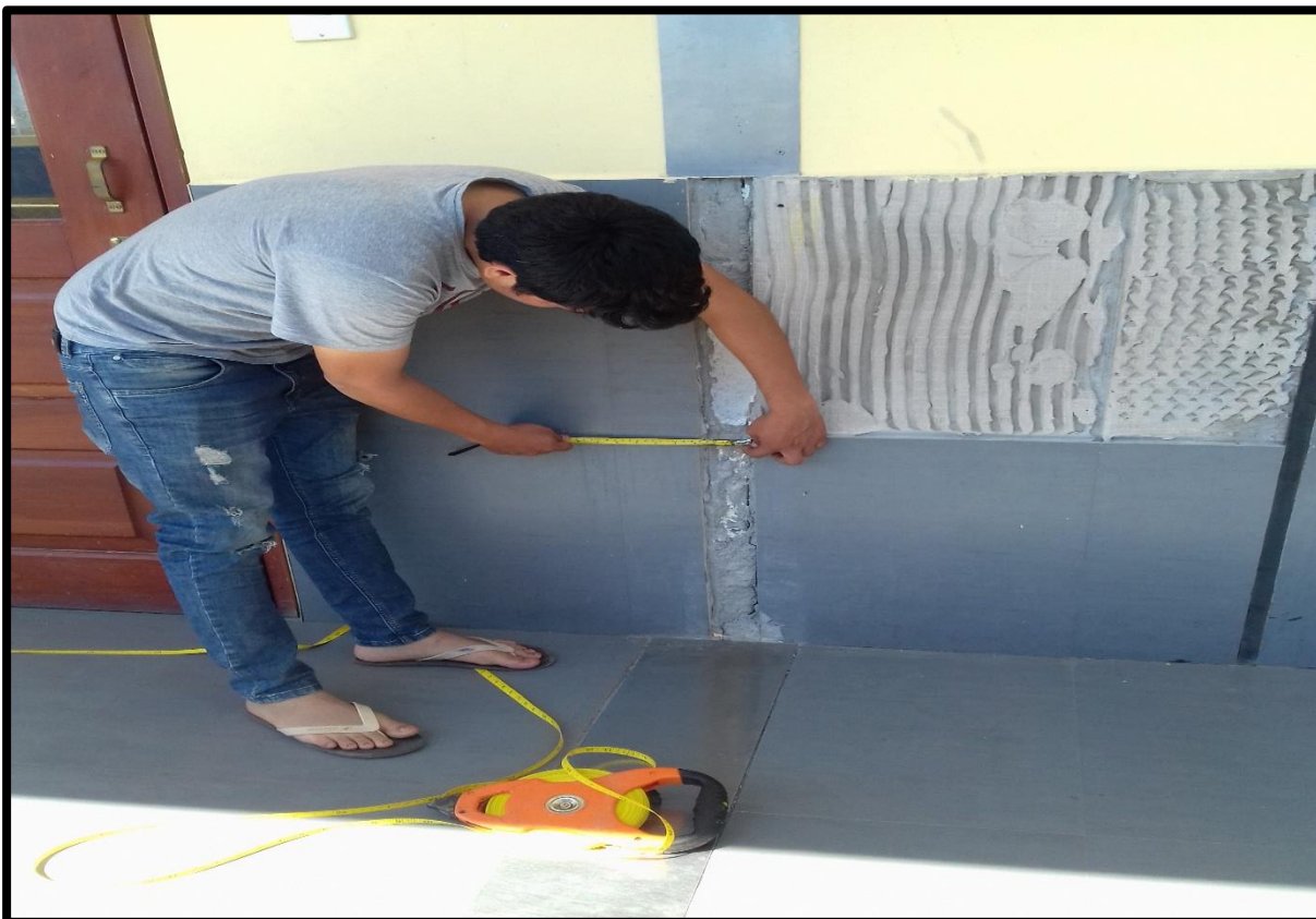
Fotografía N°02: Junta de espaciamento entre edificios 7cm.
