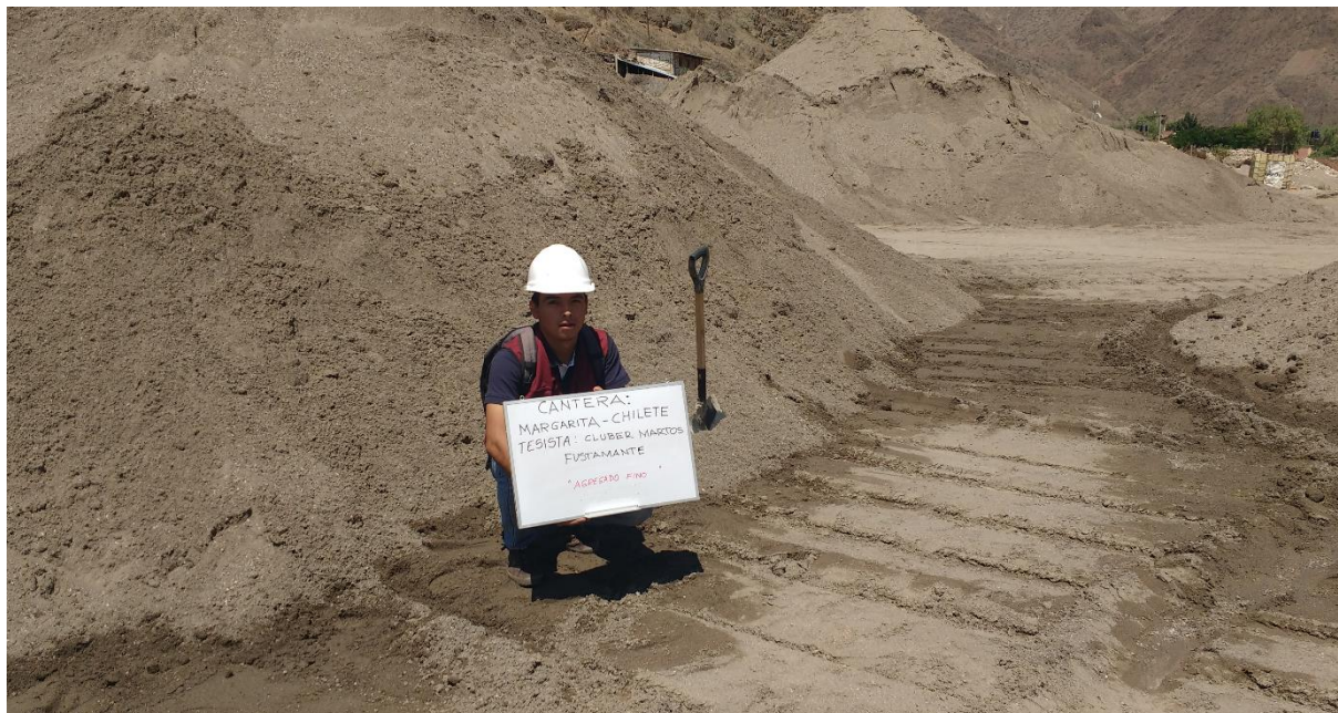
Figura 6.1. Inspección del agregado fino-cantera Margarita.
