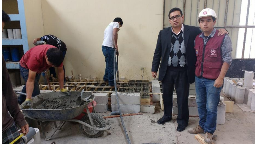
Figura 6.12. Inspección del Ing. Miguel Mosqueira Moreno, en el llenado y vibrado de vigas-1° etapa.
