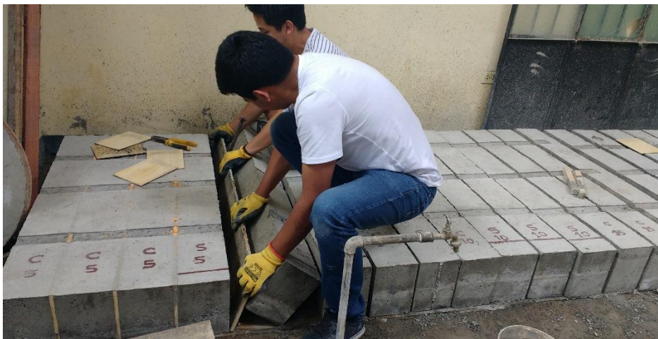
Figura 6.19. Desencofrado y codificación de vigas.
