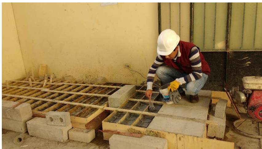
Figura 6.16. Aplicación de los adhesivos epóxicos a sus respectivas juntas.
