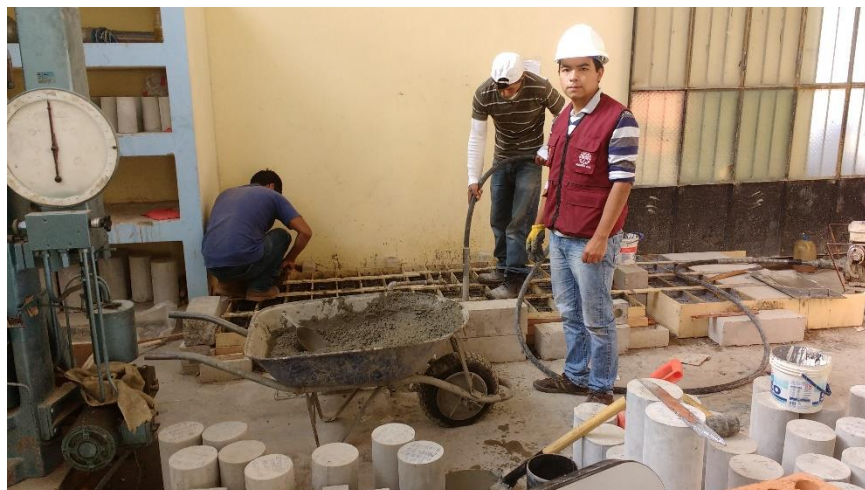
Figura 6.17. Llenado y vibrado de concreto-2° etapa.
