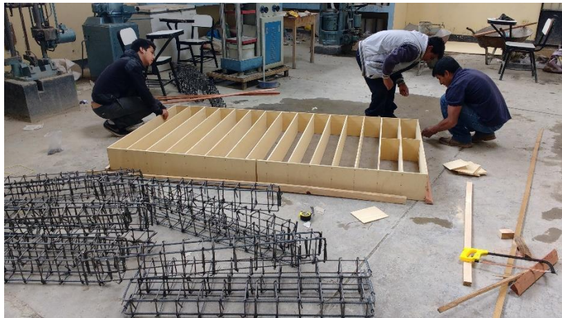
Figura 6.10. Encofrado y armaduras de las vigas a ensayar.
