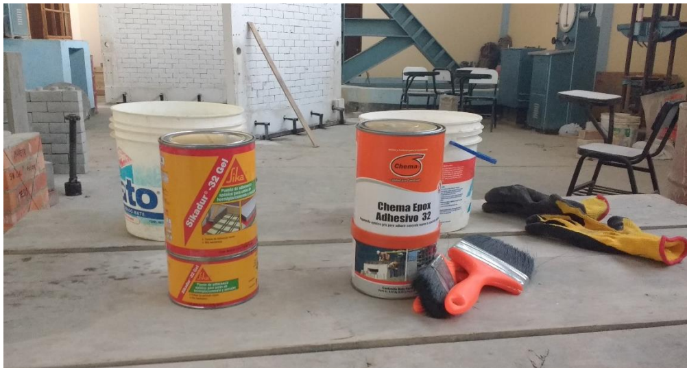
Figura 6.15. Aditivos epóxicos usados como puentes de adherencia.
