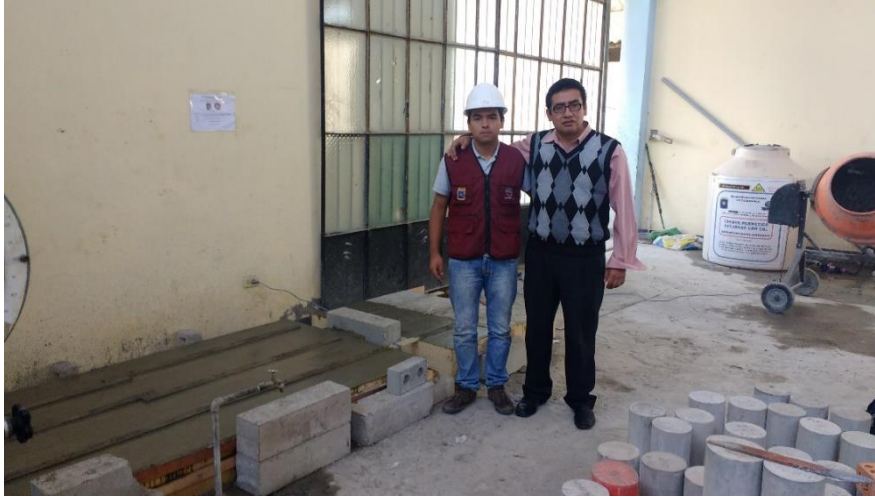
Figura 6.18. Inspección del Ing. Miguel Mosqueira Moreno, en el llenado y vibrado de vigas-2° etapa.
