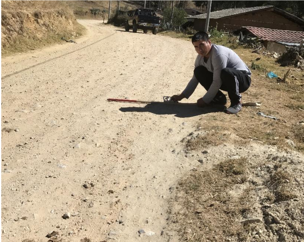
FOTOGRAFIA N° 07.- Se muestra la medición de la pendiente transversal de la carretera con eclímetro.
