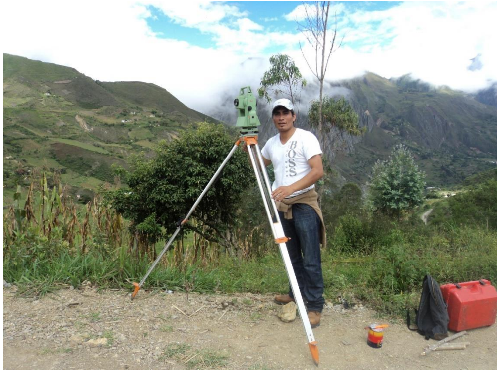
FOTOGRAFIA N° 02.- Equipo topográfico (estación Total), para realizar el levantamiento topográfico.
