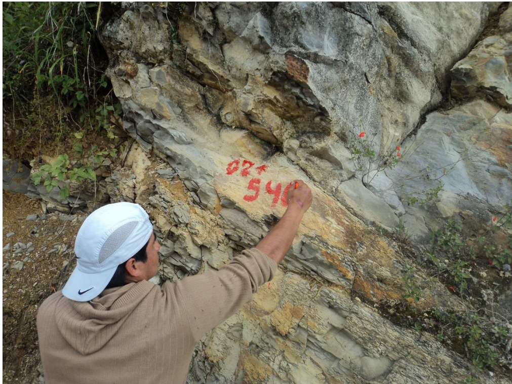
FOTOGRAFIA N° 03. -Colocando las medidas del kilometraje para poder realizar el levantamiento topográfico.
