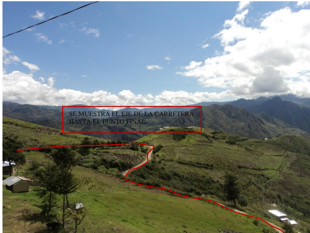
FOTOGRAFIA N° 06.- Se muestra el eje de la carretera en el punto final.
