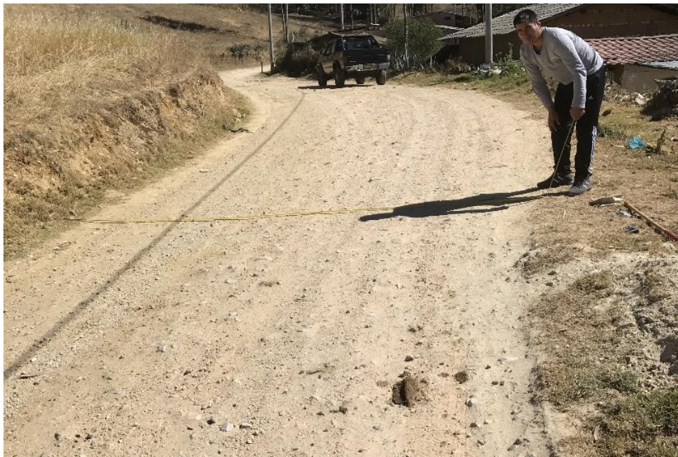
FOTOGRAFIA N° 08.- Se muestra la medición del ancho de la plataforma de la carretera.
