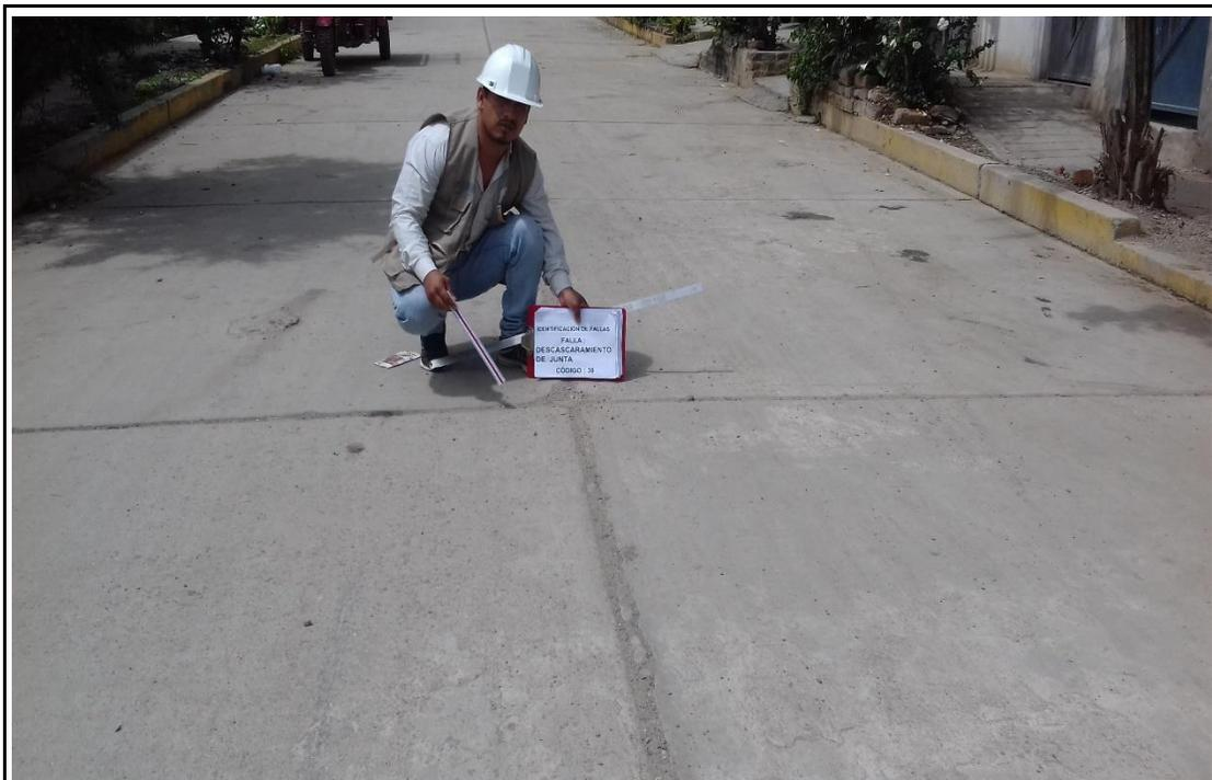
**Foto 45. UNIDAD DE MUESTRA N° 112.** Paño 120 presenta descascamiento de junta (39) de severidad leve.
