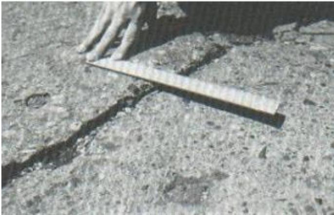
**Fig. 11.Escala de severidad alta**
