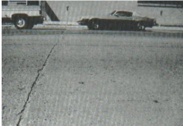
**Fig. 47. Descascaramiento de junta de severidad media.**
