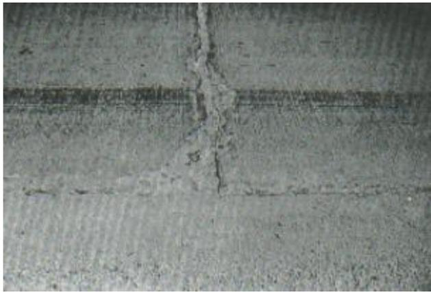
**Fig. 44.Descascaramiento de esquina de severidad alta.**
