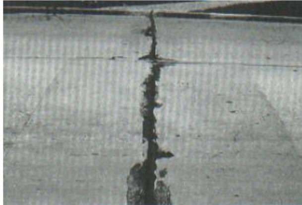
**Fig. 14. Daño del sello de junta de severidad media.**
