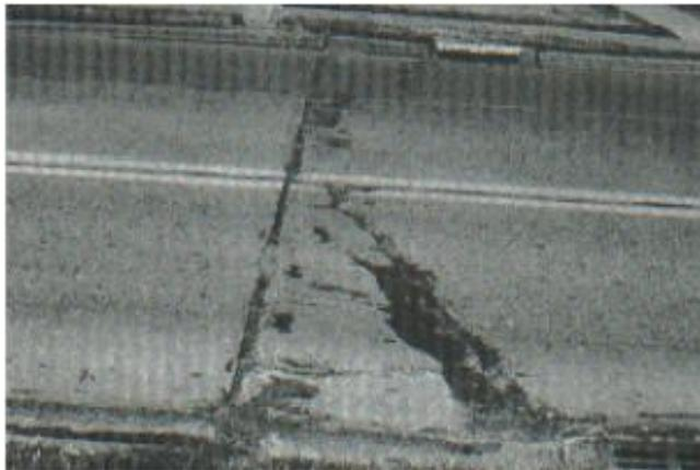
**Fig. 34. Punzonamiento de severidad alta.**
