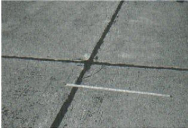
**Fig. 43.Descascaramiento de esquina de severidad media.**
