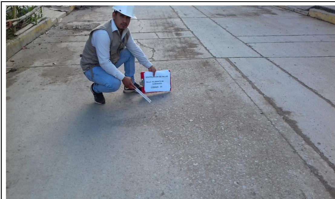
**Foto 33. UNIDAD DE MUESTRA N° 09:** Izq. Paño 93 presenta superficie pulimentada (31) de severidad leve
