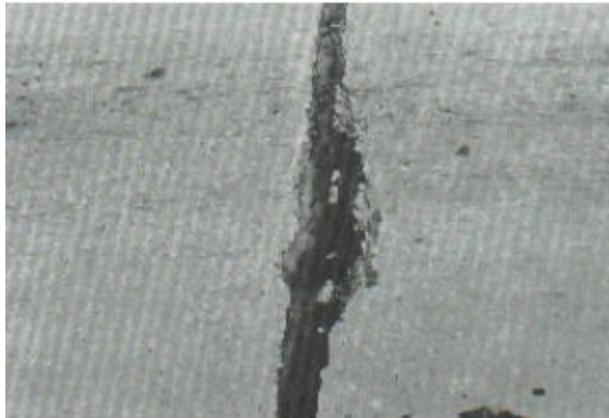
**Fig. 15. Daño del sello de junta de severidad alta.**
