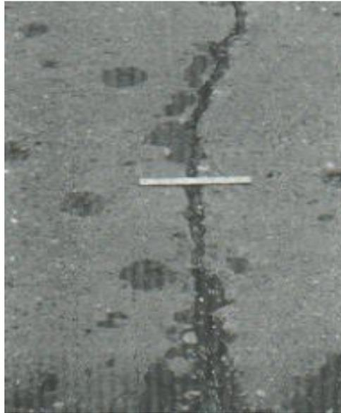
**Fig. 18. Grietas lineales de severidad alta en losa de concreto simple.**
