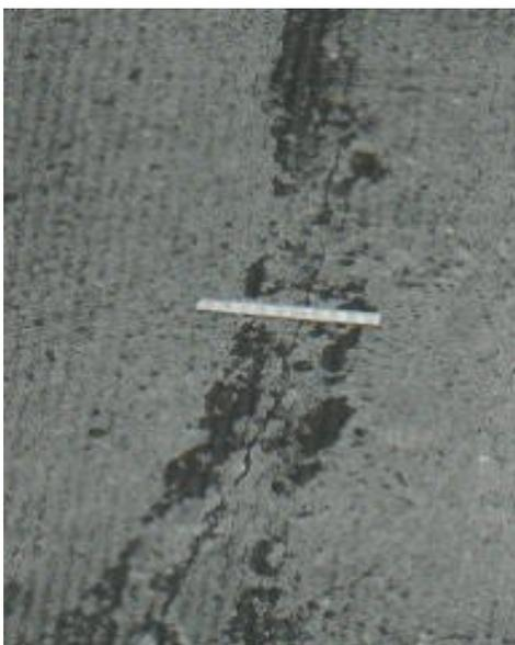
**Fig. 17. Grietas lineales de severidad media en losa de concreto reforzado.**
