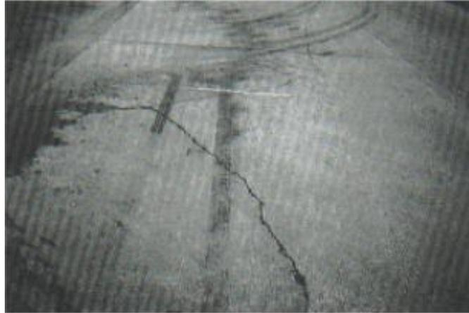
**Fig. 6. Losa dividida de severidad media.**
