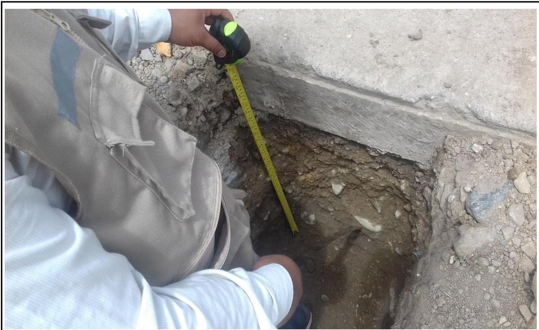
**Foto 50. CALICATA N° 01.** Medidas 1.00 x 0.80 m, profundidad 0.80m, conformado por losa = 0.20 m ; base (afirmado o granular) = 0.20m y sub rasante = 0.20m (over)
