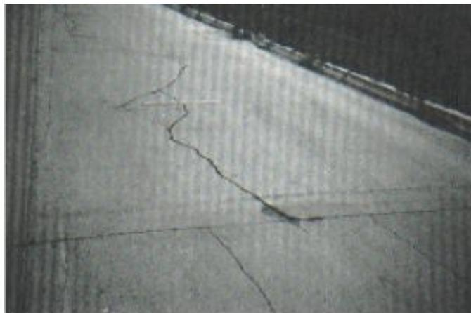
**Fig. 7. Losa dividida de severidad alta.**
