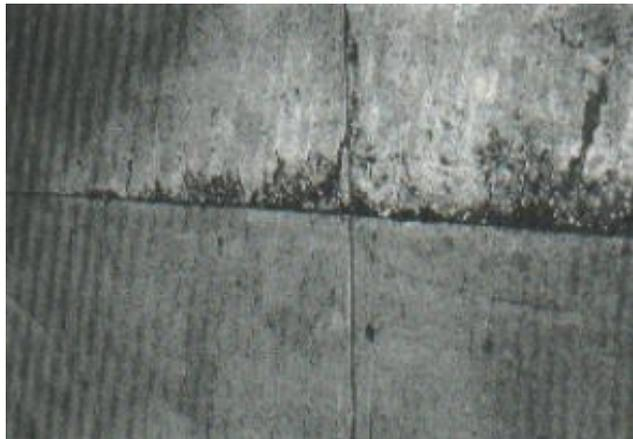
**Fig. 48. Descascaramiento de junta de severidad alta.**
