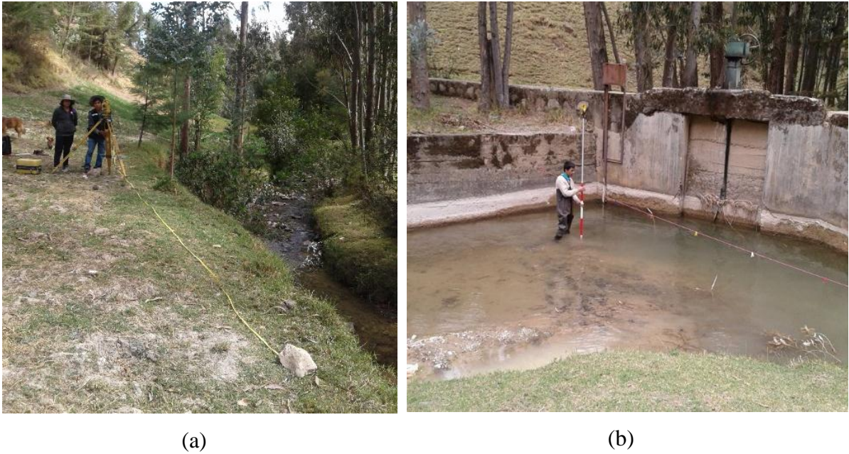
Figura 39. (a) Levantamiento topográfico del cauce de río Ronquillo y (b) batimetría del vaso formado por el barraje de la captación Ronquillo.
